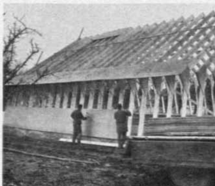
Abb. 110 Starrahmenbauweise
