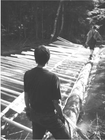
Abb. 114: Wiederaufrichten der vom Hochwasser umgeworfenen Brücke. (25.07.2007).
