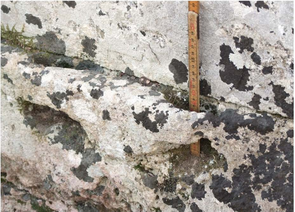
Abb. 56: Altar D, nördlicher Sockel mit eingearbeiteten Ösen.
