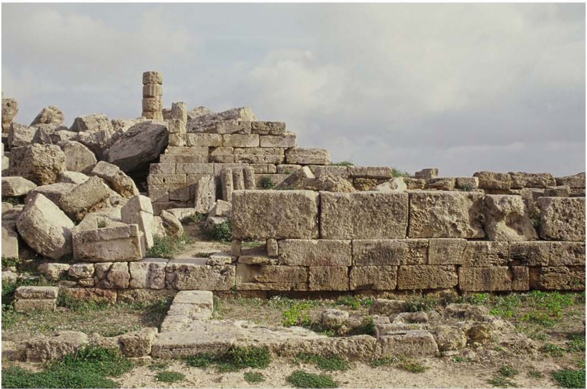
Abb. 41: sog. Südbau, Südwestecke mit Temenosmauer, Ansicht von Süden, im Hintergrund Tempel B und C.
