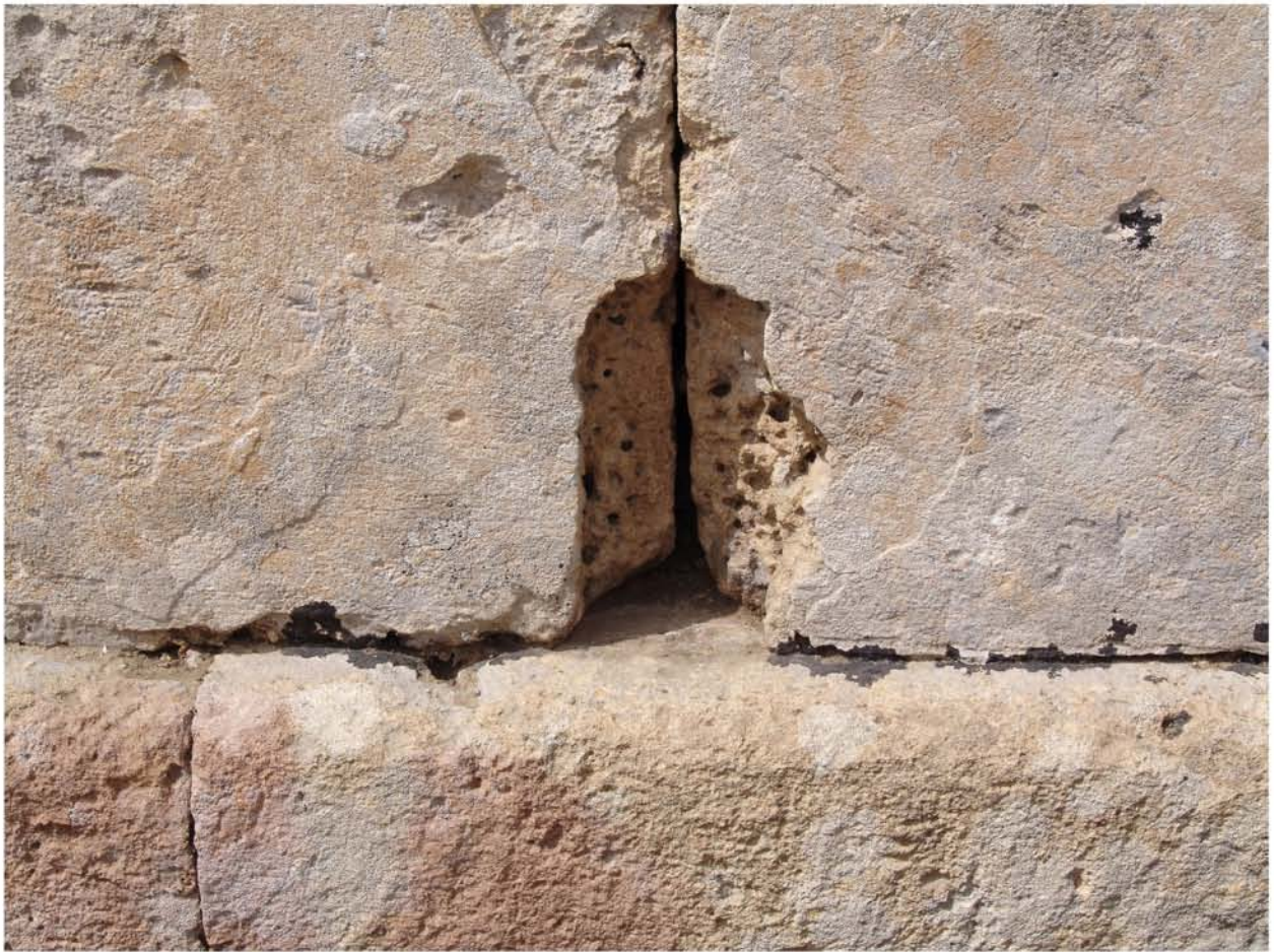
Abb. 54: Altar D, Ostseite, Orthostaten mit Flickung.
