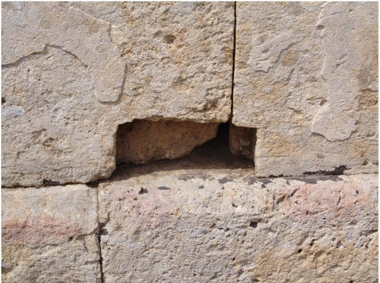
Abb. 55: Altar D, Ostseite, Orthostaten mit Flickung.
