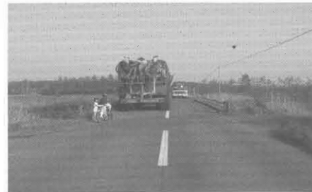
路肩幅が狭い農道
