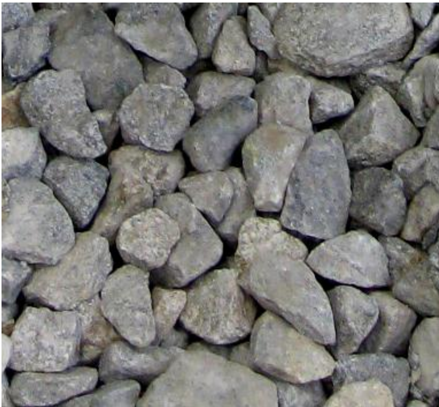
Bild 8: Schotter Typ A nach 5,4 Mio. Lw: Bei gleichen steifen Auflagerungsverhältnissen (Betonboden) fand unter der mit G04 V05 besohnten Schwelle kaum eine Änderung der Schotterqualität nach der Dauerbelastung statt, was die schonende Funktion der elastischen Sohle belegt.
