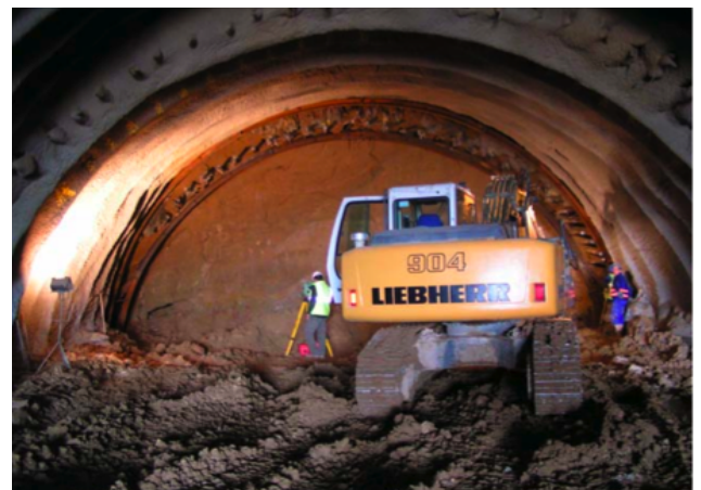
Abbildung 3.4: Aushub unter einem Rohrschirm (s. SCHMIDT (2007), Fig. 5-7, S. 12)
