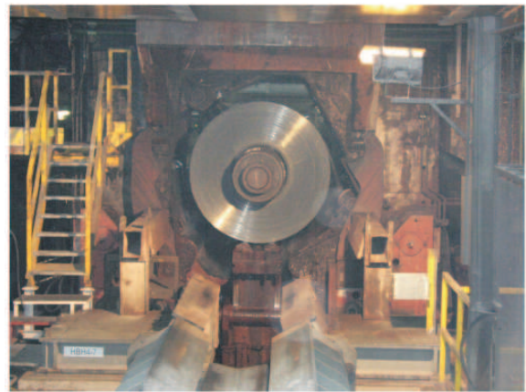
Abbildung 1.6: Haspelanlage der Warmbreitbandstraße voestalpine Stahl GmbH, Linz
