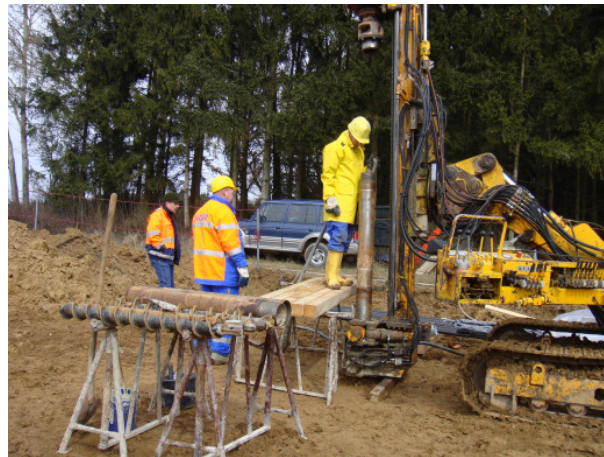
Abbildung 4.2: Verfüllen mit Zementsuspension
