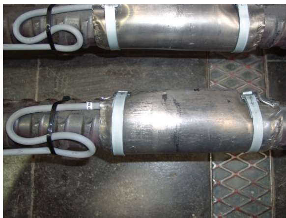
Abbildung 4.21: Ummantelung mit Walzblei
