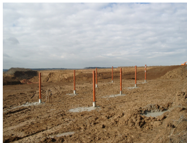
Abbildung 4.4: Versuchsfeld nach Pfahlherstellung, Schutz der Stähle mit KG-Rohren
