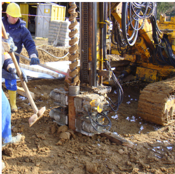
Abbildung 4.1: Bohren mit Außenverrohrung und Innenschnecke
