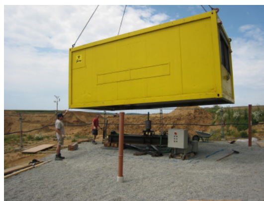
Abbildung 4.13: Schutz des Versuchsaufbaus mit Baucontainer
