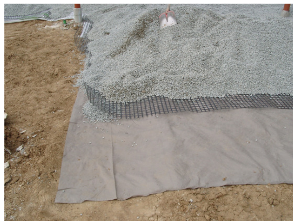
Abbildung 4.8: Dreischichtaufbau Arbeitsplanum
