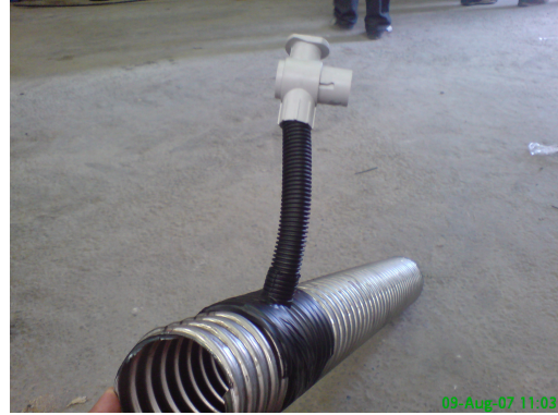
B) Verbindung zwischen Ventil und Hüllrohr
