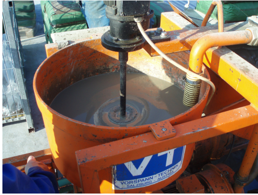
Abbildung 5.1: Einpressmörtel auf der Baustelle; links: Mischvorgang (Vorratsbehälter); rechts: Einpressvorgang (Austrittsöffnung) [Bilder 2007, F. Al Atiki]
