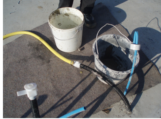
Abbildung 5.1: Einpressmörtel auf der Baustelle; links: Mischvorgang (Vorratsbehälter); rechts: Einpressvorgang (Austrittsöffnung) [Bilder 2007, F. Al Atiki]
