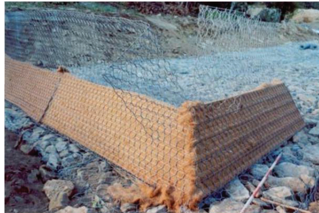
Bild 16: Rovarey, Damm zu Beginn der Bauarbeiten
