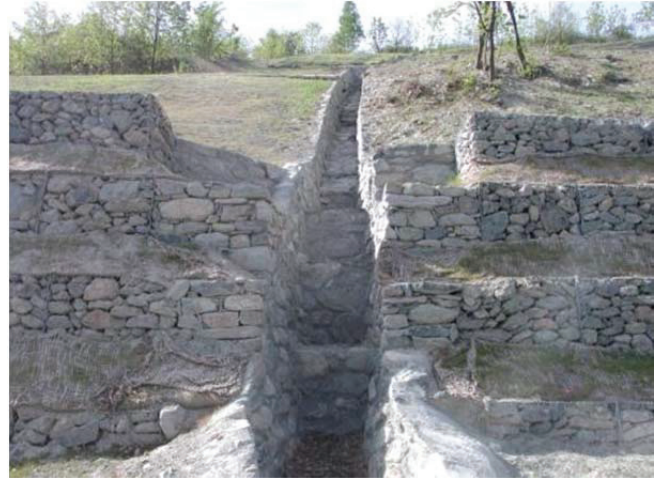
Abb. 13: Sicht auf Entwässerungskanal
