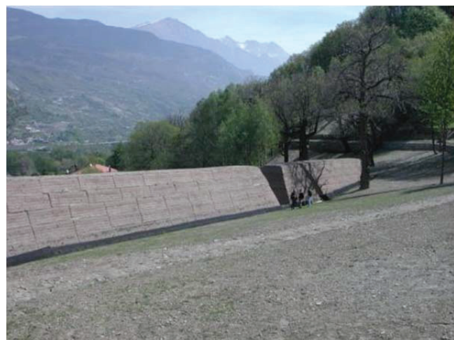
Abb. 18: Miseregne, Durchlassöffnungen zur Vermeidung eines Druckaufbaus
