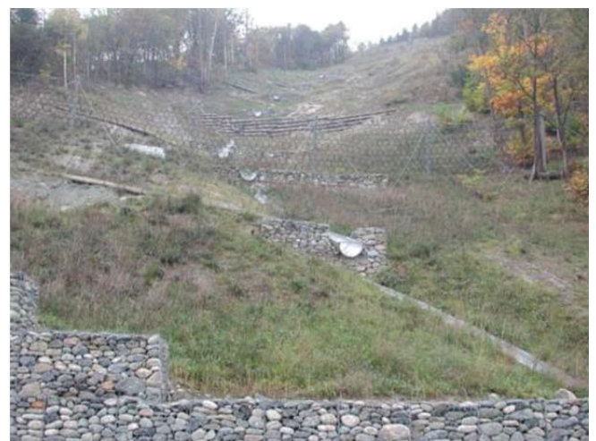
Abb. 6 : Ansicht einer flexiblen Steinschlagschutzbarriere
