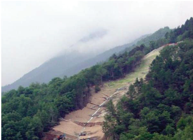
Abb. 7: Oberer Bereich des Konoids, Biologisch abbaubare Naturfasermatten in Verbindung mit einer Anspritzbegrünung
