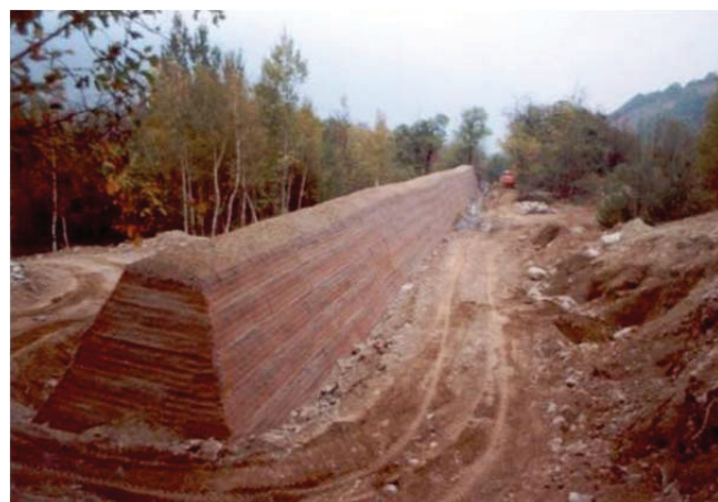
Bild 17: Rovarey, Damm am Ende der Bauarbeiten
