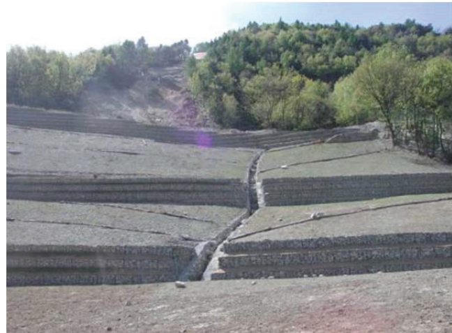
Abb. 9: Überblick Gabionenstützwände mit Drainagefunktion
