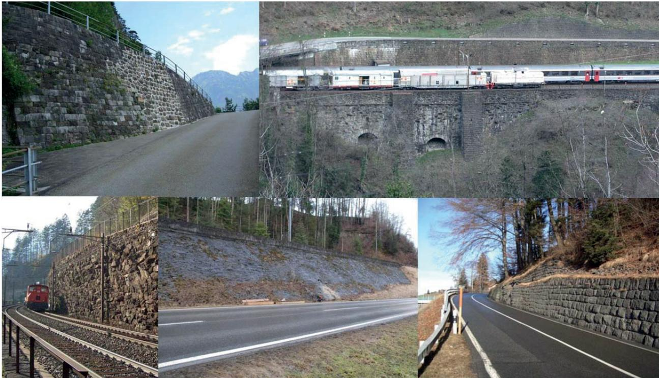
Abb. 1: Beispiele für die Verschiedenartigkeit der Stützbauwerke und ihres Mauerwerks aus Naturstein.
