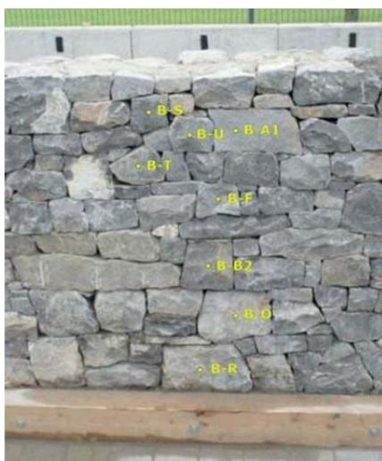
Abb. 8: Messpunkte der Durchschallungsmessungen am vermörtelten Mauerwerk, Teil B.
