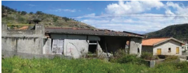
Abb. 1: Beispiel eines durch Kriechprozesse im Untergrund vollständig zerstörten Hauses im Untersuchungsgebiet
