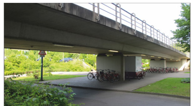
Bild 7: Außenansicht der Brücke Schießbergstraße in Leverkusen
