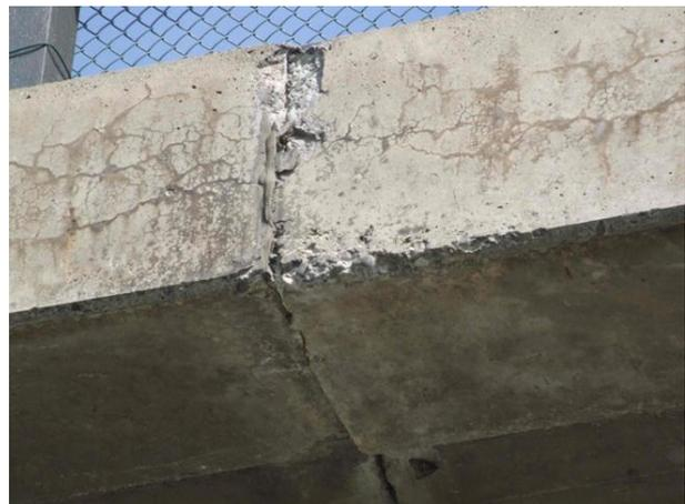
Abbildung 1: Verbrauchte Taumittelmenge in Deutschland, links (Statistik BAST aus [Bre12]); AKR-geschädigte Brückenkappe einer Autobahnüberführung im Sprühnebelbereich, rechts (Foto: D. Heinz)
