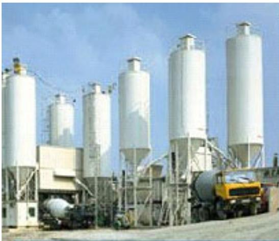
*Abb. 2.1: Betonwerk mit geneigten Schnecken zur Bindemittelförderung und -dosierung*
