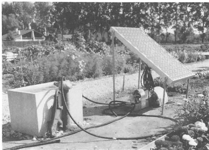
Abb. 3: Wasserförderung für eine Schrebergartenanlage mit einer kleinen Exzenterrollenpumpe, die über einen permanentmagneterregten Kollektor-Gleichstrommotor direkt vom Solargenerator (max. 144 W) betrieben wird.
