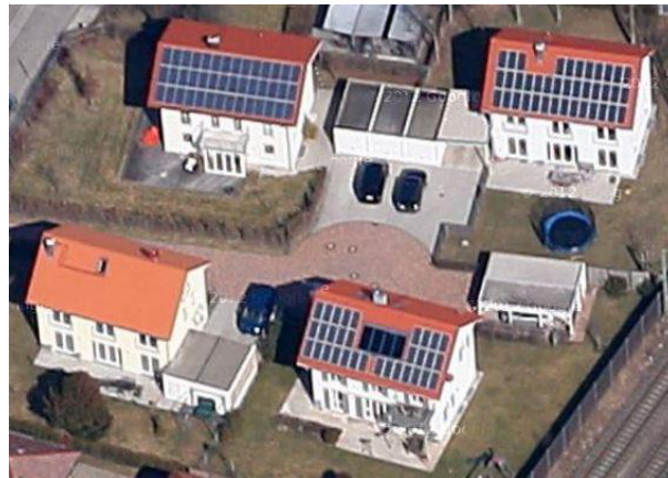
Abbildung 36: Dächer mit solarthermischen Anlagen als Anhaltspunkt für Fremdquellennutzung [Google Maps]
