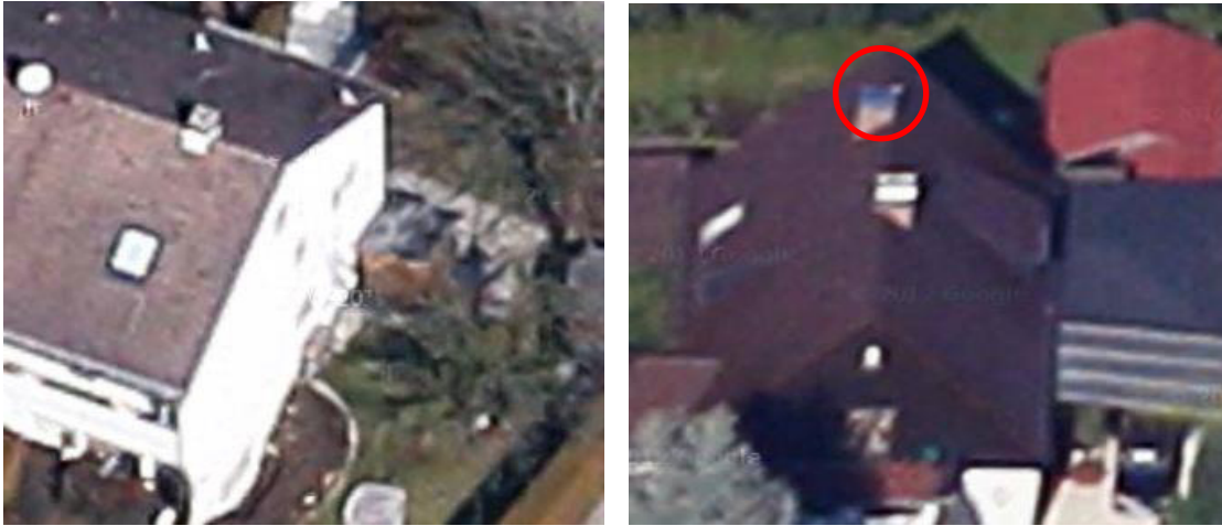
Abbildung 35: Links Holzschlag im Garten und rechts Gebäude mit stark verrostetem Kamin (roter Kreis) als Anhaltspunkte für Fremdquellennutzung [Google Maps]
