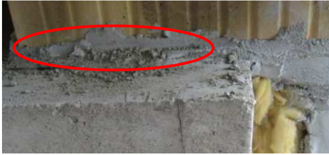
abnehmende Rissbildung / Fugenklaffung im WDK-Bereich
