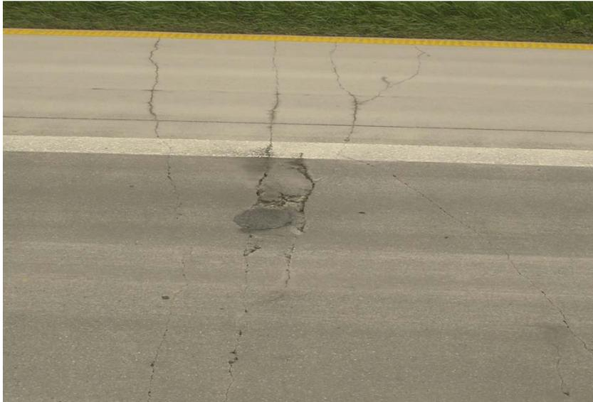
Abbildung 6-4: Punch-Out in durchgehend bewehrter Betondecke (Kretz)
