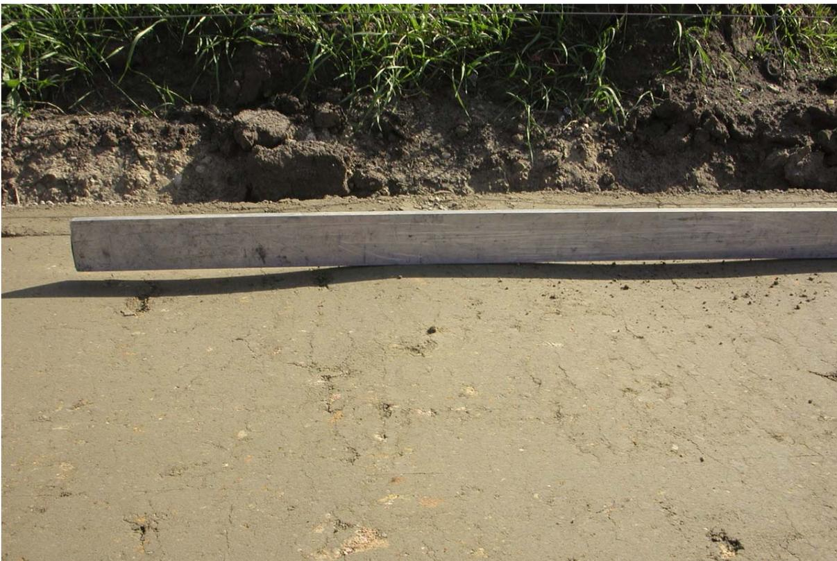
Abbildung 6-1: Unebenheiten in der hydraulisch gebundenen Tragschicht (Kretz)
