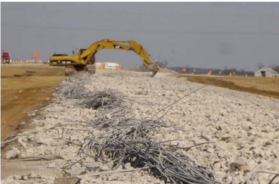
Abbildung 1-2: aufgebrochene durchgehend bewehrte Betondecke (Resonant Machines).
