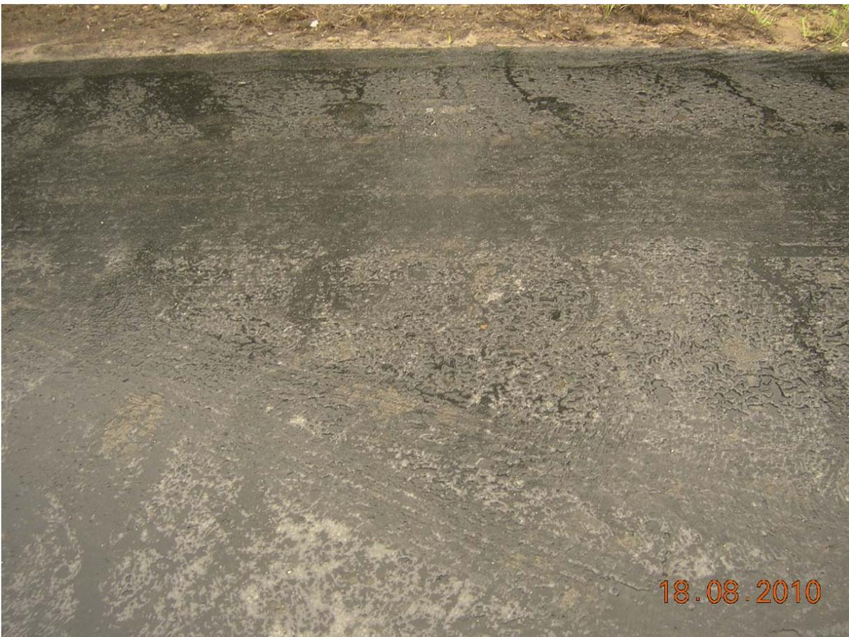
Abbildung 6-6: Unzureichendes Vorsprühen mit Bitumenemulsion (Kretz)
