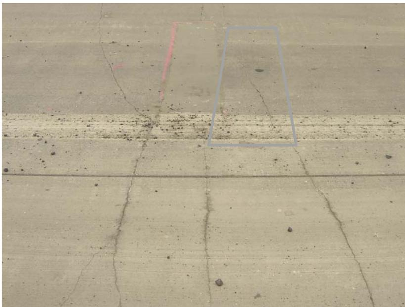
Abbildung 6-5: Sanierte Schadstelle vor Asphaltüberbauung (Kretz)
