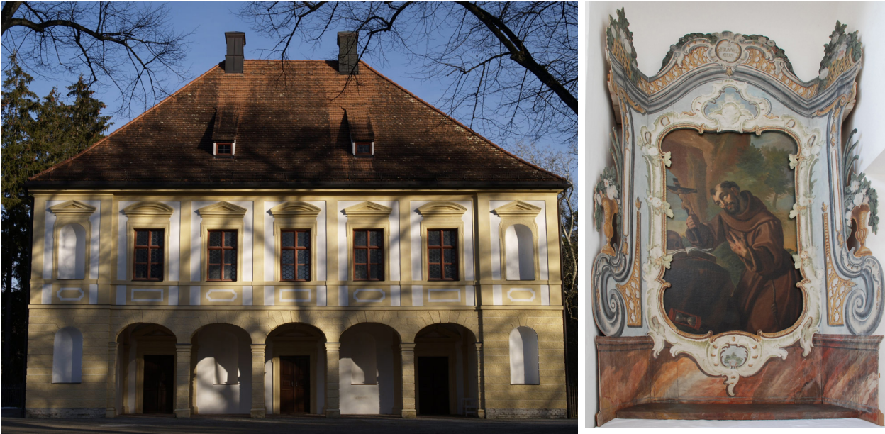
Abbildung 4.37: Renatuskapelle in Lustheim, Schleißheim/München, erbaut 1684–1690 von Henrico Zucalli. Links: Renatuskapelle in Lustheim (Foto: Kilian), Außenansicht; rechts: Westlicher Seitenaltar Hl. Franziskus.
