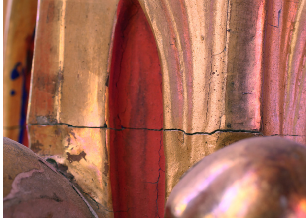
Abbildung 4.27: Türkischer Saal, Vorraum Südwand: Ausbrüche und verstärktes Craquelée durch starke Feuchteinwirkung an freistehender Säule.
