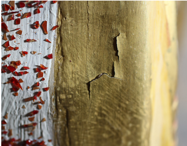
Abbildung 4.32: Erste Ausbrüche und Lockerungen in der Vergoldung bei der ersten Untersuchung 2008.
