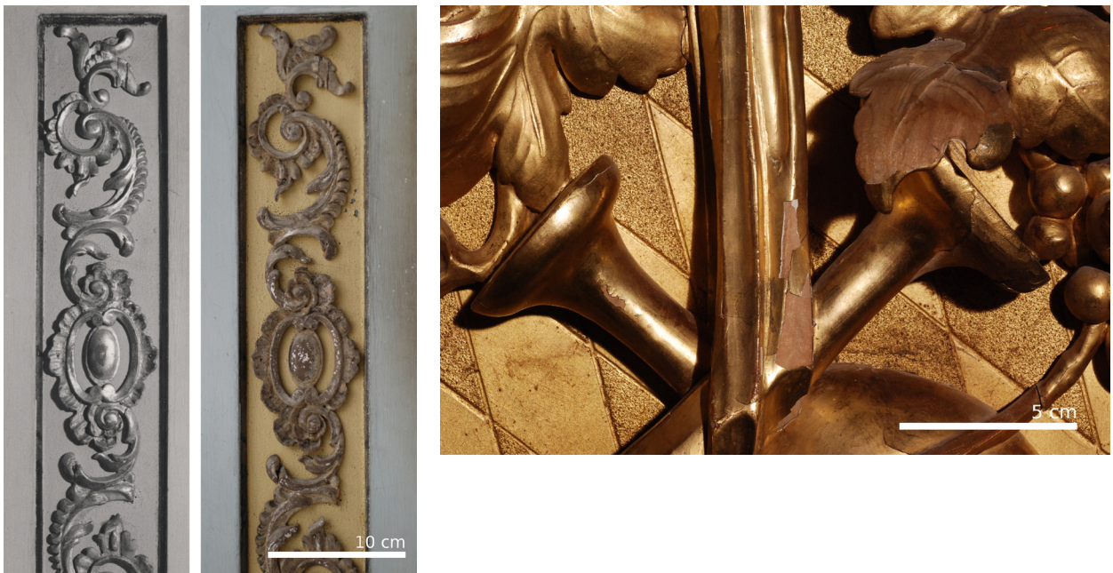
Abbildung 4.7: Vergleich der Zustandsänderung 1992 (links) und 2012 (rechts) an versilberten Holzornamenten des Fensterladens im Gelben Kabinett. Die Blattmetallaufgaben sind 2012 größtenteils verloren.
