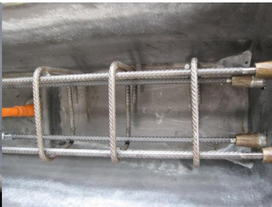
Abbildung 38: Spaltzugbewehrung
