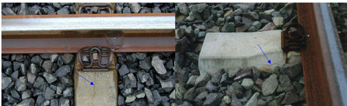
Abbildung 10: Längs- und Sickenriss [16]
