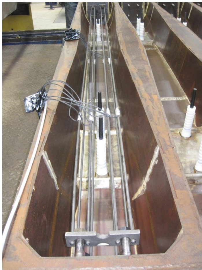
Abbildung 36: Position der DMS an den Spannstählen
