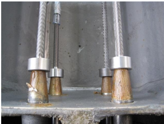
Abbildung 37: Endverankerung
