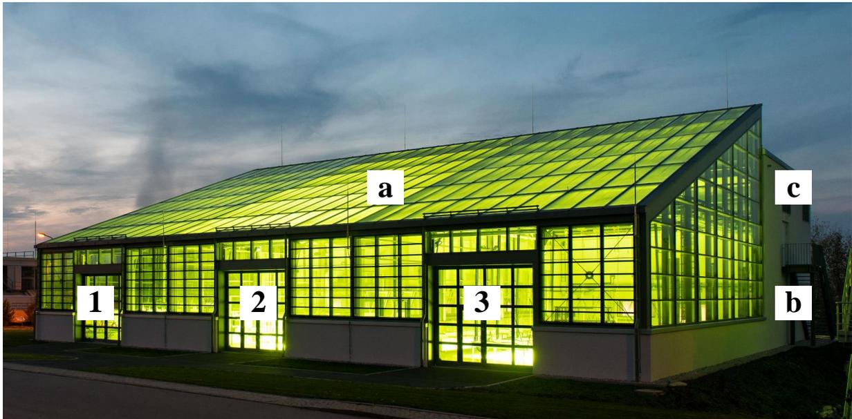
**Abbildung A.7:** Außenansicht des Algentechnikums mit den Hallen 1-3 zur Klimasimulation (a), den Laborräumen (b) sowie der Klimaanlage (c).
