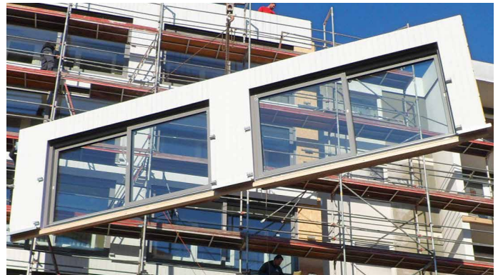
Abb. 1: Einbau TES-Fassade [gumpp & maier]
