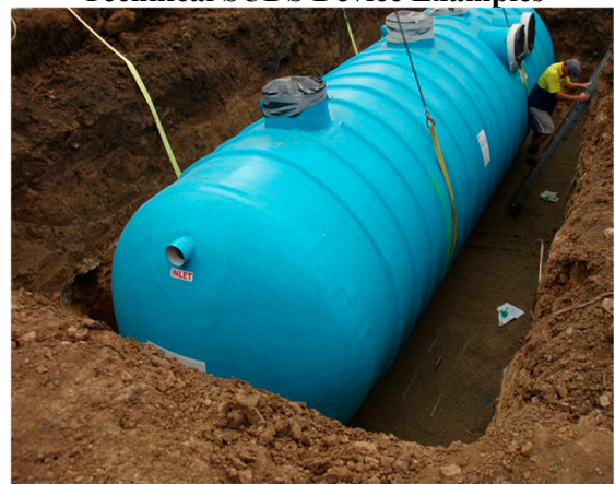
(d) Sedimentation Tanks [2]
