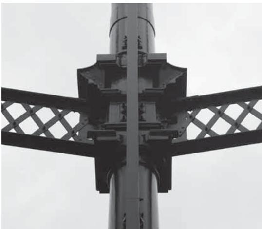
Abb. 148: Trägerstoß an gusseisernes Architrav in King's Cross, London (BB, 2015).
