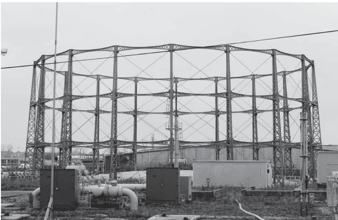
Abb. 220: Dreigeschossiges Verbandgerüst in Eastbourne basierend auf sich verjüngenden Kastenträgern (BB, 2015).
