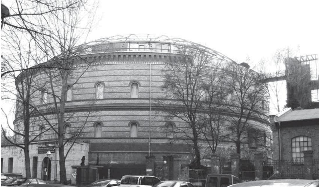
Abb. 1: „Fichtebunker“ – umgenutztes Gasbehältergebäude mit Loftwohnungen unterhalb der Kuppel – Fichtestraße, Berlin (BB, 2013).
