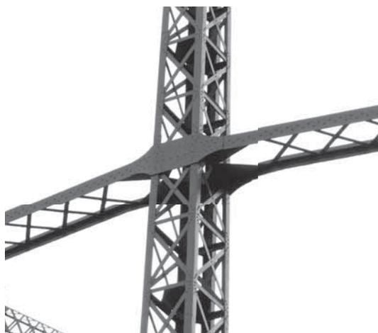
Abb. 151: Anschluss von liegenden Gitterträgern an kastenförmige Stütze in Bethnal Green, London (BB, 2015).
