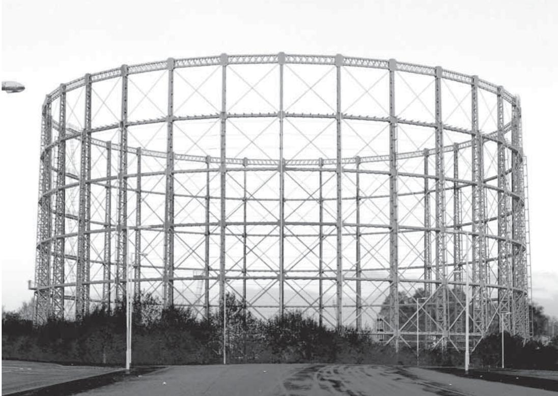
Abb. 222: Sechsgeschossiges Verbandgerüst mit einfacher Auskreuzung in der Bradford Road, Manchester (BB, 2015).
