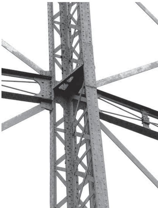
**Abb. 17:** Genietete T-förmige Stütze in einem Gerüst in Kennington, London (BB, 2015).
