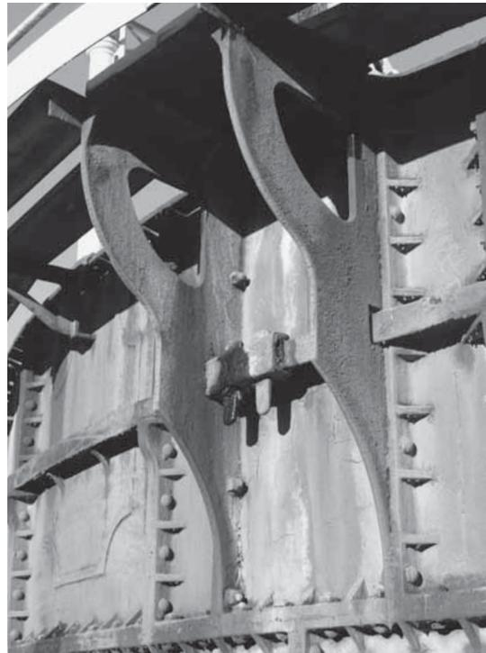
**Abb. 259:** Gusseiserne Konsole zur Befestigung der Säule, Fakenham (BB, 2015).
