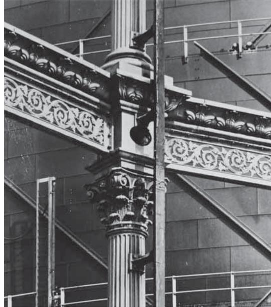
Abb. 191: Unterer Architrav mit anschließenden Trägern, Säulen und Führungsschiene in Fulham, London (NGM, o. J.).
