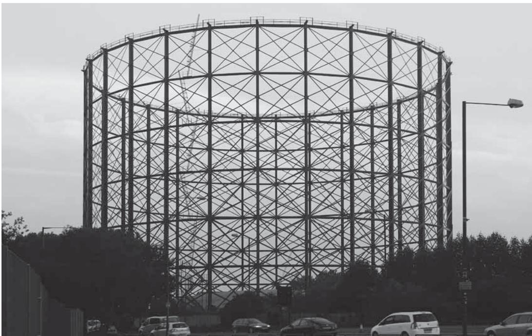
Abb. 234: Verbandgerüst mit dreifacher Auskreuzung in East Greenwich, London (BB, 2015).
