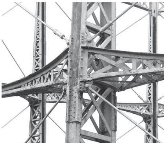
Abb. 152: Trägerstoß an schmale, kastenförmige Stütze in Eastbourne (BB, 2015).
