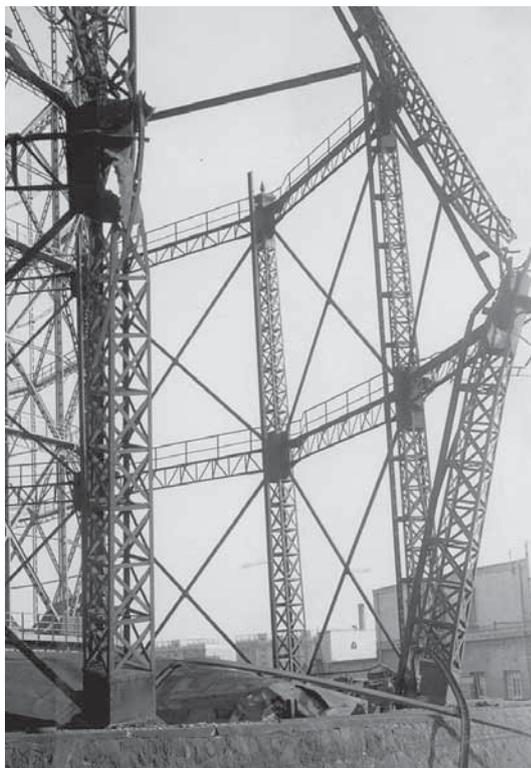
**Abb. 41: Verbandgerüst mit kastenförmigen Stützen und einfacher Auskreuzung aus Flacheisen in Arenaccia, Neapel (ITG, o. J.).**
