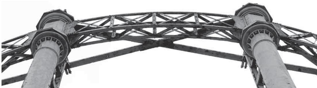
Abb. 144: Liegender Verband nach Paddon bei einem zweigeschossigen Rahmengerüst in Great Yarmouth (BB, 2015).
