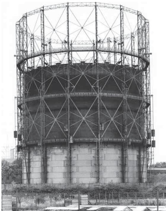
Abb. 6: Teleskopgasbehälter in Alsdorf-Aachen (Becher, 2013).
