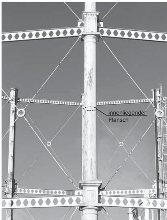
Abb. 11: Gusseiserne, zweiteilige Säule mit innen liegenden Flanschen in Manchester (BB, 2015).
