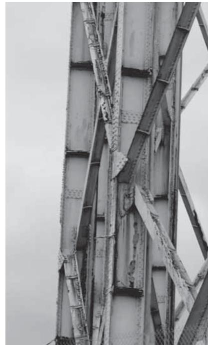
Abb. 249: Anschluss des Windverbands an die Stützen (BB, 2016).
