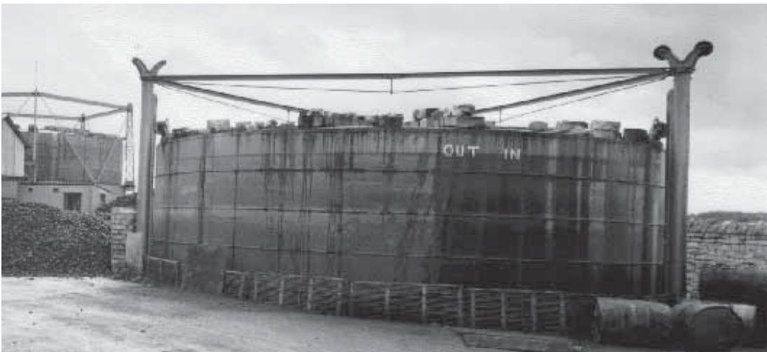
Abb. 173: Säulengerüst mit nur drei Säulen und Rollen für Gegengewichte, Longport Gasworks (NGA, BG29/SW/EB/82).
