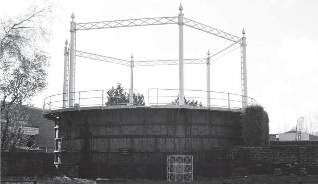
*Abb. 169: Rahmengerüst eines Gasbehälters mit schlanken, gusseisernen Säulen in Fakenham, Baujahr 1882 (BB, 2015).*
