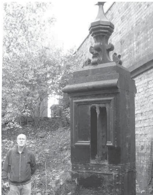
Abb. 158: Hinterbliebener Stützenkopf mit Trägeranschluss und Fiale in York (Foto, Sandra Garside-Neville, 2016).
