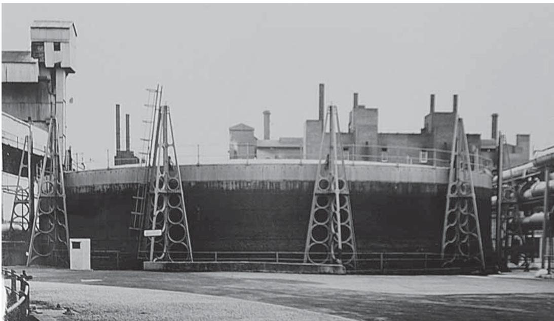
Abb. 164: Dreibein-Stützen des Gasbehälters „Falkus“ auf dem Gaswerk Fulham, London (LMA, COLLAGE: the London Picture Archive, ref 214671).
