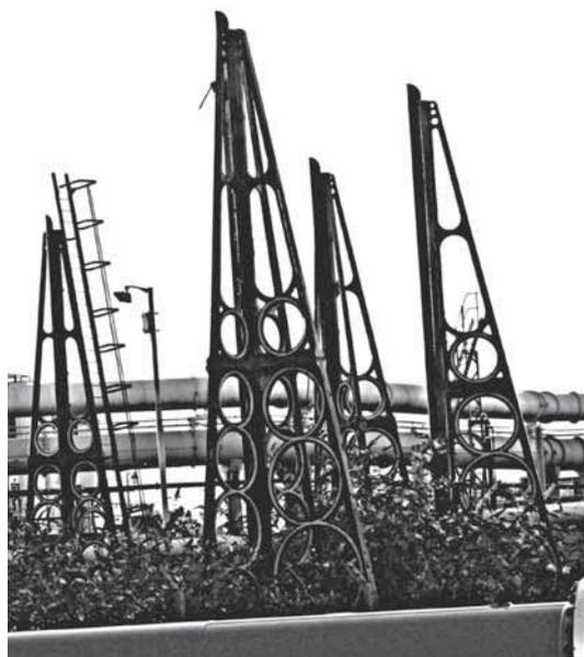
Abb. 165: Dreibein-Stützen des Gasbehälters in Fulham, London (BB, 2015).
