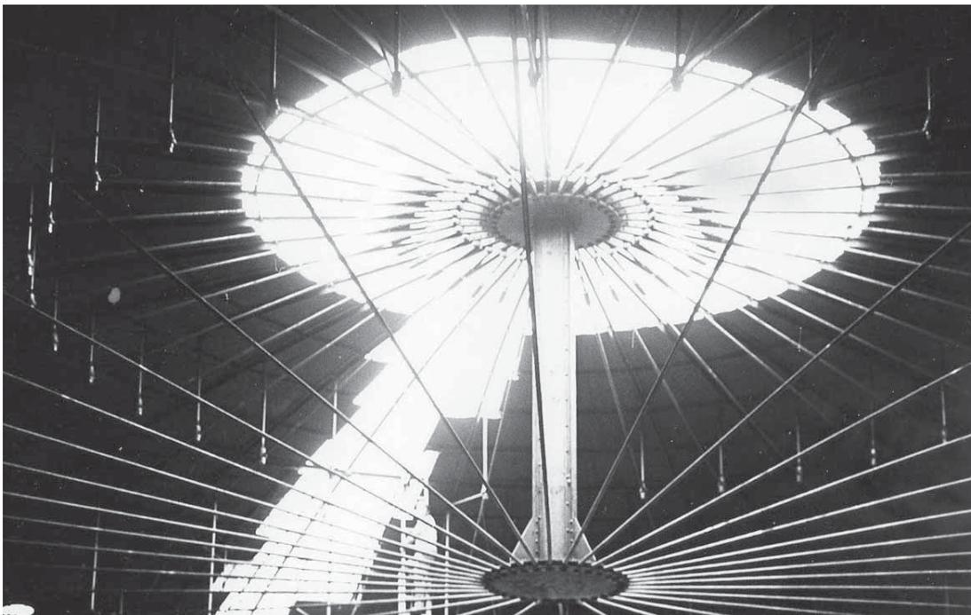
Abb. 35: Luftstütze einer unterspannten Kuppel in Mailand (AEM, o. J.).
