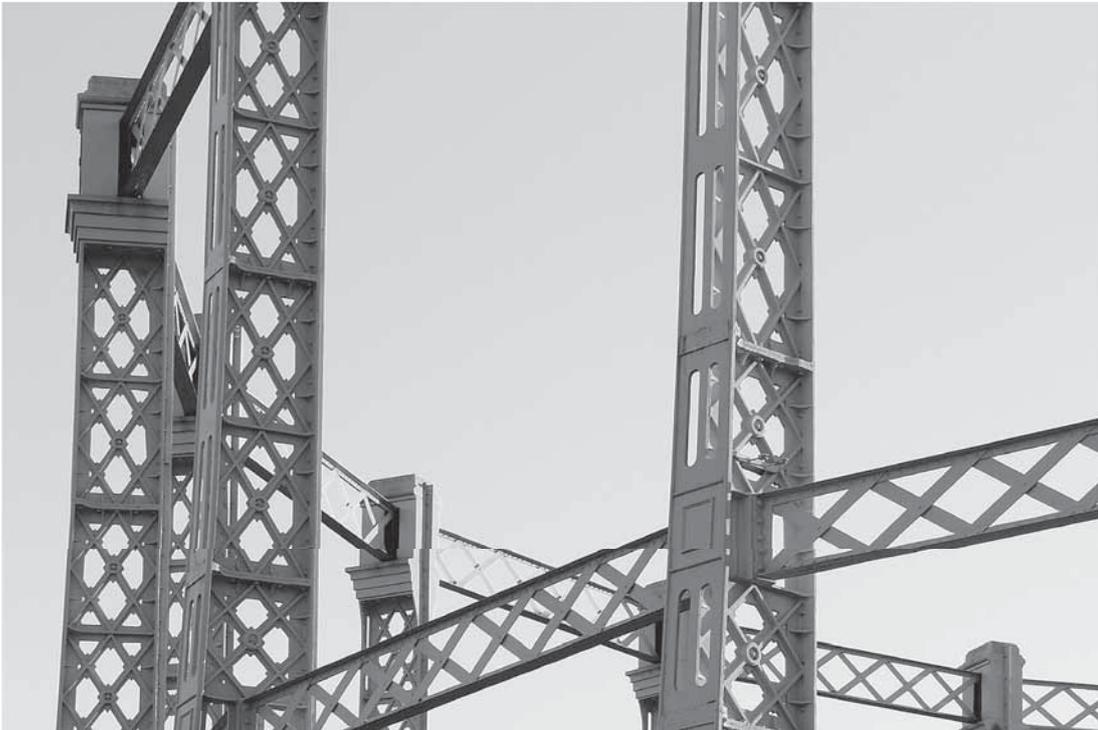
Abb. 194: Zweigeschossiges Rahmengerüst mit gusseisernen Stützen in Fulham, London (BB, 2015).
