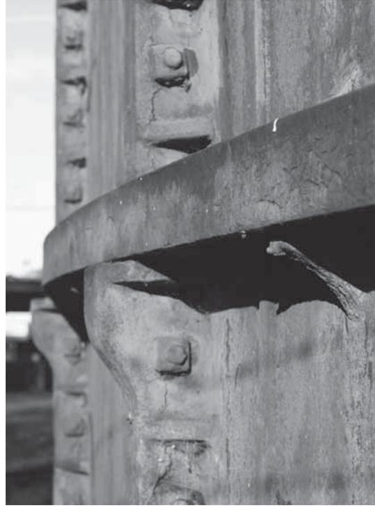
**Abb. 258:** Verschraubte Eisenplatten mit Steifen am Flansch und Nasen für Ringanker, Fakenham (BB, 2015).
