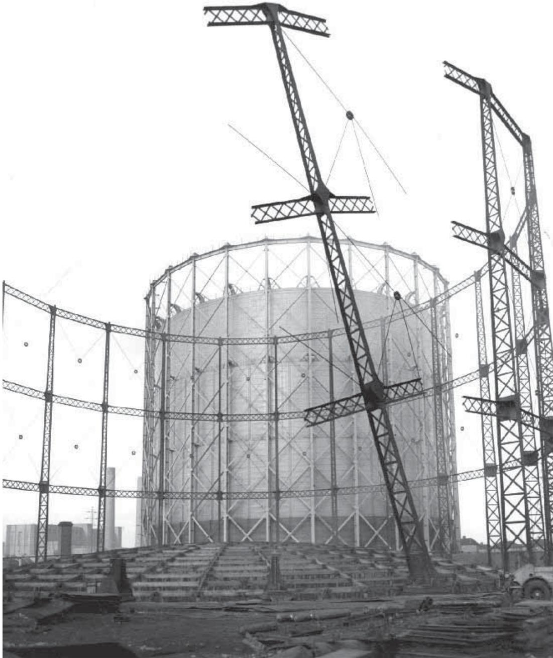
*Abb. 132: Abbruch von Gasbehälter IV in Croyden, London, 1954 (NGA, SE/CRD/CRG/E/F/39).*
