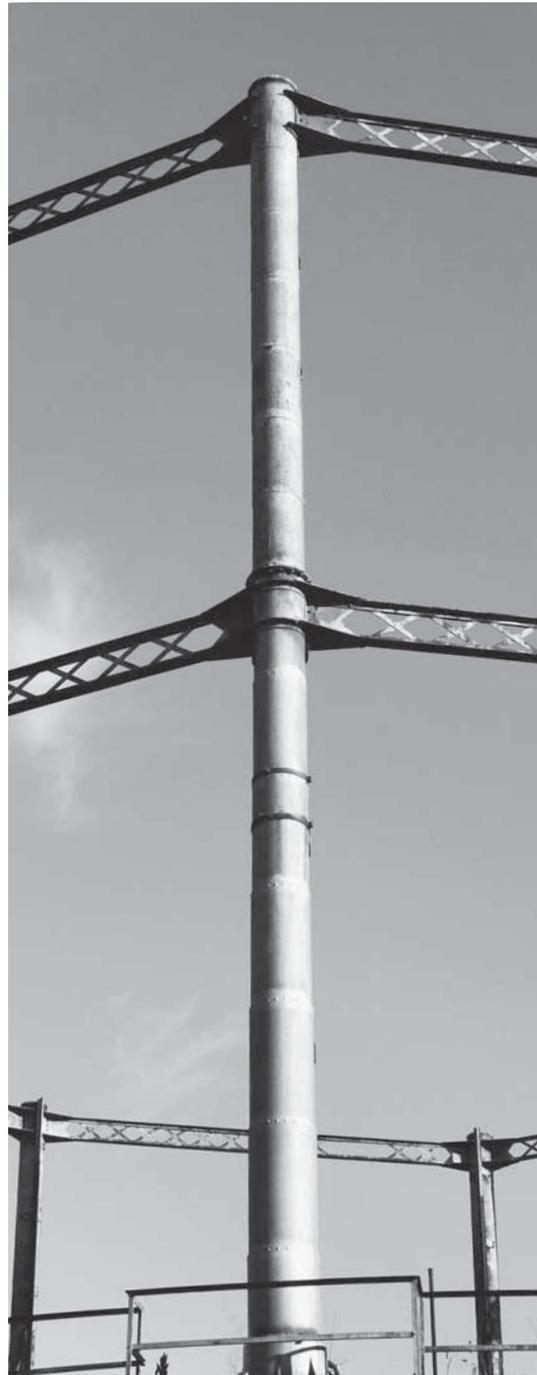
Abb. 111: Genietetete Säule mit anschließenden Gitterträgern (BB, 2013).
