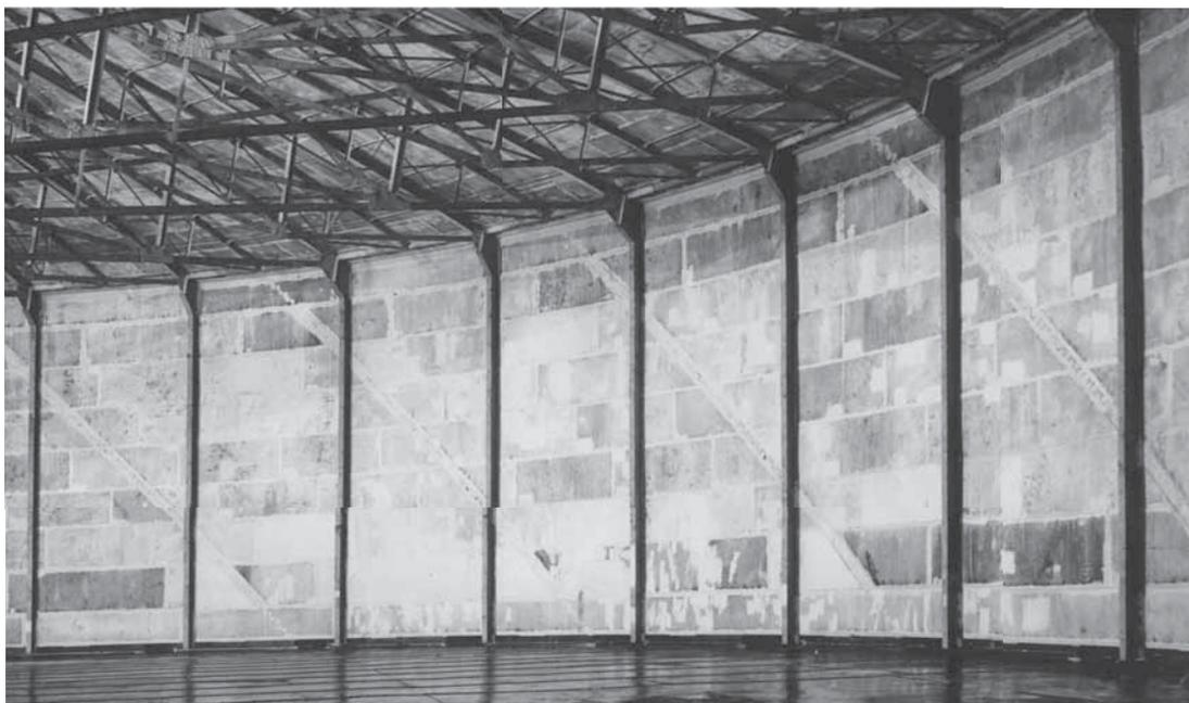
Abb. 68: Mantelständer eines Schraubengasbehälters in Darlington, 1948 (NGA, BG21/DAC/E/F/1/21 ).
