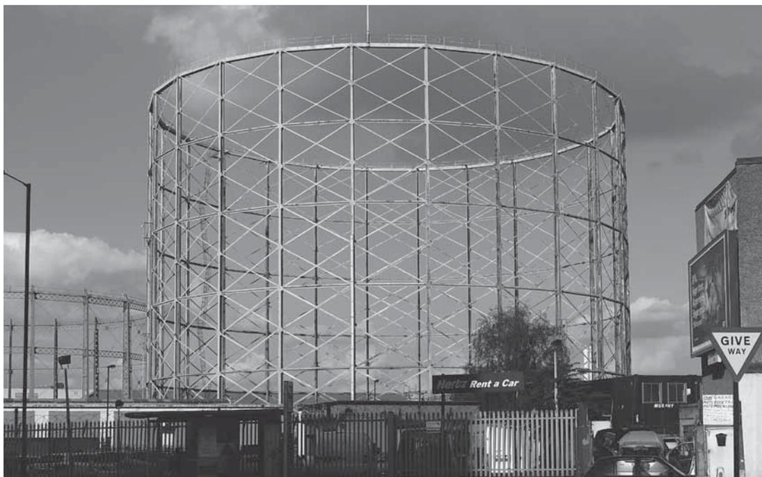
Abb. 224: Liveseys erstes Verbandgerüst mit zweifacher Auskreuzung in der Old Kent Road, London (BB, 2015).
