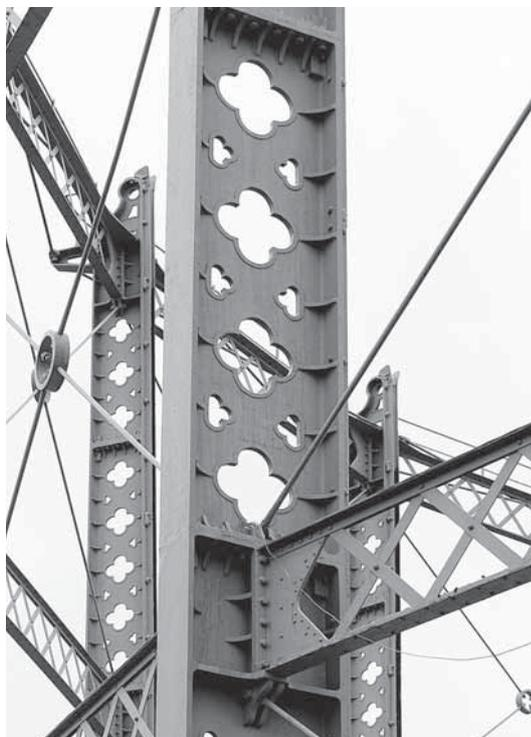
Abb. 210: Anschluss von Träger und Rundeisenstäben an Stütze, Old Kent Road, London (BB, 2015).
