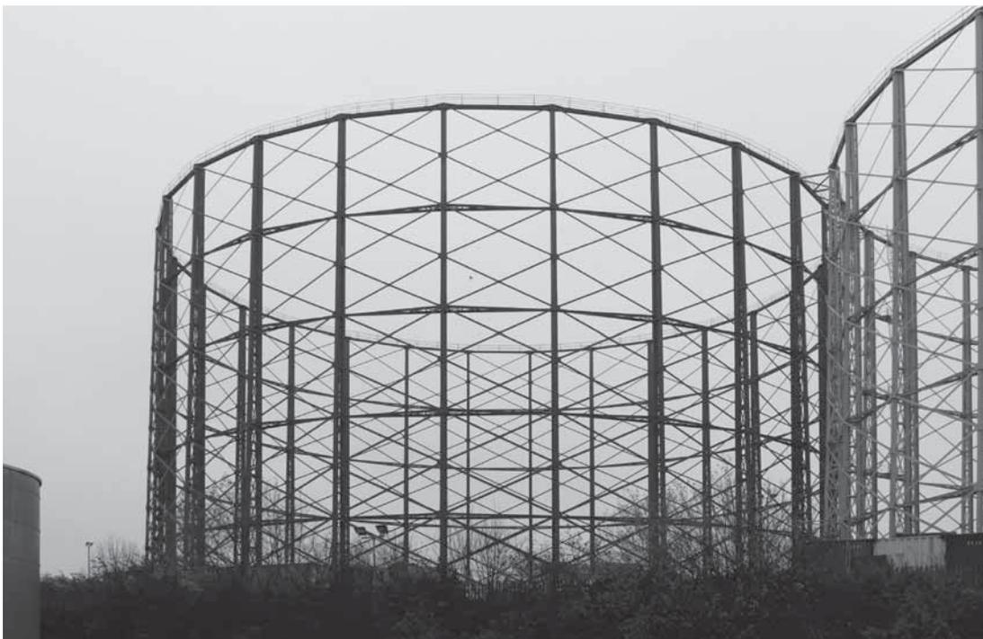
Abb. 227: Fünfgeschossiges Verbandgerüst mit zweifacher Auskreuzung in der Windsor Street, Birmingham (BB, 2015).
