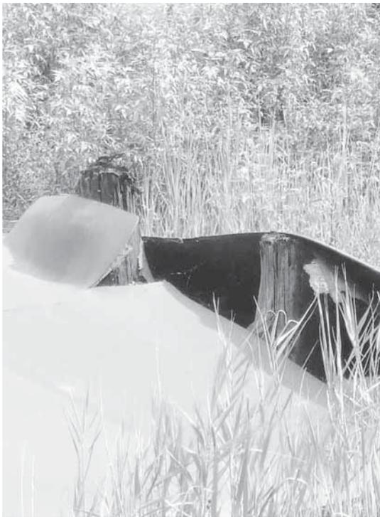
Abb. 125: Durchstoßende Holzständerköpfe des innen liegenden Stützgerüsts für die Kuppel (BB, 2008).
