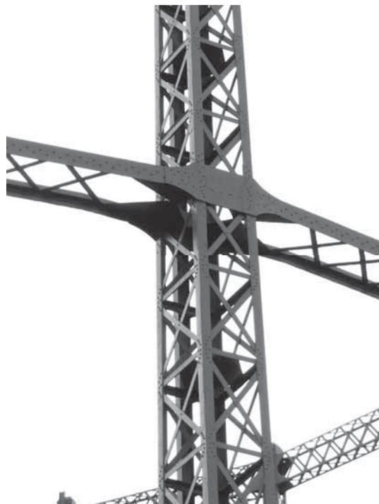
**Abb. 18:** Anschluss von einer kastenförmigen Stütze mit einem liegenden Gitterträger in Bethnal Green, London (BB, 2015).
