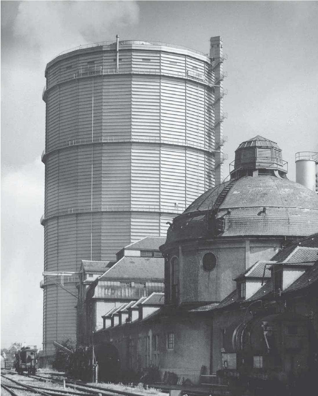
Abb. 361: Entwicklung des MAN-Scheibengasbehälters – vom Prototypen (rechts) zum Standardmodell (links; GWF, 1954).
