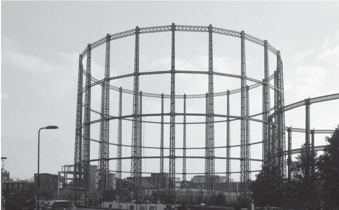
Abb. 198: Viergeschossiges Rahmengerüst mit kastenförmigen Stützen in Bethnal Green, London (BB, 2015).
