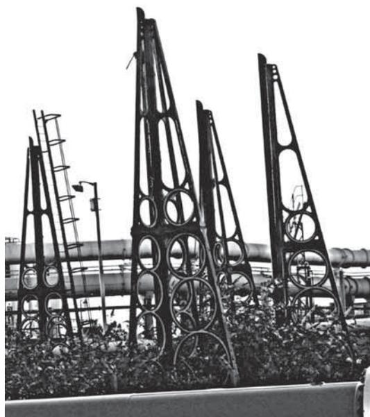
Abb. 90: Dreibein-Stützen des Gasbehälters in Fulham, London (BB, 2015).
