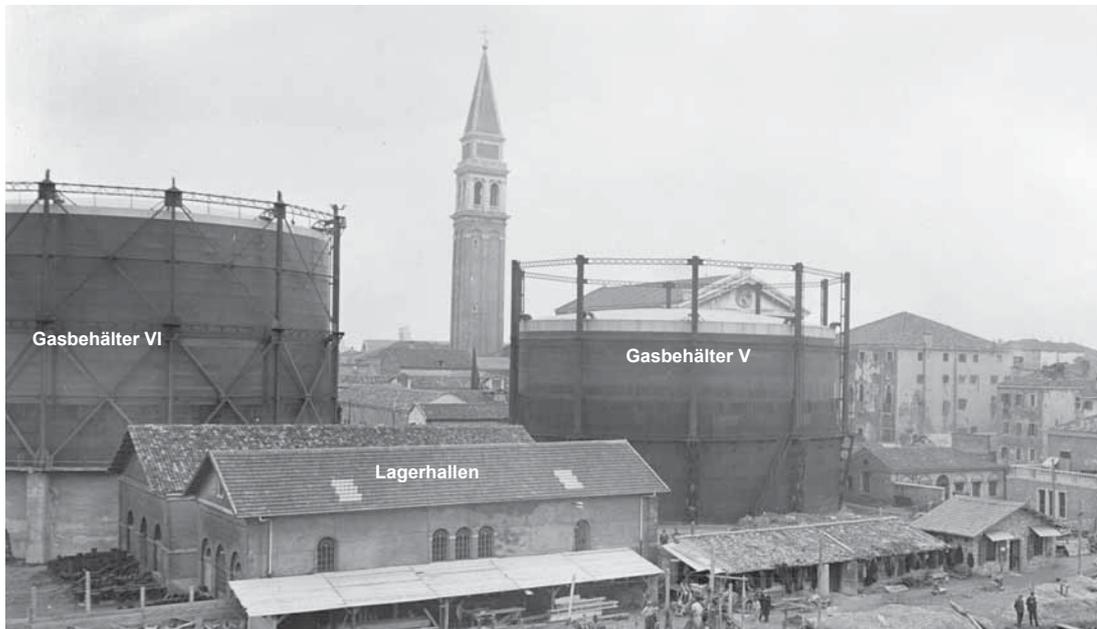
Abb. 100: Rückbau des Gaswerks um 1930, Gasbehälter V und VI sowie einige Lagerhallen blieben bestehen (AFD, 1930).\*\*
