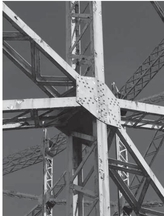
Abb. 245: Knotenpunkt mit schmalen Kastenträgern (BB, 2016).
