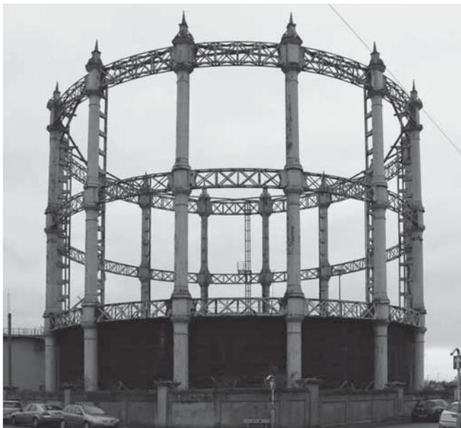
Abb. 188: Zweigeschossiges Rahmengerüst mit segmentförmigen, kastenförmigen Fachwerkträgern (BB, 2015).
