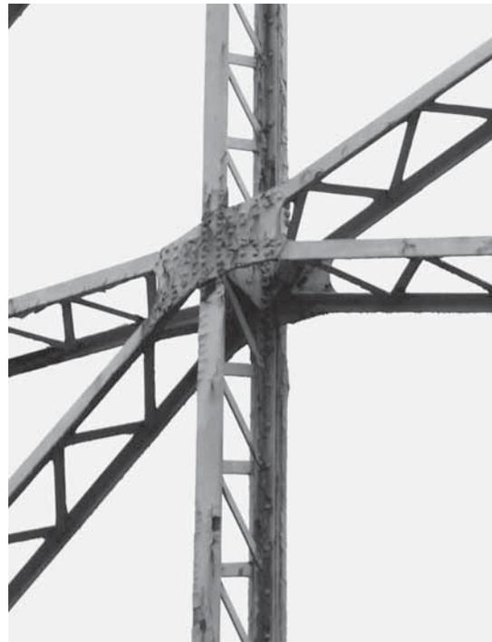
Abb. 241: Knotenpunkt mit I-förmigen Gitterträgern in Hornsey (BB, 2015).
