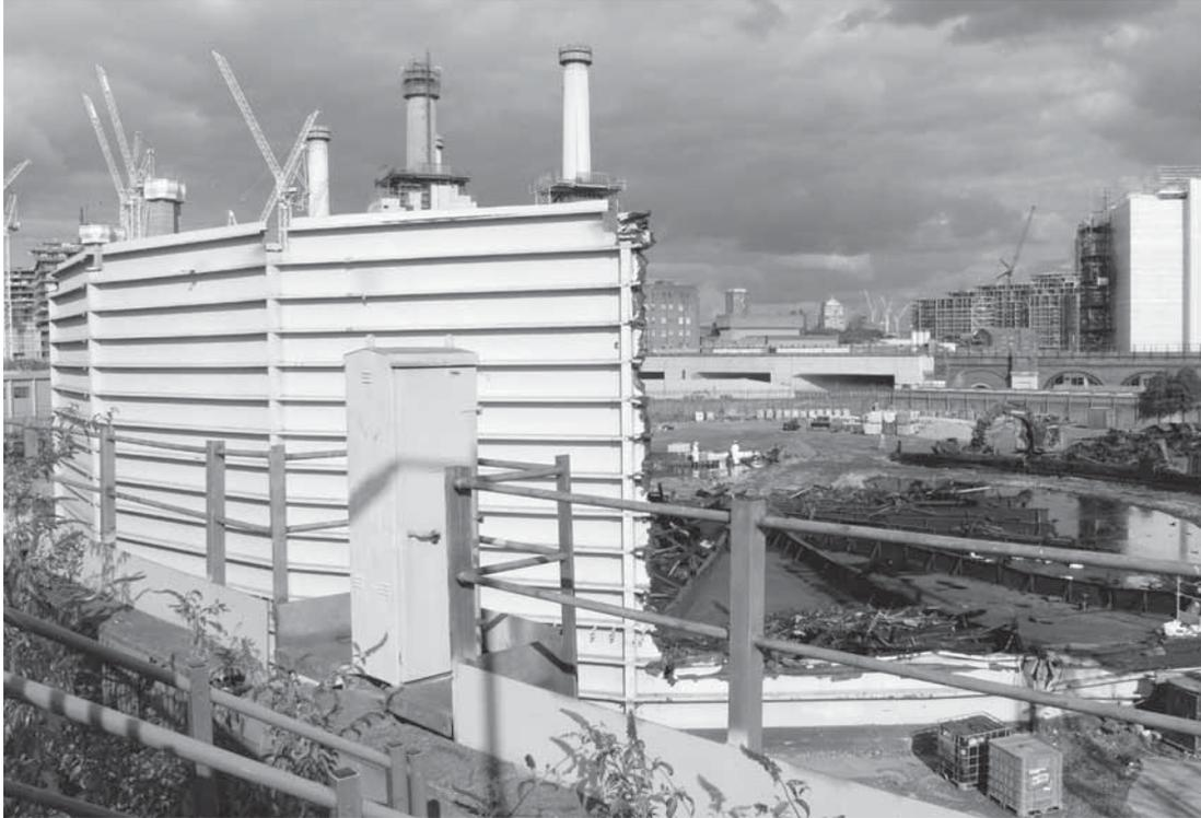
**Abb. 7: Abbrucharbeiten am MAN-Scheibengasbehälter in Battersea, London (BB, 2015).**
