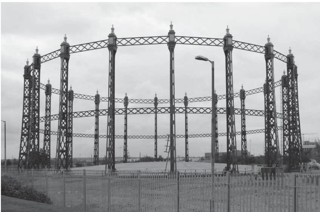
Abb. 193: Zweigeschossiges Rahmengerüst mit gusseisernen Stützen in Beckton, London (BB, 2015).
