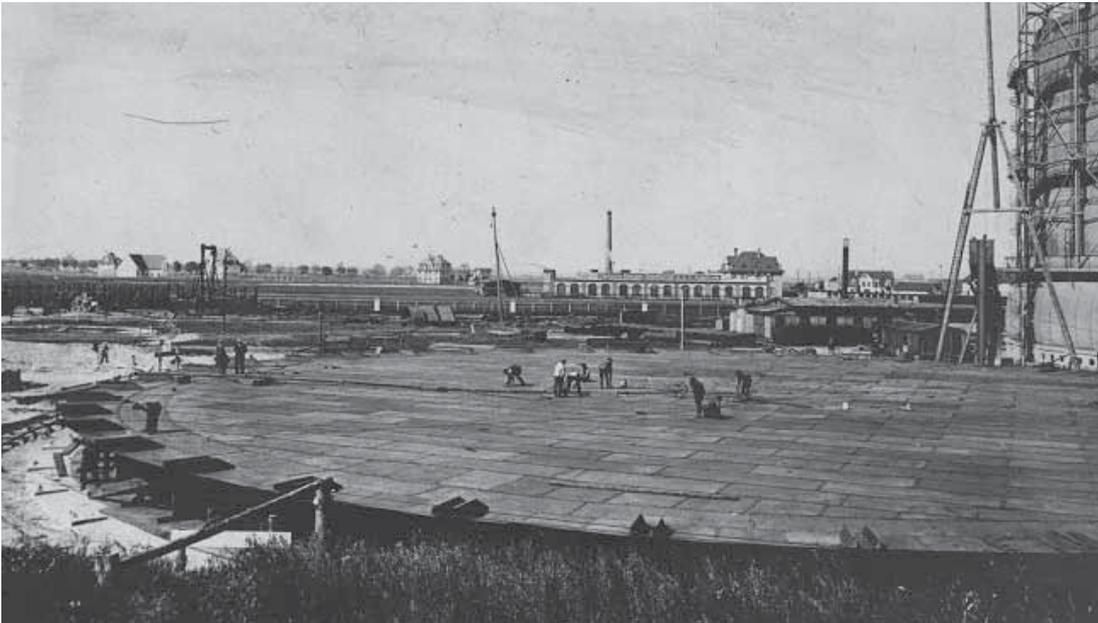
**Abb. 300: Montage der Bodenbleche mit U-Eisen-Füßen am Rand (GWF, Bild 100).**
