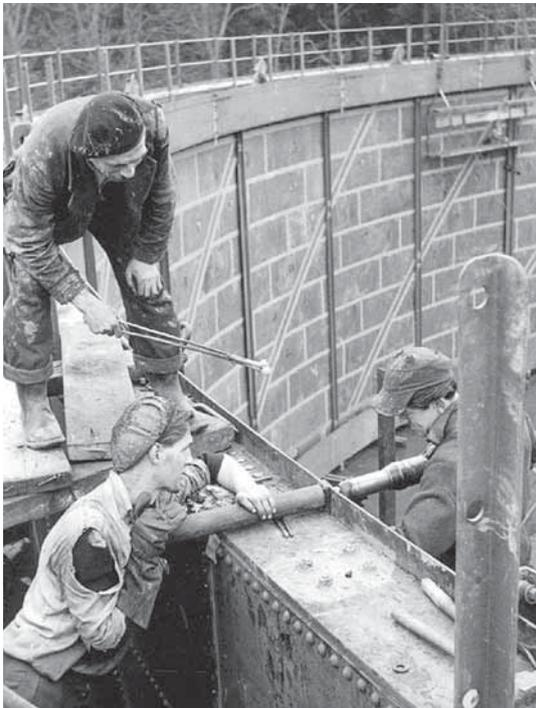
Abb. 23: Nietvorgang bei den Hubteilen eines Schraubengasbehälters um 1955 (NGA, BG11/SE/TS/1/3).
