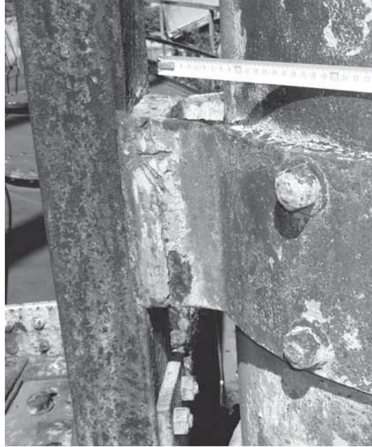
**Abb. 114:** Befestigung der Führungsschiene am Säulenschaft mit spangenförmigen Bauteilen (BB, 2009).
