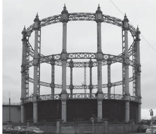
Abb. 143: Rahmengerüst mit liegendem Windverband in Great Yarmouth (BB, 2015).
