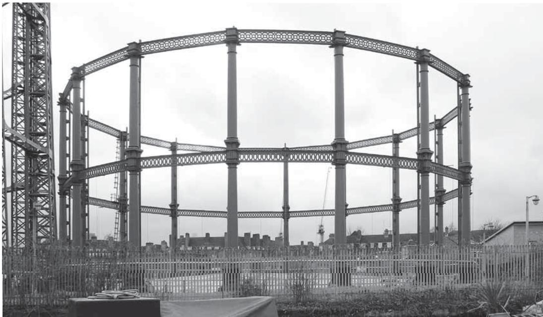
Abb. 185: Zweigeschossiges Rahmengerüst nach Clark in Bethnal Green, London (BB, 2015).
