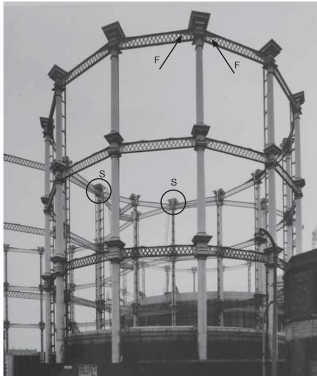
Abb. 187: Dreigeschossiges Rahmengerüst des „Triplets“ in St. Pancras, London um 1976 (LMA, COLLAGE: the London Picture Archive, ref 214725). \*\*
