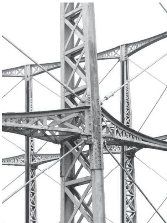
Abb. 221: Stützen-Träger-Verband Anschluss in Eastbourne (BB, 2015).
