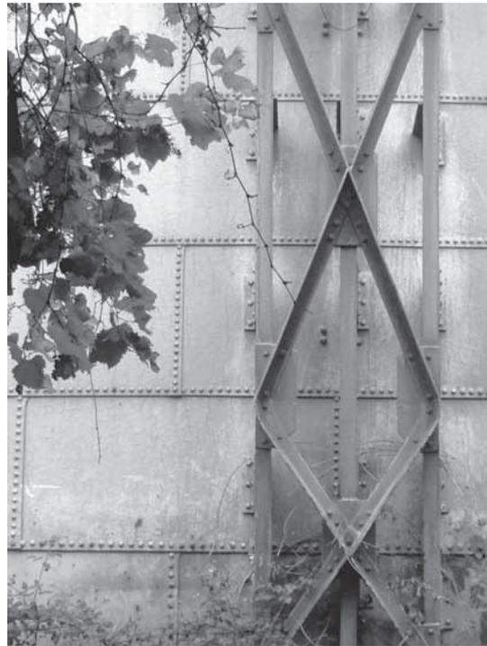
**Abb. 119: Freistehendes Becken aus vernieteten Mantelblechen mit vorgesetzter Konsole (BB, 2008).**
