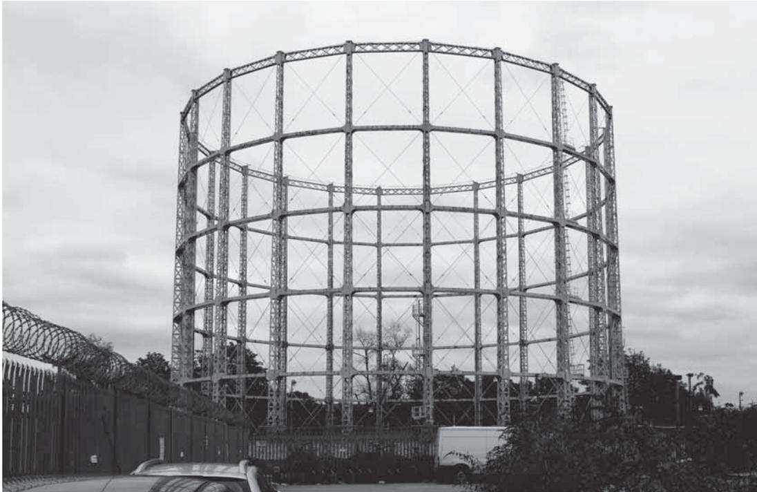
Abb. 218: Fünfgeschossiges Verbandgerüst in Hornsey mit quadratischen Stützen (BB, 2015).
