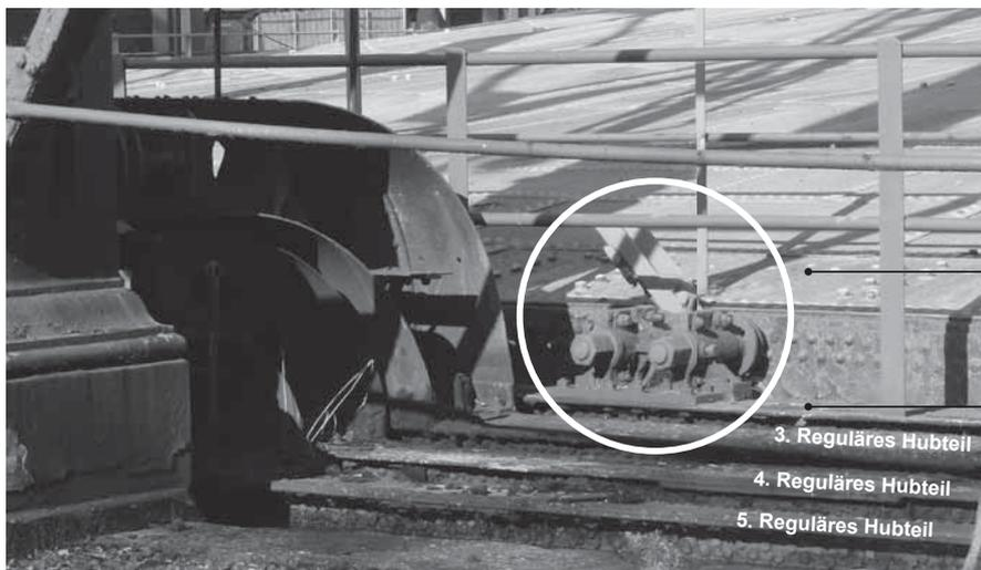
Abb. 127: Rollenanschlüsse des ersten fliegenden Hubteils in Bromley-by-Bow, London (BB, 2015).
