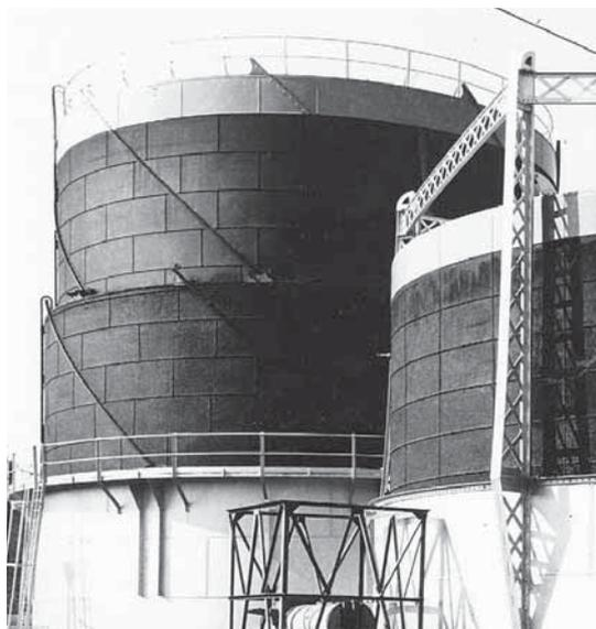
Abb. 74: Zweihübiger Schraubengasbehälter, Civitavecchia (ITG, o. J.).
