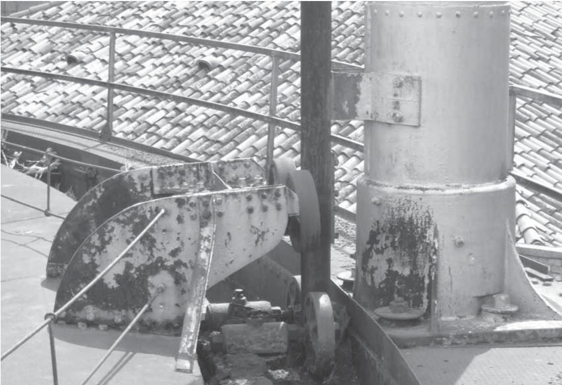
**Abb. 115:** Säulenfußpunkt mit vorgesetzter Schiene und anschließendem Rollenbock (BB, 2008).
