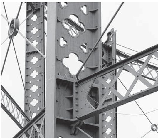
Abb. 149: Trägerstoß an gusseisernes Formbauteil in der Old Kent Road, London (BB, 2015).
