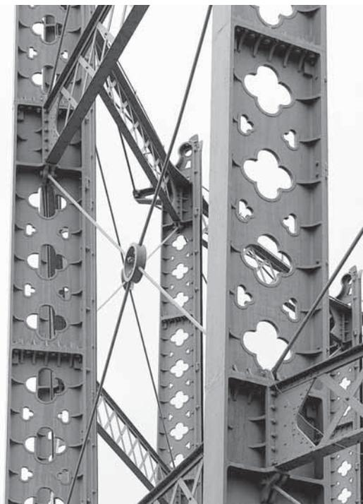
Abb. 13: Gusseiserne Stützen mit Vier- und Dreipässen in der Old Kent Road, London (BB, 2015).
