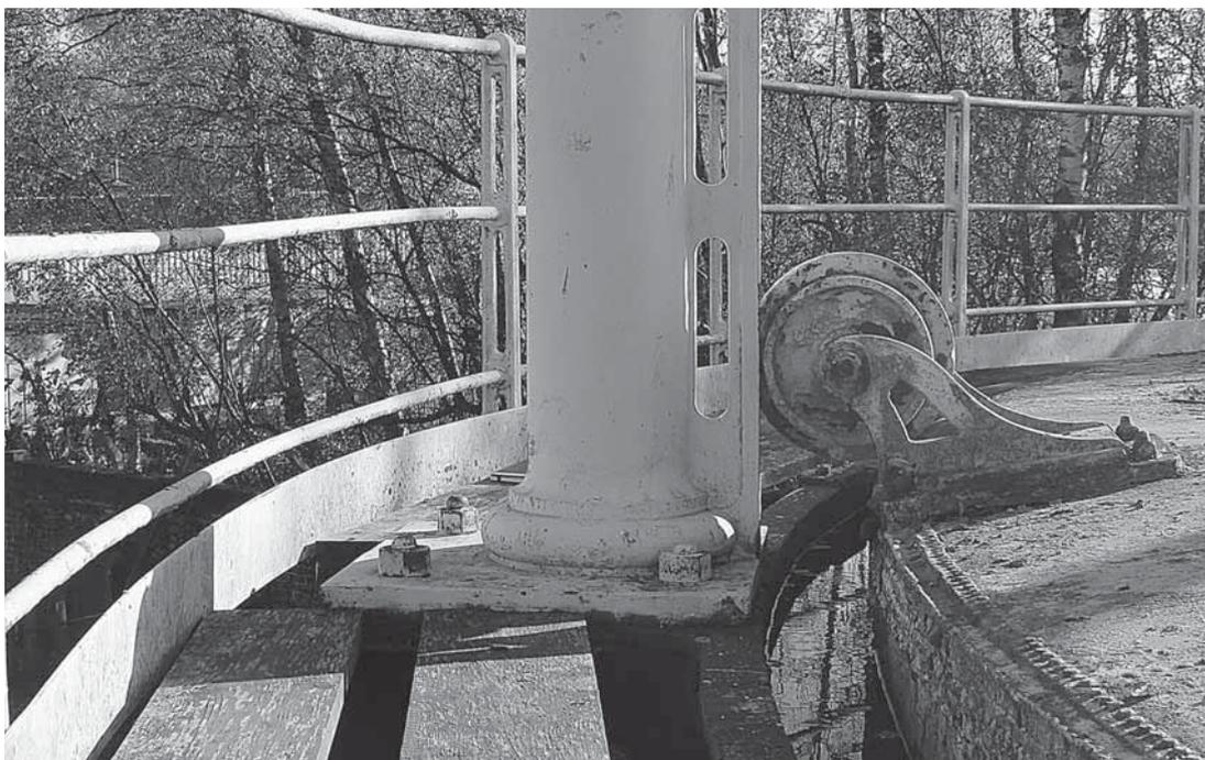
Abb. 98: Rollenanschluss eines Hubteils zum Führungsgerüst, Glockengasbehälter in Fakenham (BB, 2015).
