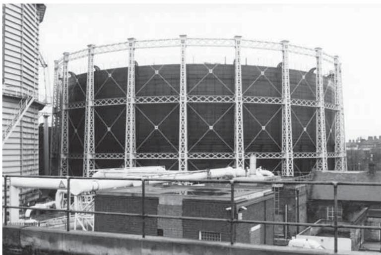
Abb. 216: Dreigeschossiges Verbandgerüst mit kastenförmigen Stützen und einfacher Auskreuzung in Battersea, London (Foto, Malcolm T. Tucker, 1998).
