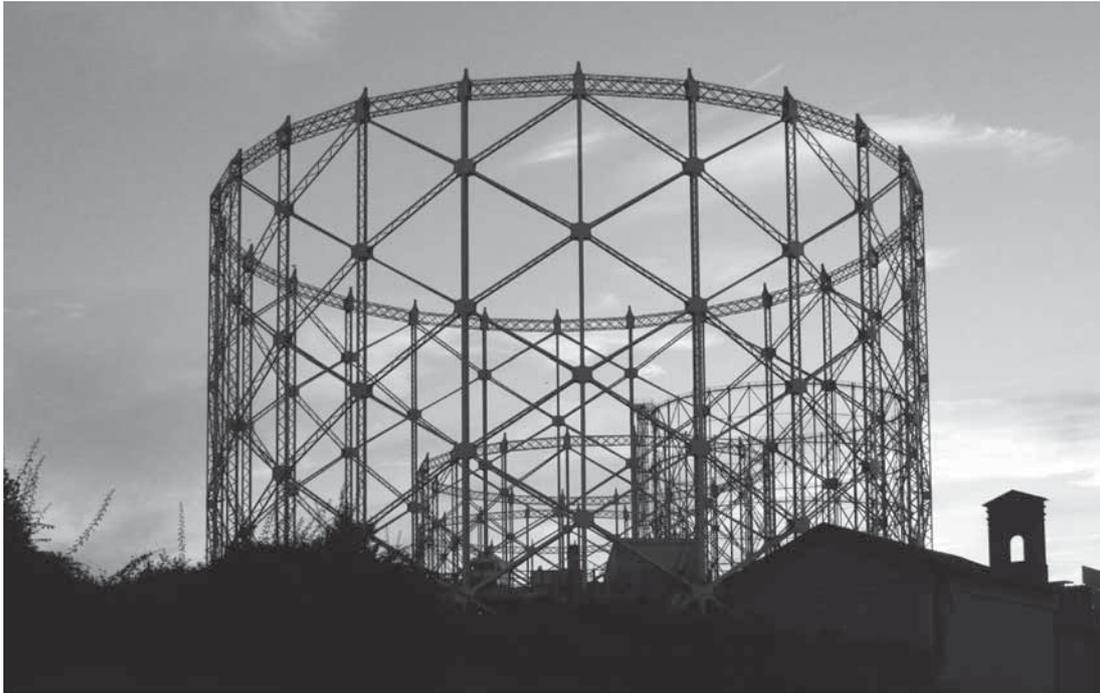
Abb. 50: Trianguliertes Verbandgerüst des vierhübrigen Gasbehälters ( $V=60.000\text{m}^3$ ) auf dem Gaswerk San Paolo in Rom (BB, 2013).
