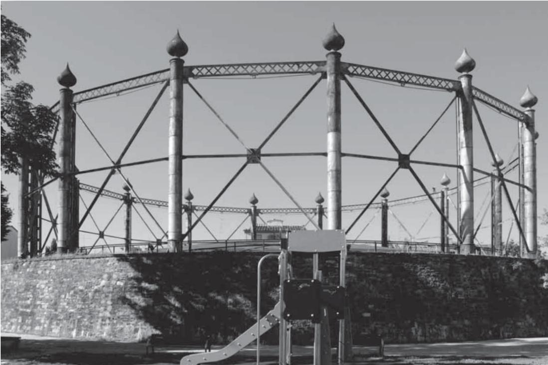
*Abb. 53: Verstärkung des ursprünglichen Rahmen- zum Verbandgerüst auf dem Gaswerk San Frediano, Florenz (BB, 2013).*
