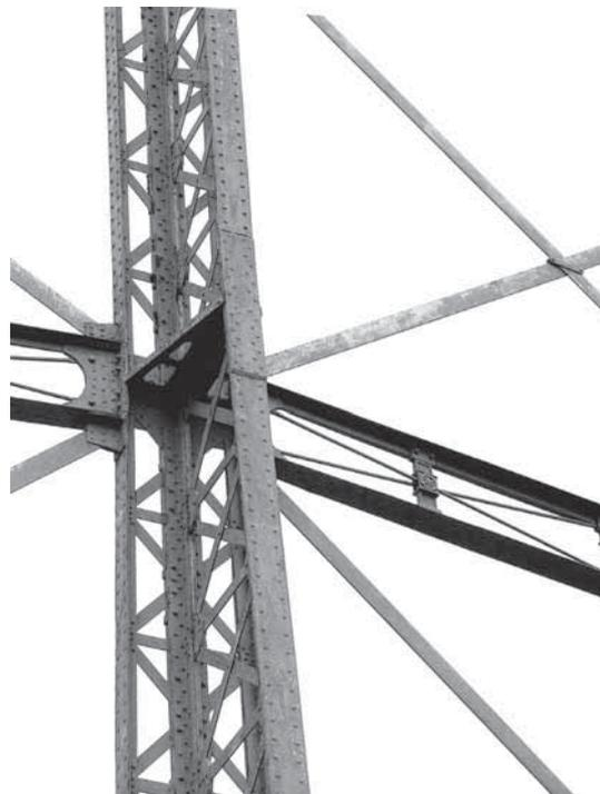
Abb. 233: Anschlussdetail Träger-Verband-Stütze, Kennington, London (BB, 2015).
