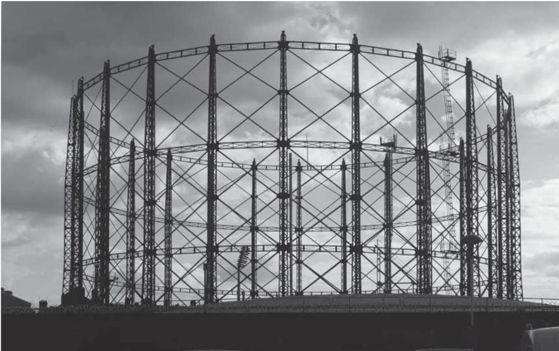
Abb. 232: Erweitertes, dreigeschossiges Verbandgerüst mit zweifacher Auskreuzung in Kennington, London (BB, 2015).
