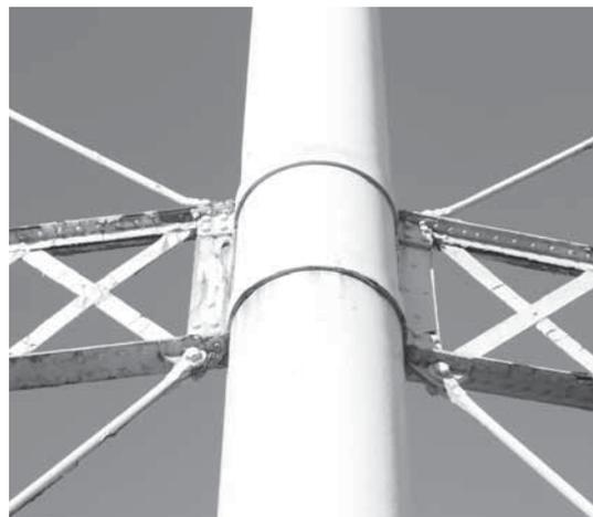
Abb. 155: Träger mit Manschettenanschluss an gusseiserne Säule, Liverpool Road, Manchester-Salford (BB, 2015).
