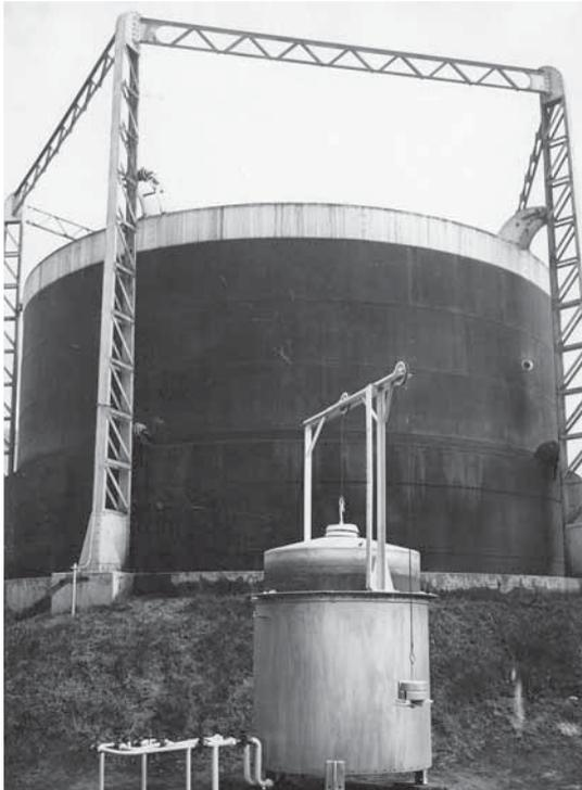
Abb. 30: Hochordnung mit genieteten, kastenförmigen Stützen eines zweihübrigen Gasbehälters in Legnago, 1955 (ITG, 1955).
