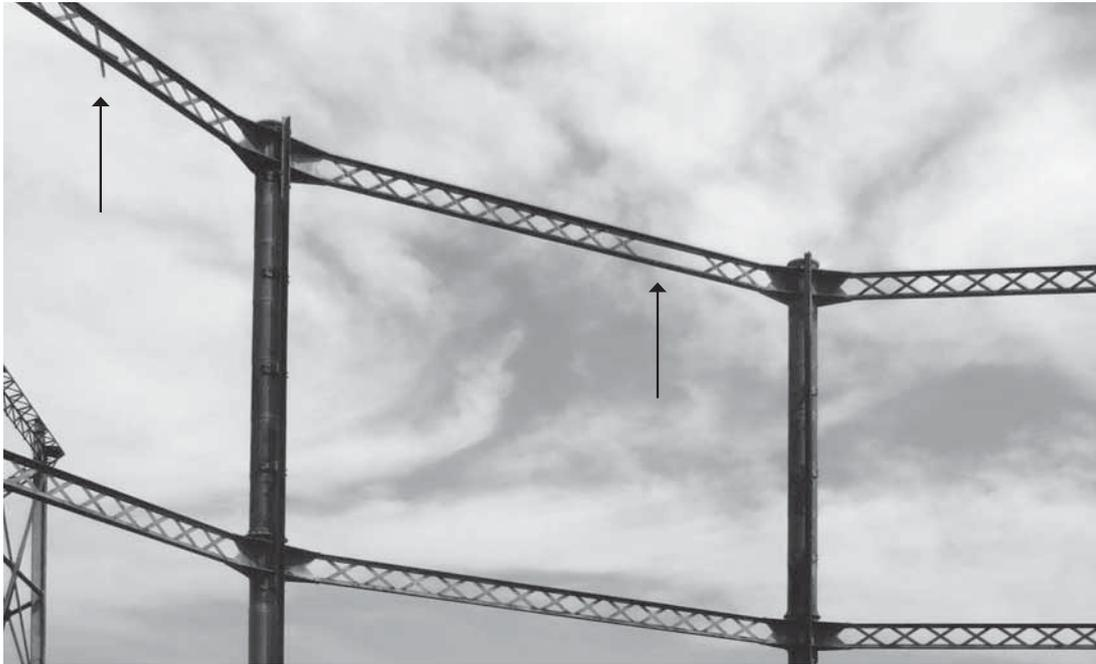
Abb. 124: Gitterträger mit fehlenden bzw. losen, diagonalen Stäben (BB, 2008).\*\*
