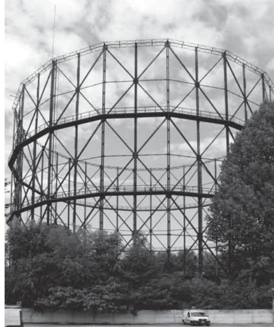
*Abb. 8: Gasbehälter nach Klönne (BB, 2013).*
