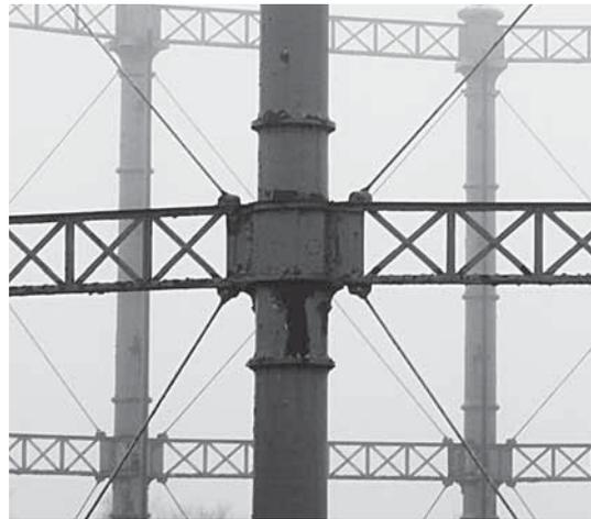
Abb. 154: Umlaufender Trägeranschluss an gusseiserne Säule in Swan Village bei Birmingham (BB, 2015).
