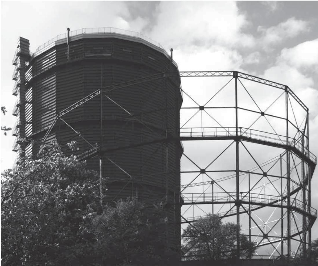
*Abb. 354: Gasbehälterensemble in Augsburg-Oberhausen: Scheiben- und hydraulischer Gasbehälter (BB, 2013).*
