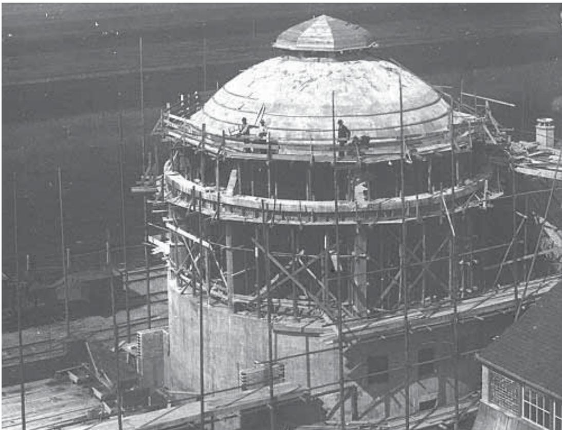
Abb. 356: Bau des Gasbehältergebäudes aus Eisenbeton 1914 (GWF, Bild 134).
