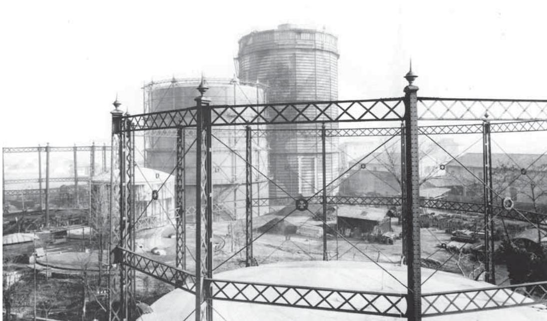
**Abb. 38:** Gasbehälter mit Verbandgerüst auf dem Gaswerk Porta Mascarella in Bologna (Campigotto, 1990).
