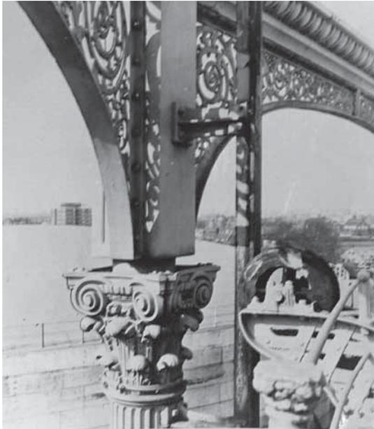
Abb. 190: Oberer Architrav mit anschließenden Trägern und vorgesetzter Führungsschiene in Fulham, London (NGM, o.J.).
