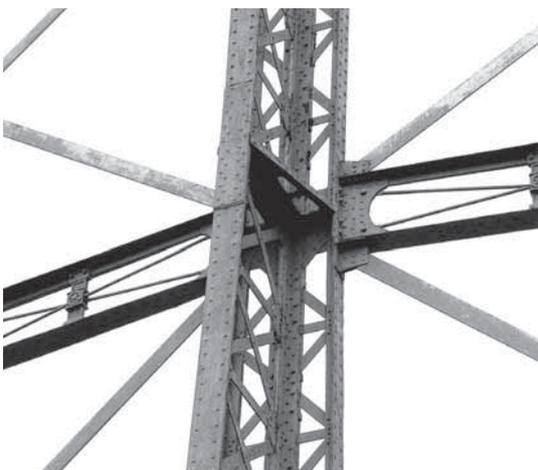
Abb. 150: Trägerstoß an den Flansch einer T-förmigen, genieteten Stütze in Kennington, London (BB, 2015).
