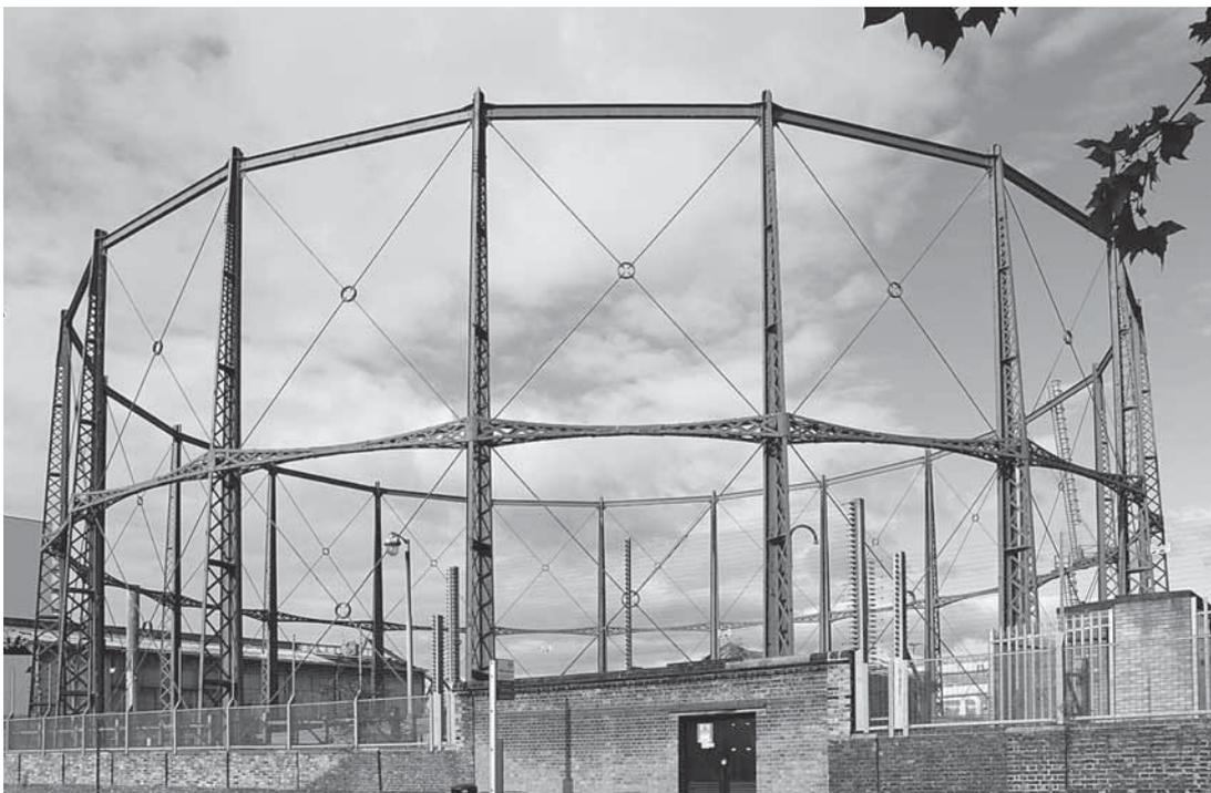
Abb. 212: Verbandgerüst mit einfacher Auskreuzung und T-förmigen Stützen in Poplar, London (BB, 2015).
