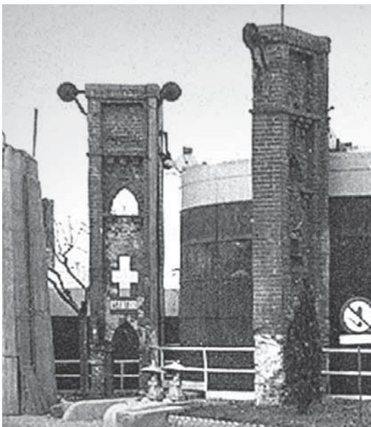
Abb. 89: Glockengasbehälter mit gemauerten Pfeilern in Saluzzo (ITG, o. J.)
