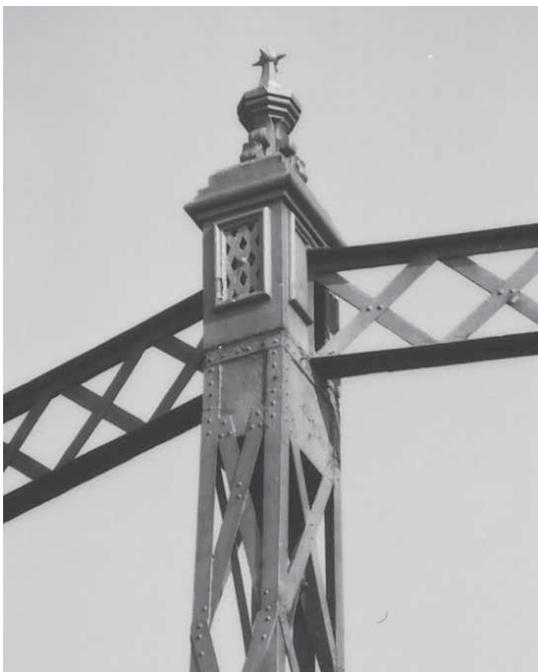
Abb. 157: Verborgener Trägerstoß auf einer kastenförmigen, genieteten Stütze in York (Foto, Malcom T. Tucker, 1994).
