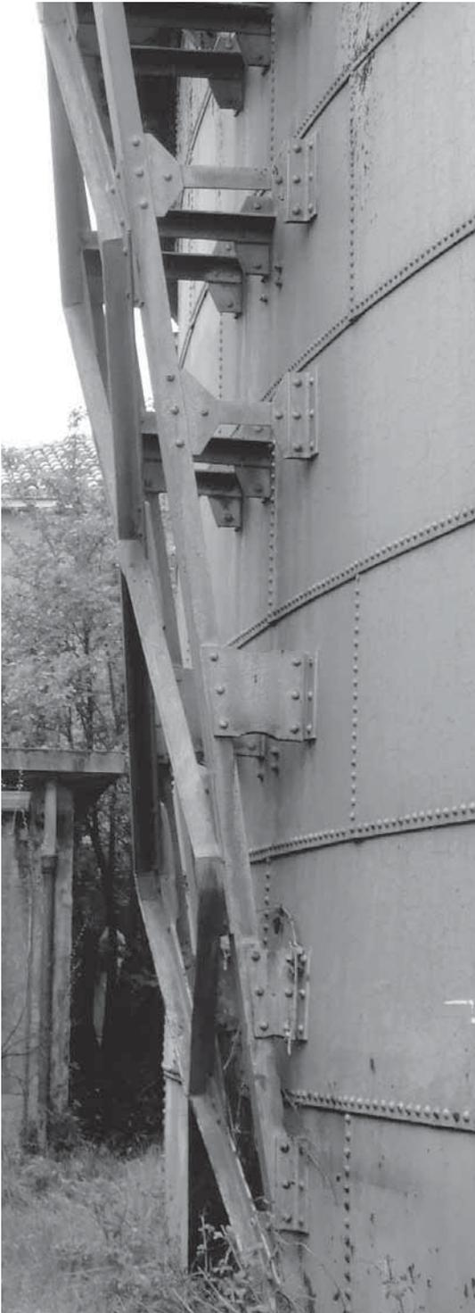
**Abb. 118: Anschluss der Konsole an die Beckenwand (BB, 2008).**
