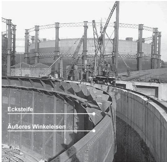
Abb. 65: Montage der Ecksteifen, Linacre (NGA, BG1/NW/1/29-53).\*\*
