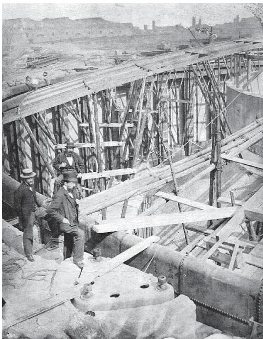
Abb. 46: Bau der Stützkonstruktion für die binderlose Kuppel in der Old Kent Road (NGA, SE/SOM/E/F/12).
