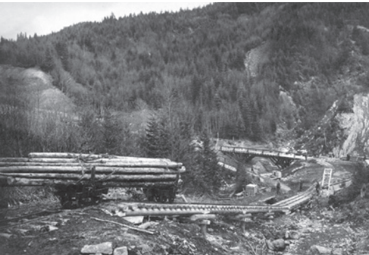
1 Die Bremsbergbahn brachte vom »Bahnhof« auf ca. 1.050 üNN das Holz mit einem durchschnittlichen Gefälle von 25 % ins Tal. Durch die Schwerkraft des vollen Waggons wurde der leere Waggon nach oben gezogen, also ohne Motor. Es wurde daher nur gebremst. Quelle: Gemeindeforschung Schwaigen-Grafenaschau
