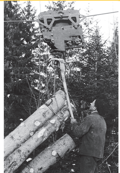
4 Seilkransysteme brachten den Durchbruch für eine rentable Gebirgsforstwirtschaft. Foto: Archiv Wyssen
