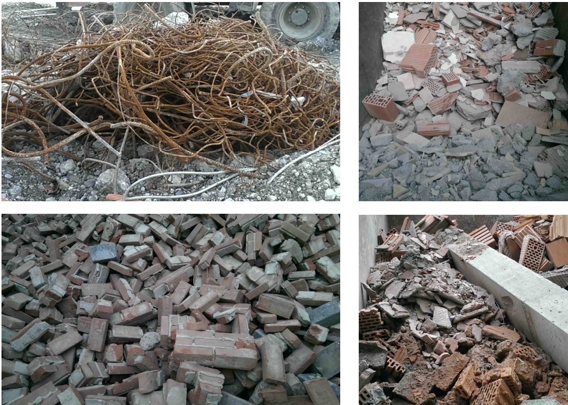
Abbildung B.4: Aussortierung von Metallfraktionen und Verunreinigungen in Bauschuttfraktionen (Eigene Bilder)
