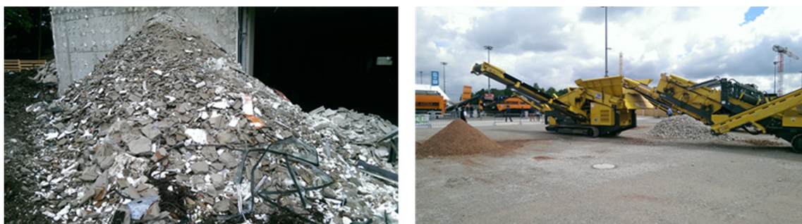
Abbildung 68: Gebäuderückbau mit heterogenem Stoffgemisch (links) - Mobile Aufbereitungsanlagen (rechts) (Eigene Bilder)
