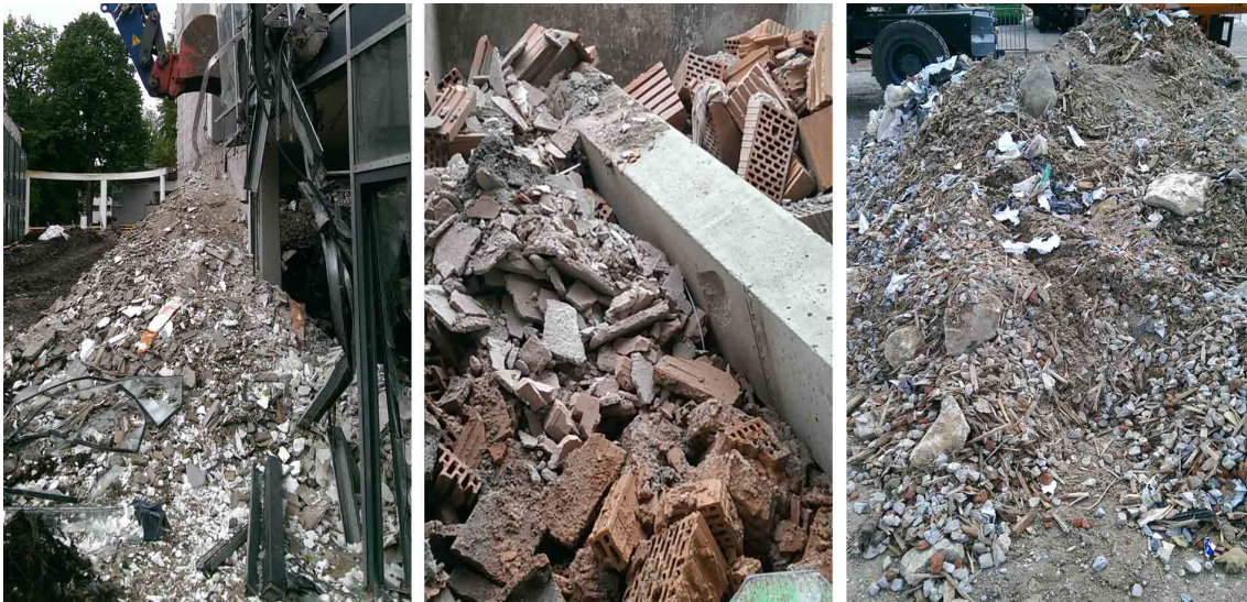
Abbildung 19: Beispielhafte Stoffgemische aus dem Abbruch anhand unterschiedlicher Abbruchbaustellen (Eigene Darstellung)
