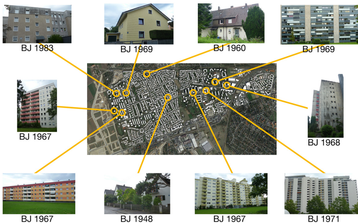
Abbildung 98: Verteilung von Gebäudetypen und Baujahr in Freiam (Eigene Bilder)
