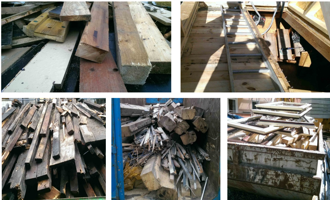
Abbildung B.6: Nachträglicher Einbau von Dachgauben und Vor-Ort-Sortierung von Holzfraktionen (Eigene Bilder)
