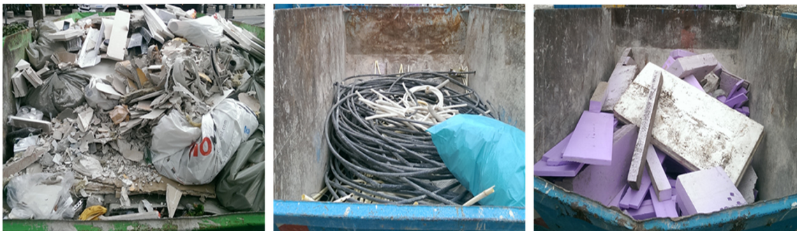
Abbildung 67: Beispiele für eine getrennte Sortierung von Bauabfällen auf ausgewählten Baustellen (Eigene Bilder)
