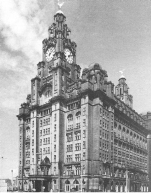
Abb. 21: Das Liver-Building in Liverpool, das nach System Hennebique 1909 errichtet wurde (Bussel 1996, S. 28).
