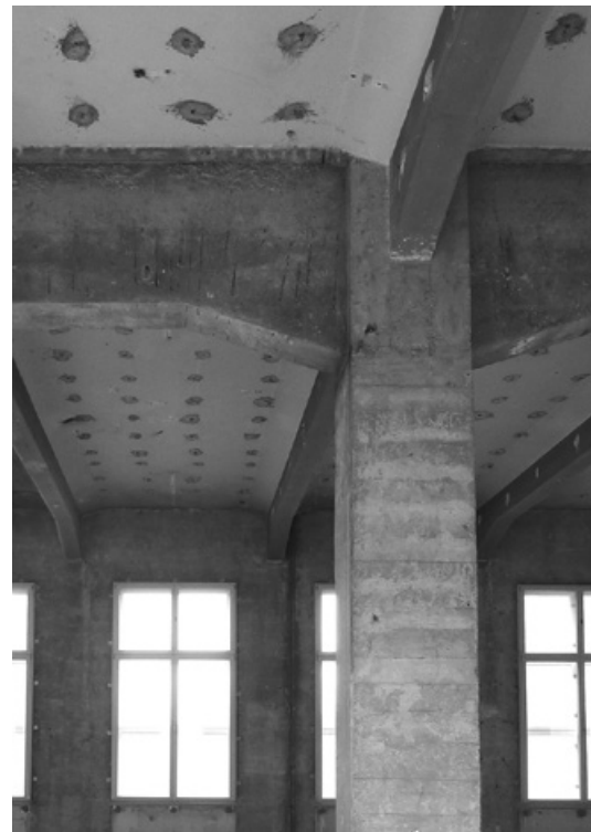
Abb. 590: Ablesbare Bügelbewehrung (Foto: JR).
