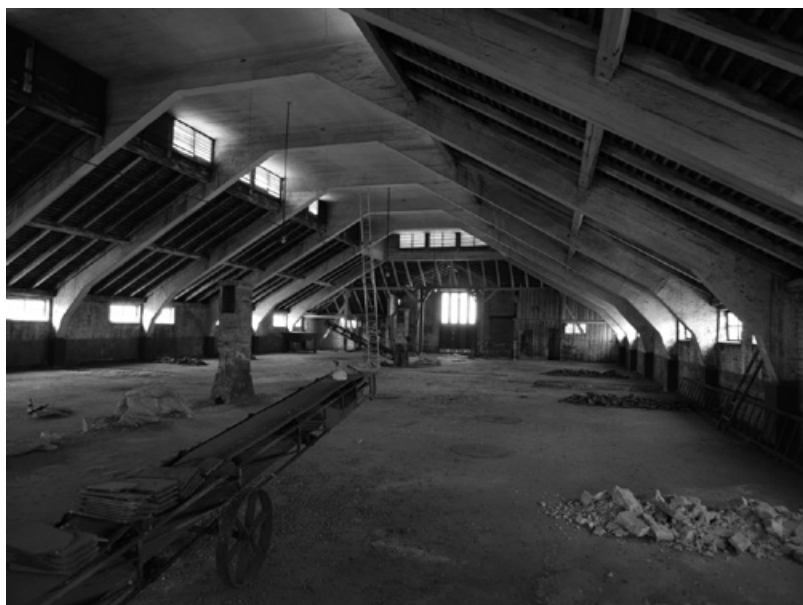
Abb. 707: Dachraum des Reinigergebäudes (Foto: JR).
