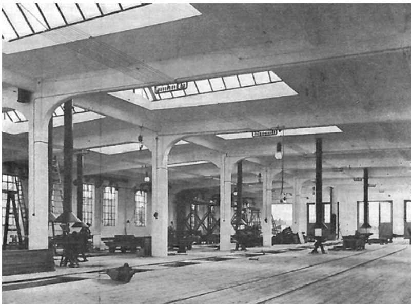
Abb. 559: Historische Innenansicht Montagehalle (DBZ 1915, Nr. 4, S. 29).
