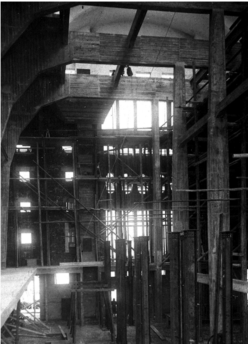
Abb. 353: Rohbau des Ofenhauses, Gaswerk Augsburg um 1914 (Archiv Gaswerksfreunde Augsburg e.V., Bild 179).
