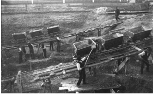
Abb. 350: Bodenaushub, Gaswerk Augsburg um 1914 (Archiv Gaswerksfreunde Augsburg e.V., Bild 065a).
