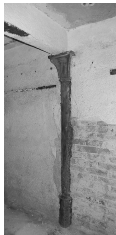
Abb. 368: Gusseiserne Stütze im Keller (Foto: JR).
