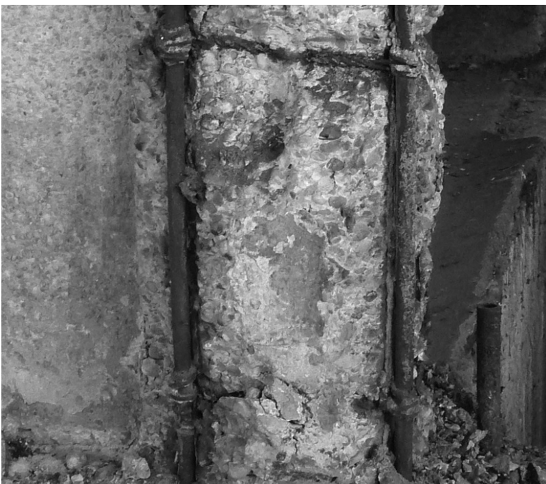
Abb. 293: Bügelbewehrung im Reinigergebäude, Gaswerk Augsburg (Foto: JR).
