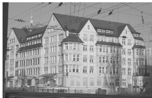
Abb. 640: Von den Bahngleisen gesehen (Foto: JR).
