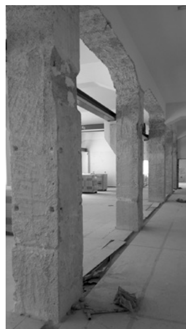
Abb. 682: Skelettkonstruktion im Bereich der ehemaligen Laborräume mit Kranbahn (Foto: JR).
