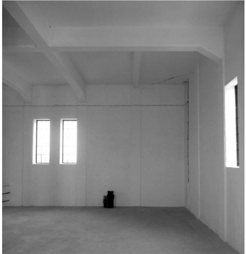
Abb. 90: Skelettstruktur im Wasserturm von Schwabmünchen (Foto: JR).
