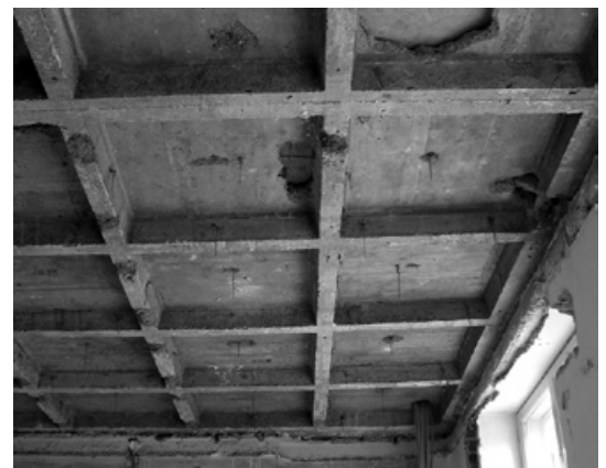
Abb. 290: Eine Hennebiquedecke im Gisela-Gymnasium in einer Aufnahme von 2007 (Foto: JR).
