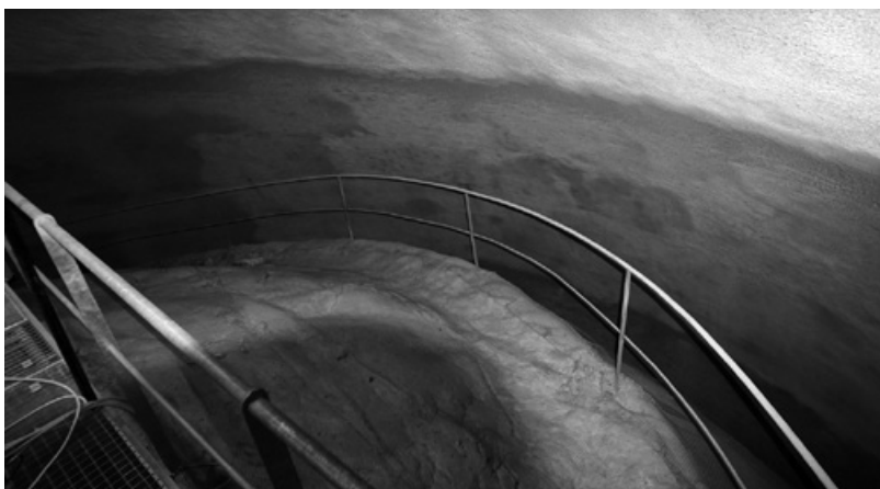
Abb. 426: Der spiralförmig angelegte, rampenartige Aufgang auf der inneren Kuppelschale ist vollständig erhalten, darf jedoch nicht genutzt werden (Foto: JR).
