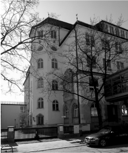
Abb. 670: Treppenhaus, von der Straße aus gesehen (Foto: JR).
