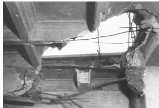
Abb. 143: Kassettendecke von Wilkinson um 1865; Dokumentation während des Abbruchs 1955 (Haegermann 1964, S. 28).
