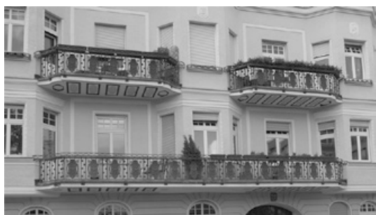
Abb. 213: Auskragende ebene Decken als Elemente der architektonischen Gestaltung, hier in der Richard-Wagner-Straße, München (Foto: JR).
