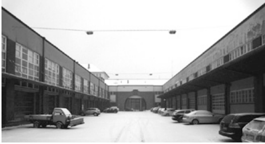
Abb. 758: Erschließungsgasse, rechts Säulenhalle (Foto JR).
