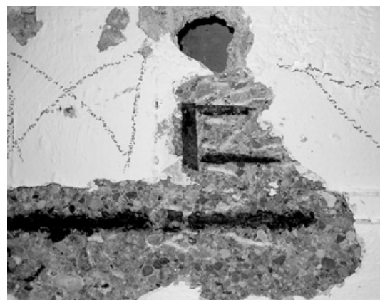
Abb. 23: Bewehrungsdetail an einem Deckenunterzug im Haus Pronath in München (Foto: JR).
