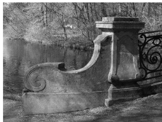
Abb. 775: In Stampfbeton ausgeführter Pfeiler mit steinmetzmäßiger Bearbeitung (Foto: JR).
