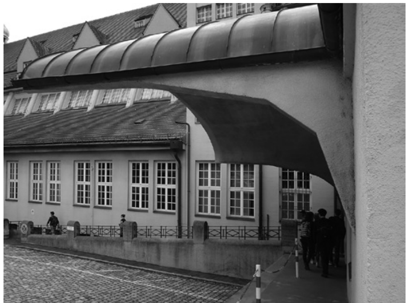
Abb. 265: Ein Vordach am Hauptzollamt im Bereich einer Laderampe (Foto: JR).
