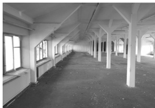
Abb. 538: Dachraum mit Holztragwerk (Foto: JR).
