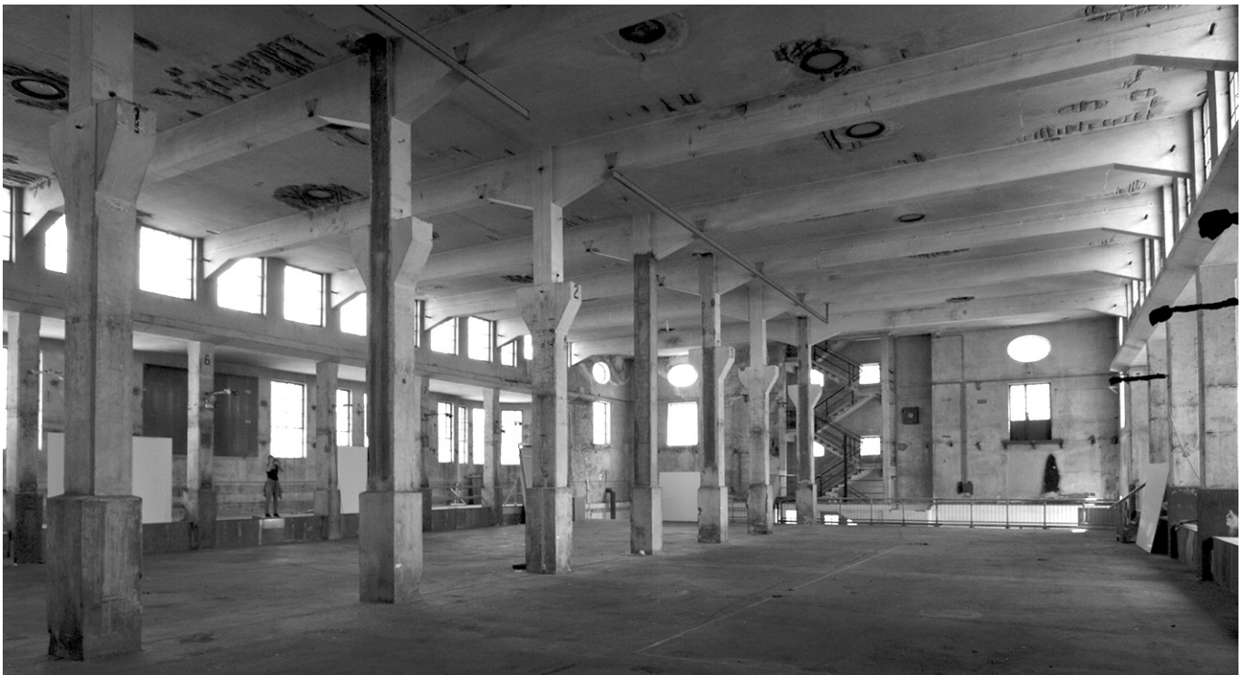
Abb. 704: Innenraum (Foto: JR).
