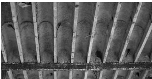
Abb. 154: Koenen'sche Plandecke oder Betonrippendecke um 1904 im Gisela-Gymnasium (Foto 2007, JR).
