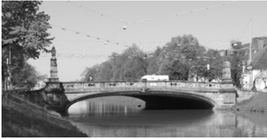
Abb. 763: Ludwig–Ferdinand–Brücke (Foto: JR).
