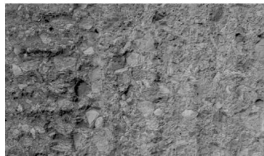
Abb. 208: Sichtbeton, steinmetzmäßig nachbearbeitet am Deutschen Museum um 1914 (Foto: JR).
