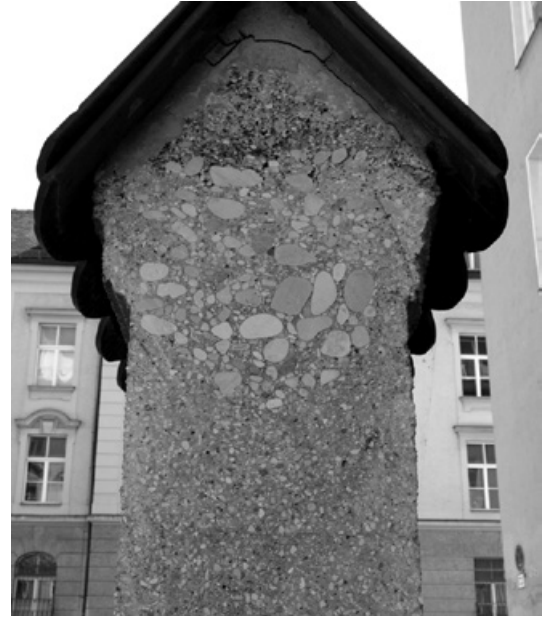
Abb. 316: Betonzusammensetzung an einer Einfriedung bei der Polyklinik (Foto: JR).
