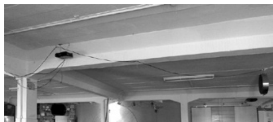
Abb. 81: Kuvertfabrik in Pasing, Deckenuntersicht mit Vouten zwischen Platte und Unterzügen (Foto: JR).
