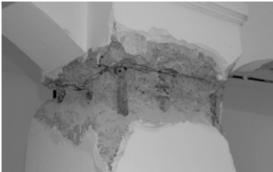
Abb. 299: Maschinenhalle des ehem. Arbeitermuseums: Stützenbewehrung (Foto: JR).
