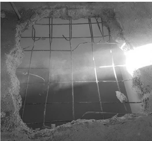
Abb. 305: Bewehrungsverlauf nachgezeichnet (Vorlage Ferroskan aus Dt. Museum. JR).
