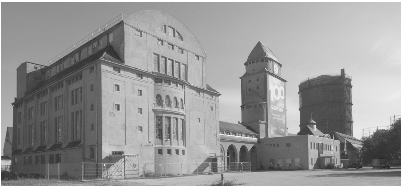
Abb. 698: Das Gaswerk in Augsburg. Im Vordergrund das Ofenhaus (Foto: JR).
