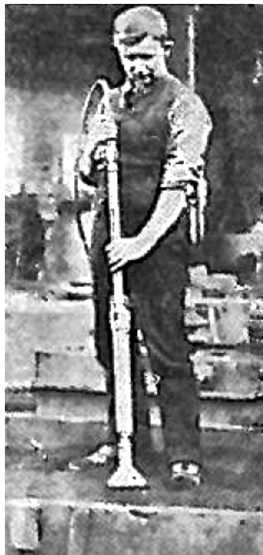
Abb. 200: druckluftbetriebene Rüttelplatte zur Verdichtung von Beton (Kollmann et.al 1912, S. 39).
