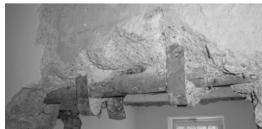
Abb. 442: Bewehrung eines Unterzugs im Südflügel nach System Hennebique (Foto: JR).
