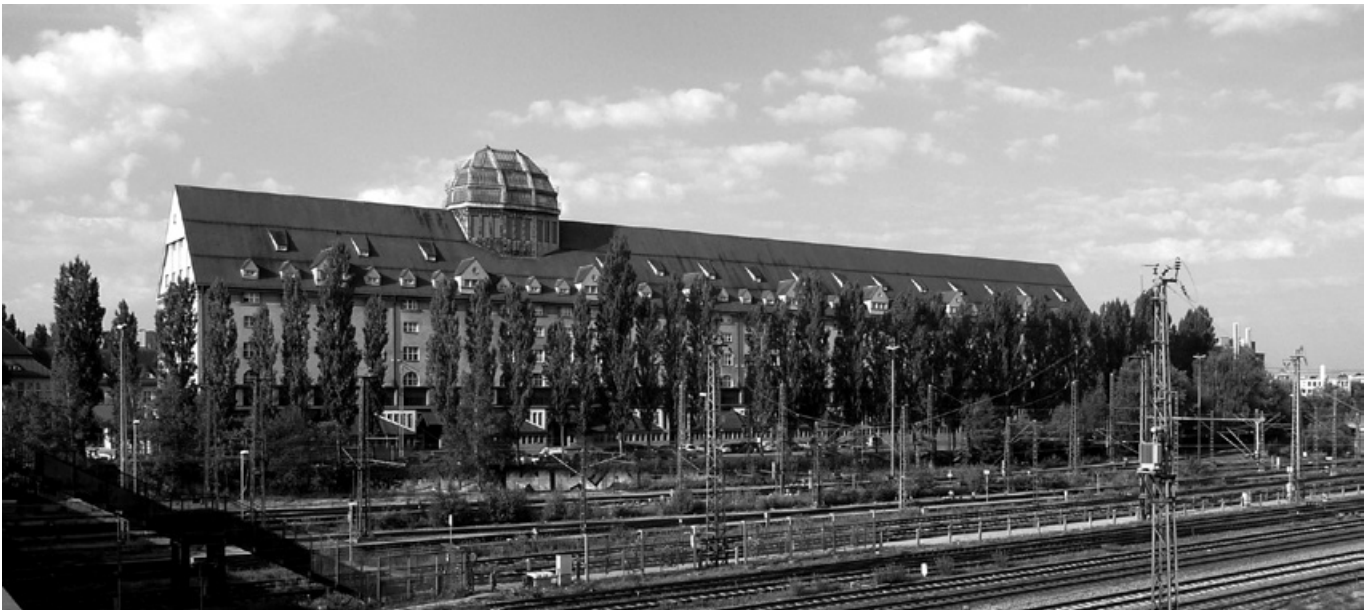
Abb. 272: Das Hauptzollamt in München von Norden gesehen (Foto: JR).
