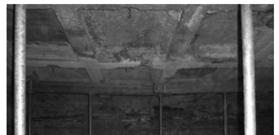
Abb. 340: Kassettendecke mit Durchhang im Obergeschoss des Flügelbaus des Thierschbaus der TUM (Foto: JR).
