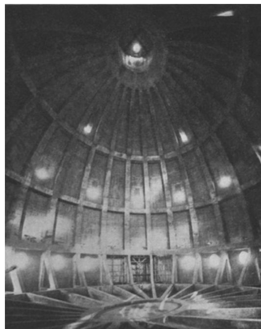
Abb. 575: Historische Aufnahme des Raumes unter der Kuppel (Emperger 1914, S. 76).
