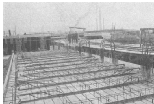
Abb. 625: Bewehrung von Unterzugsdecken (Emperger 1913, Abb. 26).
