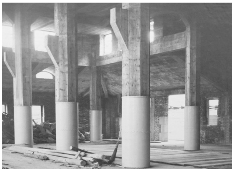
Abb. 624: Historische Aufnahme nach Abschluss der Betonarbeiten in der Zollhalle (Archiv Hauptzollamt).
