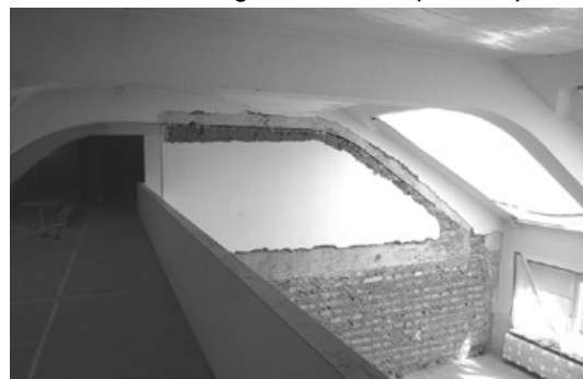
Abb. 684: Binderkonstruktion im DG (Foto: JR).
