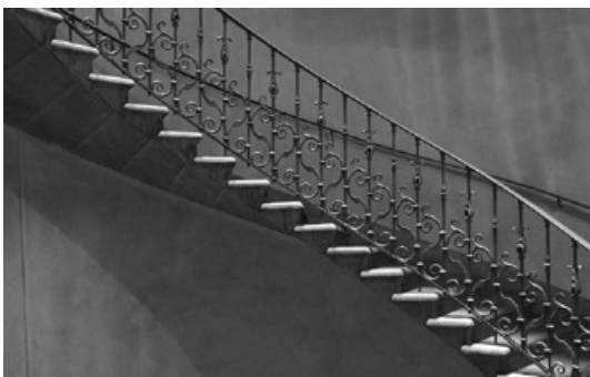
Abb. 378: Detailansicht der filigranen Kragstufen (Foto: JR).
