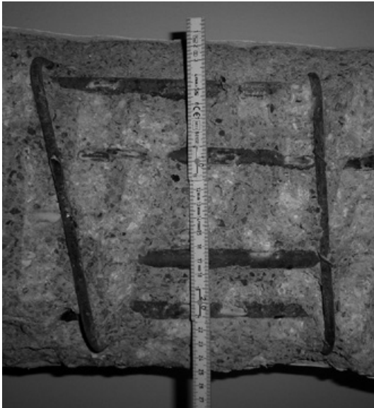
Abb. 35: Bewehrung nach Leitsätzen im Lindwurmhof in München von 1910 (Foto: JR).
