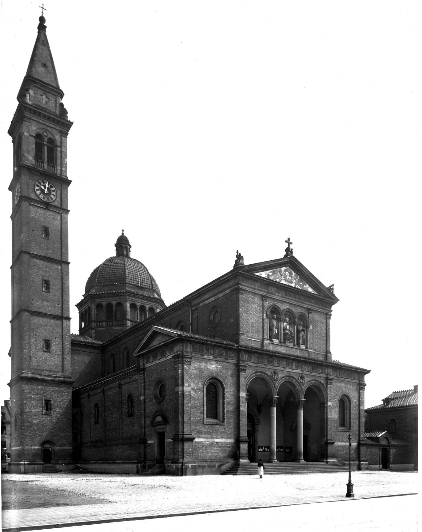
Abb. 254: Außenansicht der Kirche St. Ursula kurz nach der Fertigstellung (AM, Akt-Nr. thie_a-72-1258).
