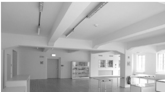
Abb. 745: Skelettkonstruktion Vorhalle (Foto: JR).
