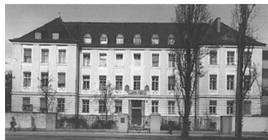
Abb. 569: Straßenansicht des Flügels an der Lindwurmstraße, der 1923 ergänzt wurde (Chevalley et.al 2004, S. 398).
