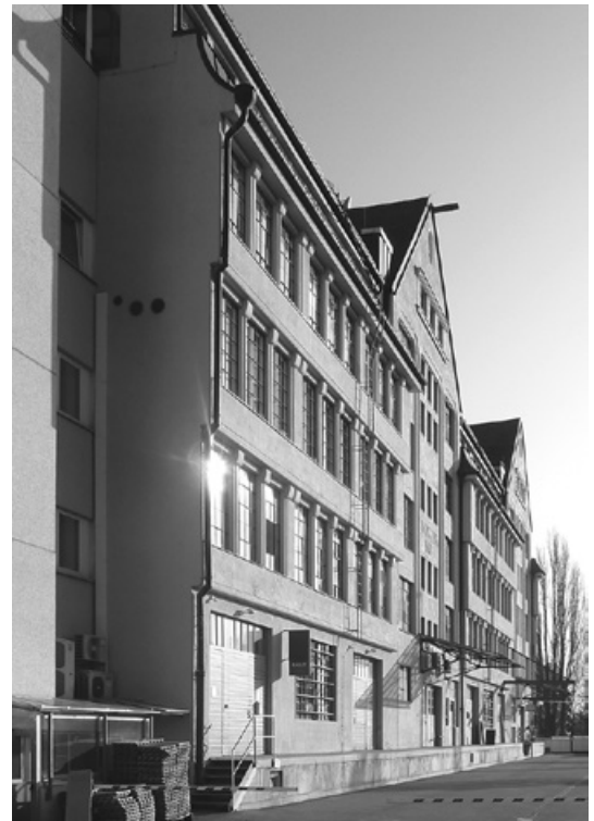
Abb. 643: Fassade zu den Gleisen (Foto: JR).
