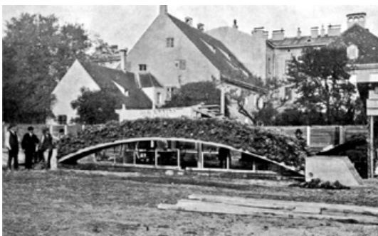
Abb. 179: Bauschingers Belastungsversuch an einer Brückenkonstruktion im Zuge der Erarbeitung der Monier-Broschüre (Stegmann et.al 2017, S. 550).
