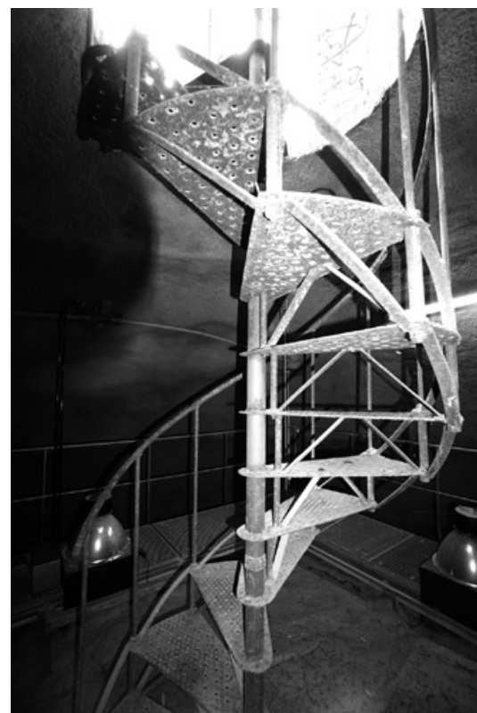
Abb. 428: Die noch aus der Errichtungszeit stammende Spindeltreppe aus Eisen führt in die Laterne (Foto: JR).
