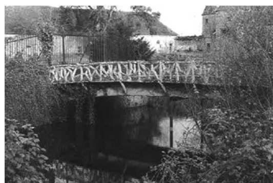
Abb. 160: Brücke nach System Monier bei Chazélet aus den 1870er Jahren (Bosc et.al 2001, S. 95).
