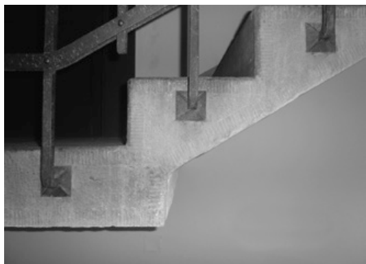
Abb. 450: Treppenaufgang aus Eisenbeton (Foto: JR).
