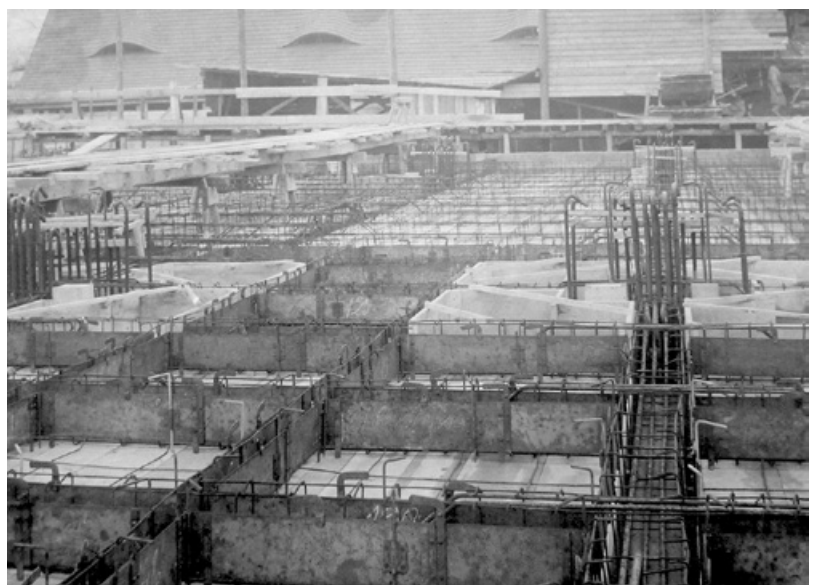
Abb. 352: Schalung der Balken mit Blechen beim Zollamt in München (Archiv Hauptzollamt).
