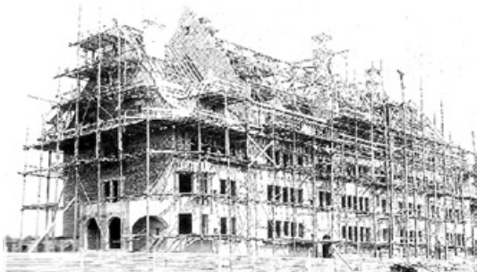
Abb. 454: Schule im Bau (Süddeutsche Zeitung 2005).
