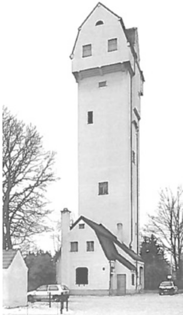
Abb. 237: Wasserturm in Neuau- bing (Chevalley 2004, S. 50).
