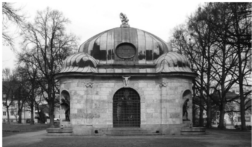
Abb. 409: Das Brunnenhaus an seinem jetzigen Standort (Foto: JR).
