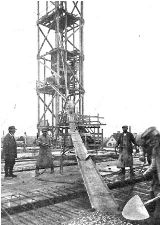
Abb. 197: Schüttbetonanlage, konstruiert durch die Baunternehmung Gebrüder Rank (DBZ 1915).
