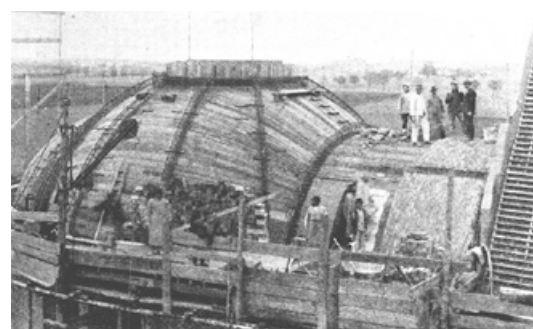
Abb. 666: Schal- und Bewehrungsarbeiten an der Kuppel (Emperger 1915, S. 145).
