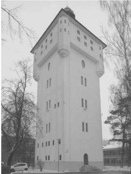
Abb. 599: Aktuelle Ansicht mit Veränderungen an der Fassade (Foto: JR).
