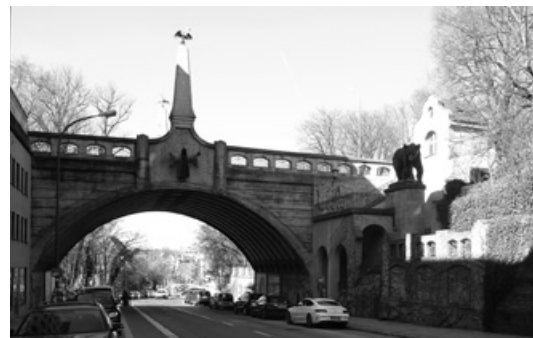
Abb. 770: Gebattelbrücke (Foto: JR).
