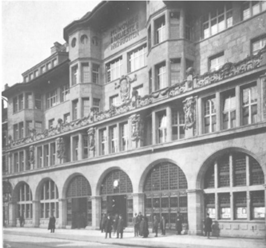
Abb. 444: Historische Straßenansicht (DBZ 1906, S. 358).
