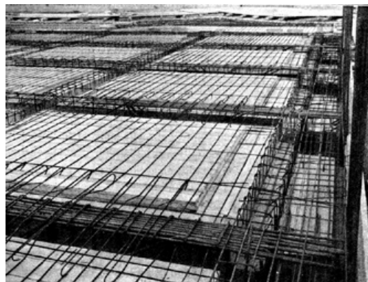
Abb. 693: Bewehrung einer Decke (Empferger 1915, Abb. 182).
