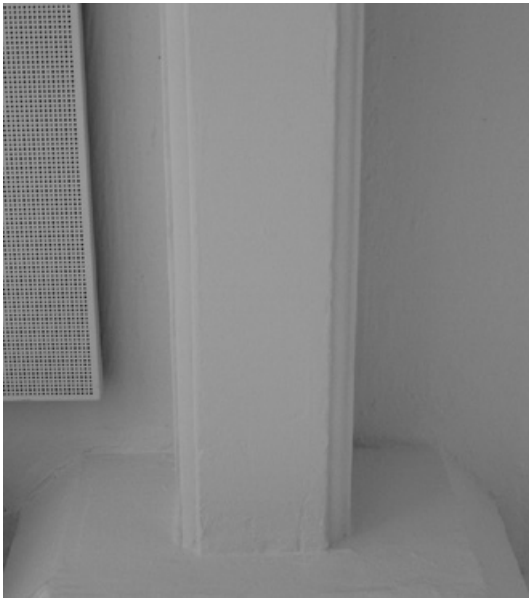
Abb. 315: Die Kanten von Unterzügen wurden auch bei nachgeordneten Gebäudeteilen mit Kantenprofilen gebrochen, die Betonoberflächen anschließend mit einem Anstrich versehen wie hier im Haus Pronath (Foto: JR).
