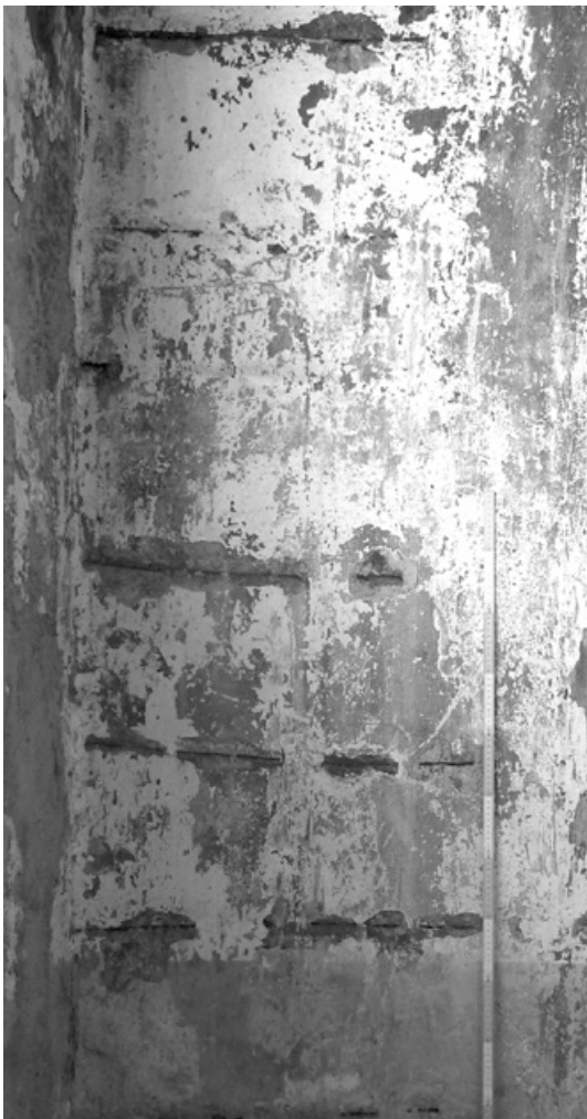
Abb. 300: Ofenhaus des Gaswerks Augsburg, Bügel bei einer Binderstütze (Foto: JR).
