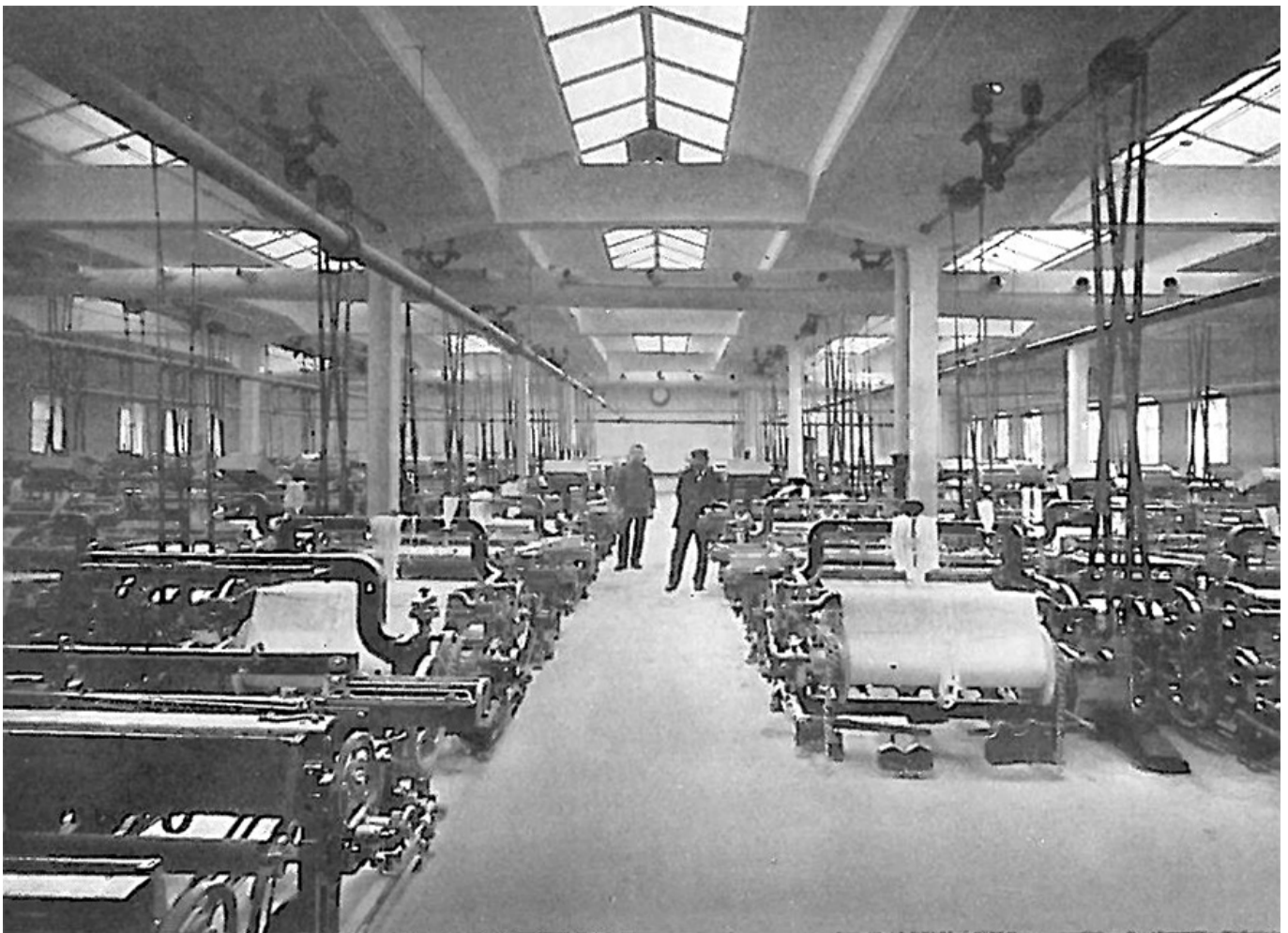
Abb. 27: Eine Weberei in Frauenalb mit Transmissionen, die an den Eisenbetonkonstruktionen befestigt sind (Mörsch 1912, S. 245).
