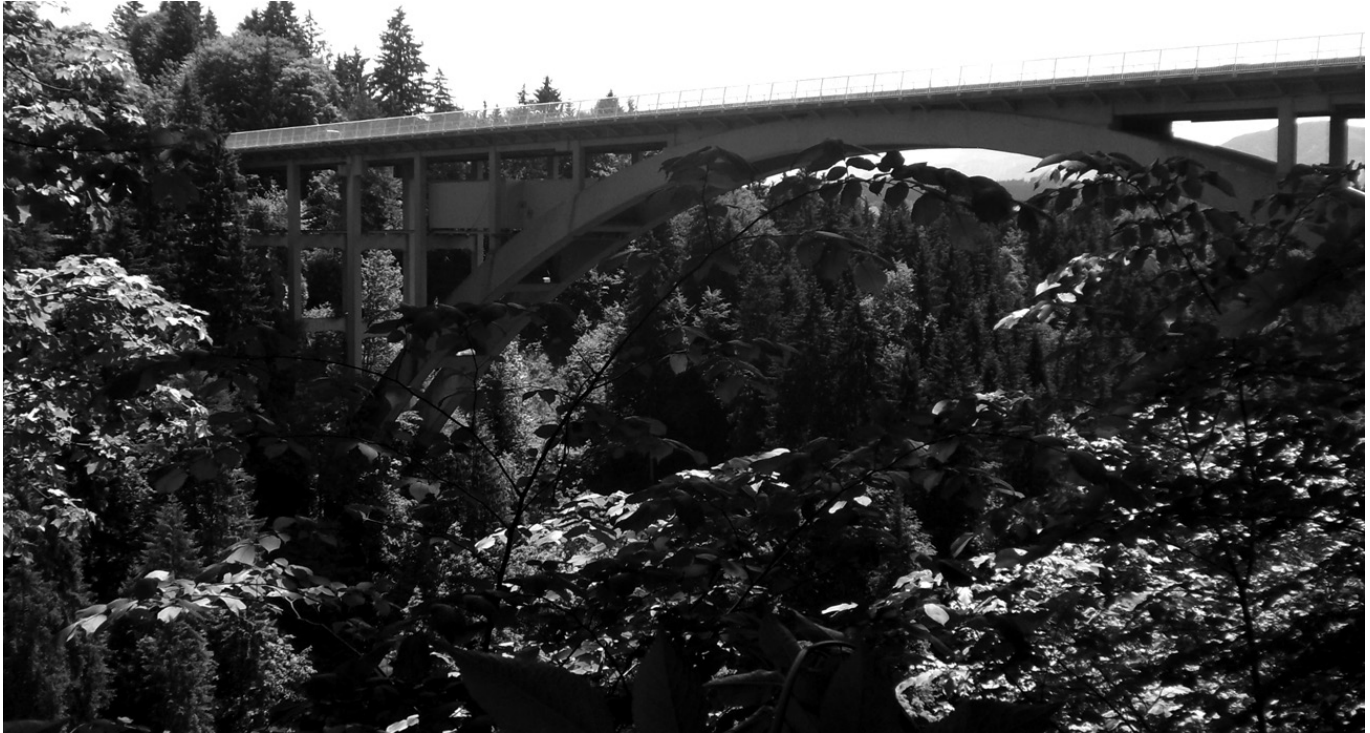
Abb. 169: Die Echelsbacher Brücke nach dem System Melan von 1929 mit 130 m Spannweite (Foto 2012: JR).
