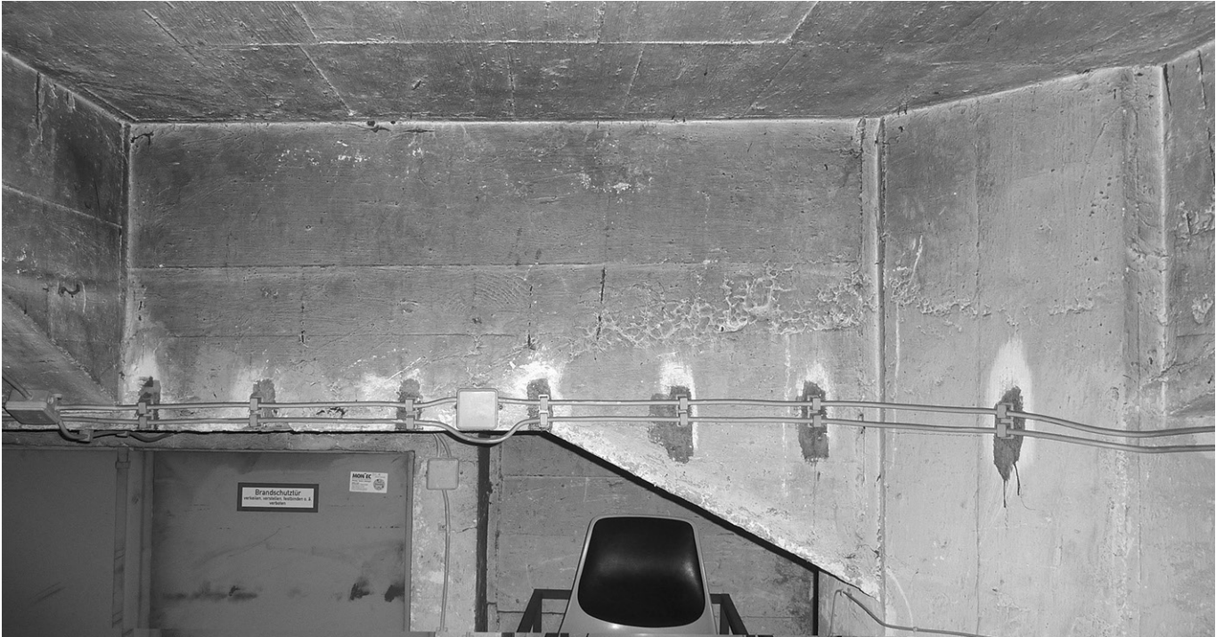
Abb. 326: Lindwurmshof, Kellergeschoss: der Betonierabschnitt zeichnet sich durch die verminderte Dichte des Betons ab (Foto: JR).
