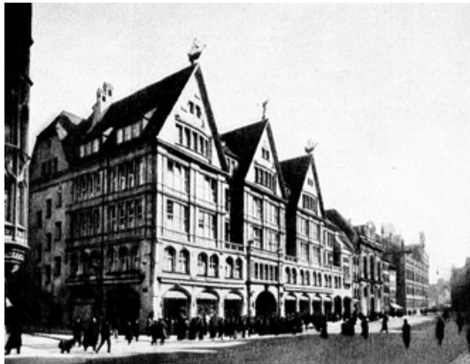
Abb. 404: Historische Straßenansicht des Kaufhauses (BAI 1912, S. 316).
