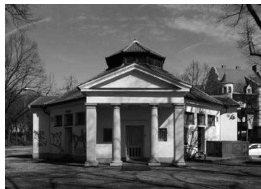
Abb. 367: Ansicht von Süden mit Blick auf den Portikus, Zustand 2017 (Foto: JR).
