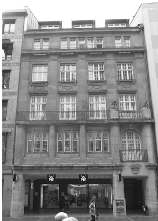
Abb. 562: Straßenfassade (Foto: JR).
