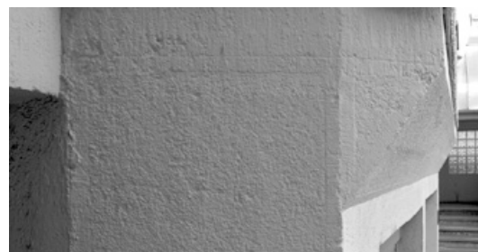
Abb. 207: In Sichtbeton immitierter Steinschnitt am Haus Pronath von 1907 (Foto: JR).
