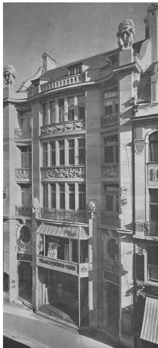
Abb. 393: Das Gebäude kurz nach der Fertigstellung (SBZ 1904, S. 258).
