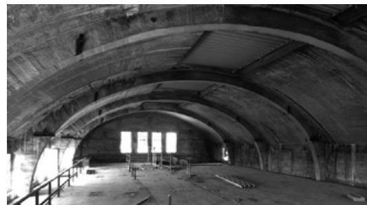
Abb. 700: Dachraum (Foto: JR).
