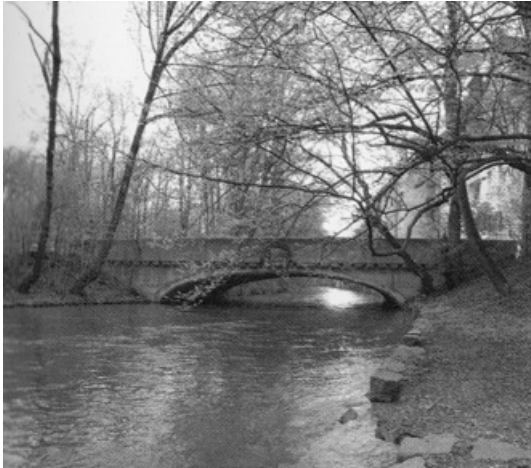
Abb. 778: Ansicht der Brücke (Rädlinger 2008, S. 243).
