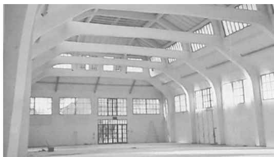
Abb. 520: Innenraum nach Fertigstellung (Chevalley 2004, S. 633).
