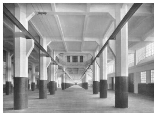
Abb. 627: Zollhalle im Erdgeschoss (Zentralblatt der Bauverwaltung 1912, S. 17).
