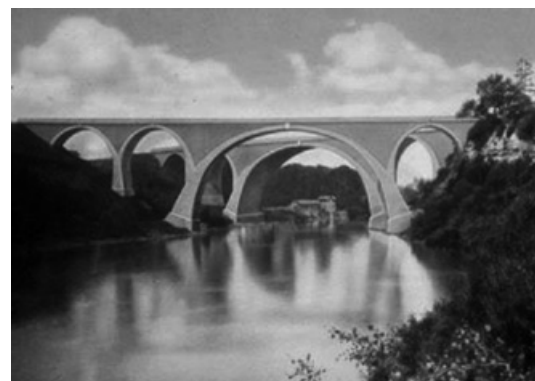
Abb. 182: Die Illerbrücken bei Kempten 1904 (DBZ 1906, S. 219-222).
