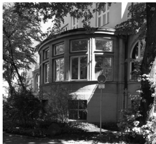
Abb. 452: Außen betonsichtige Skelettkonstruktion des OP–Saales auf der Nordseite des Gebäudes (Foto: JR).
