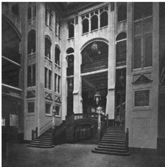
Abb. 406: Lichthof, Konstruktion aus umhüllten Eisenprofilen (Mecenseffy 1911, S. 9).
