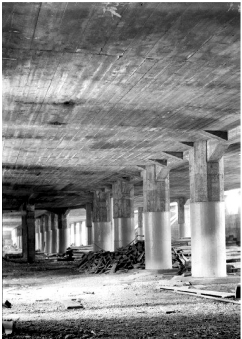
Abb. 271: Das Hauptzollamt: Baustellenfoto von der Zollhalle um 1912 (Archiv Hauptzollamt).
