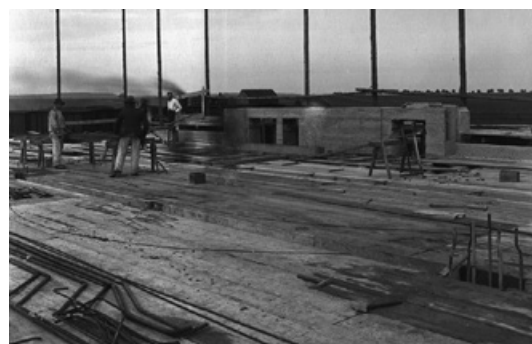
Abb. 710: Schal- und Bewehrungsarbeiten im September 1913 (Archiv Gaswerksfreunde Augsburg e.V., Bild 020).
