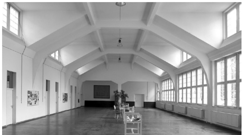
Abb. 91: Rahmentragwerk, das als Binderkonstruktion in einer Halle im Hauptzollamt in München ausgeführt wurde (Foto: JR).
