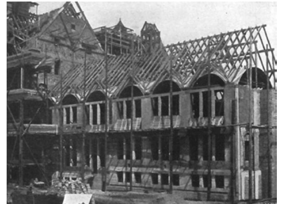
Abb. 487: Der Rohbau der Turnhalle mit dem unter dem hölzernen Satteldach angeordneten Stüchkap-pengewölbe. Die Halle wurde in im Verbindungsbau errichtet (Mörsch 1912, S. 251).
