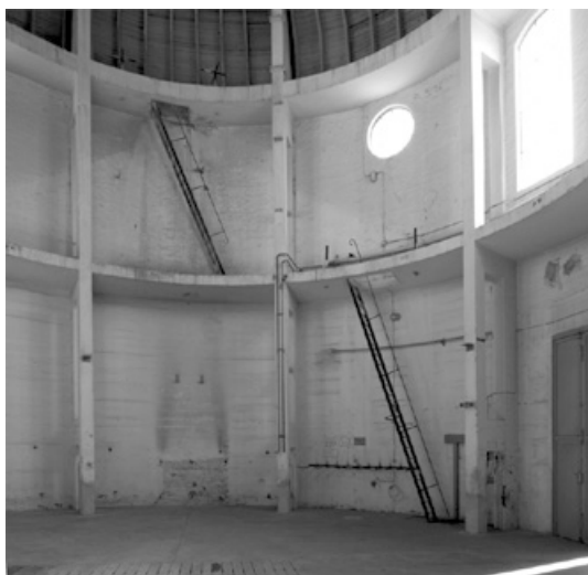
Abb. 713: Innenraum des Gasbehälters (Foto: JR).
