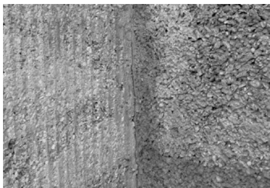
Abb. 212: Kombination unterschiedlicher Betonoberflächen am Deutschen Museum (Foto: JR).
