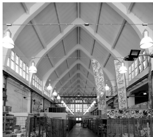
Abb. 658: Innenraum (Foto: JR).
