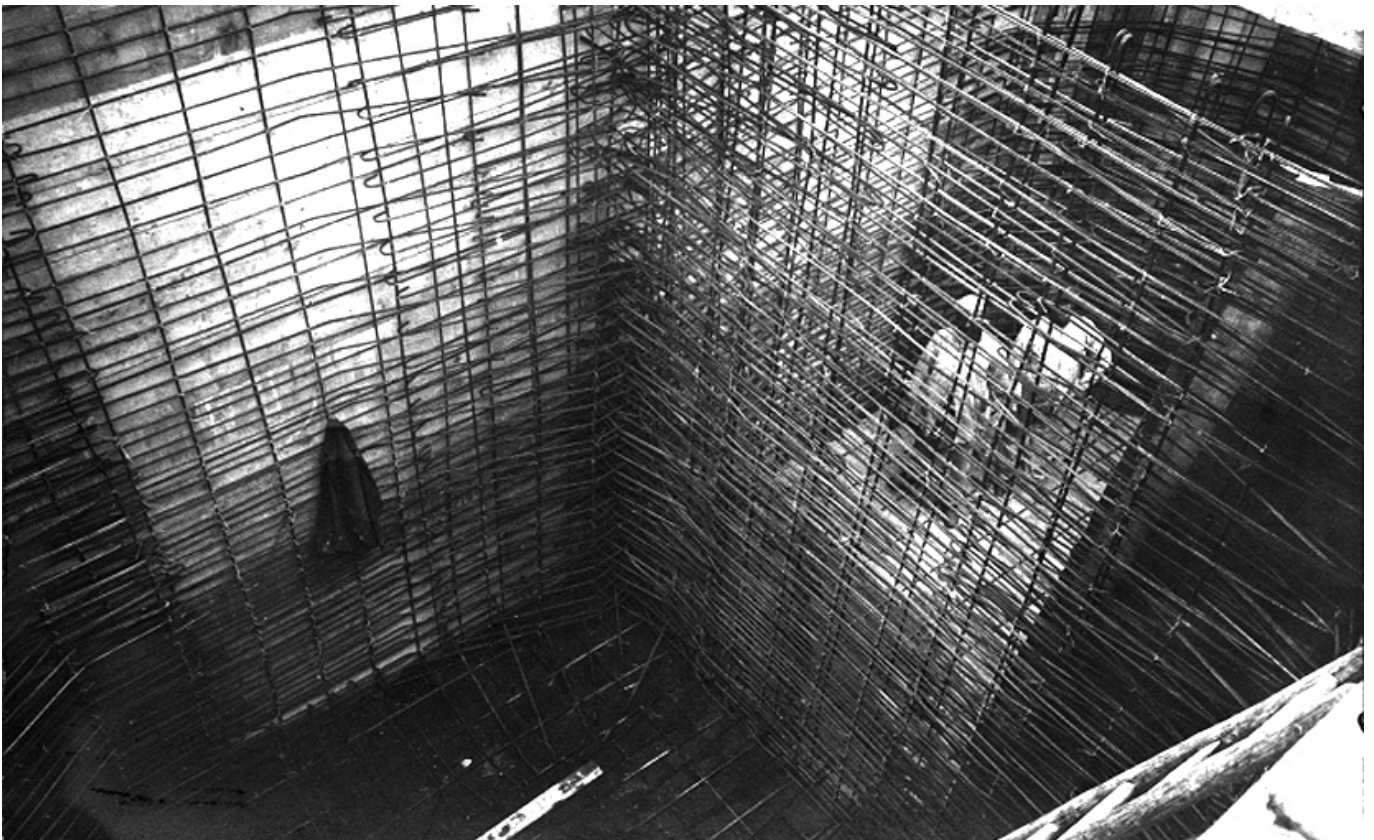
Abb. 354: Bewehrung eines Behälters, Gaswerk Augsburg um 1914 (Archiv Gaswerksfreunde Augsburg e.V., Bild 158).
