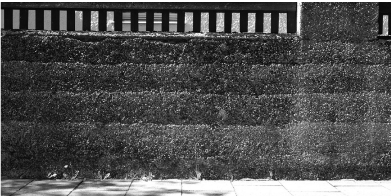
Abb. 320: Stampfbetonsockel einer Einfriedung in der Albrechtstraße in München (Foto: JR).
