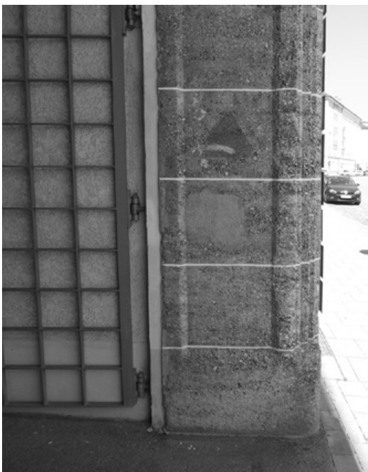
Abb. 664: Detail Sichtbetonarkade (Foto: JR).
