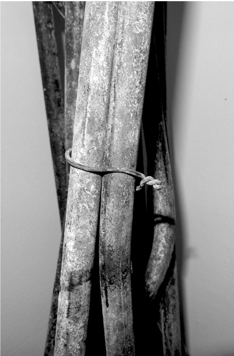
Abb. 31: Rundstabbewehrung, gesehen im Lindwurmhof (Foto: JR).
