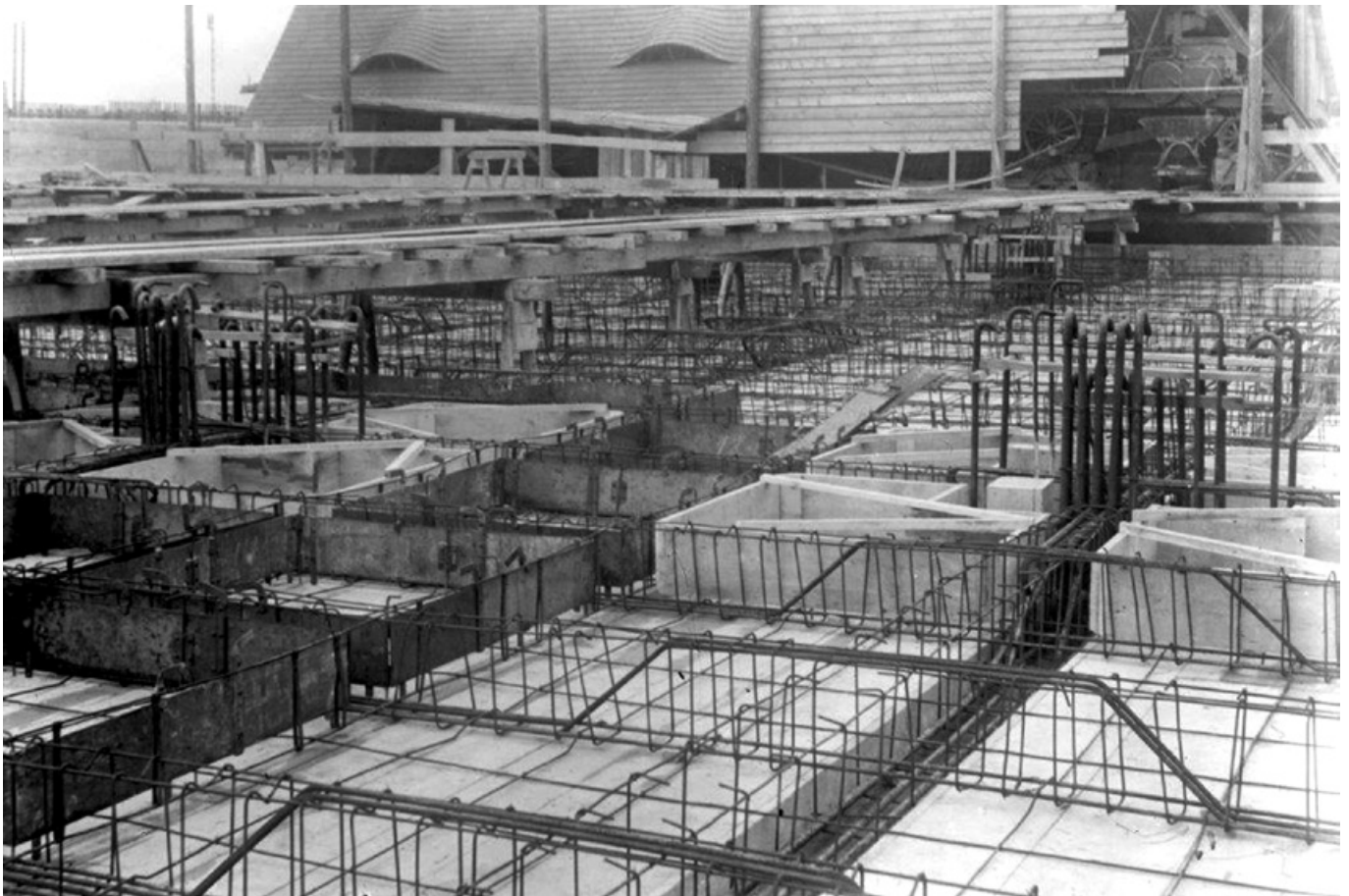
Abb. 294: Schal- und Bewehrungsarbeiten am Hauptzollamt in München in einer Baustellenaufnahme um 1912 (Archiv Hauptzollamt).
