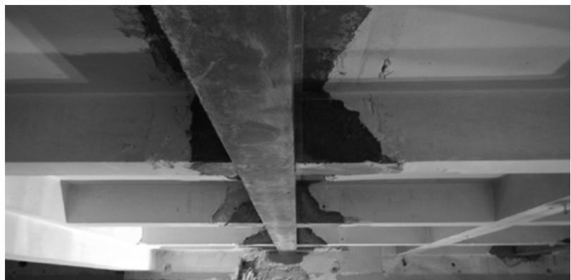
Abb. 342: Ehemaliges Arbeitermuseum: Ertüchtigung einer Rippendecke im Westflügel. Durch Ausnutzung der Bruttomaße der mit Gipsputz versehenen Oberflächen konnten einzelne Rippen querschnittsgleich ersetzt werden (Foto: Josef Jordan).
