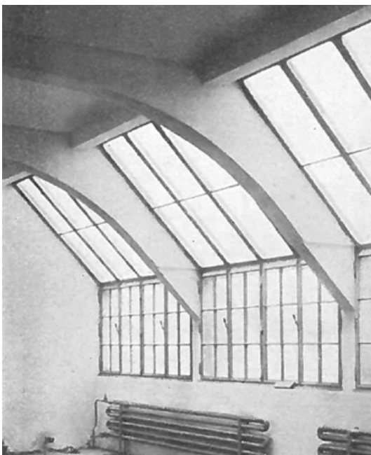
Abb. 446: Binderkonstruktion Dachgeschoss (Mörsch 1906, S. 424).
