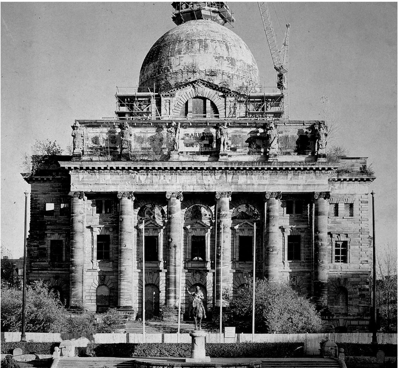
Abb. 355: Der zentrale Mittelbau des ehemaligen Armeemuseums, Zustand in den 1970er Jahren (AM, Akt-Nr. mell-1-1018).
