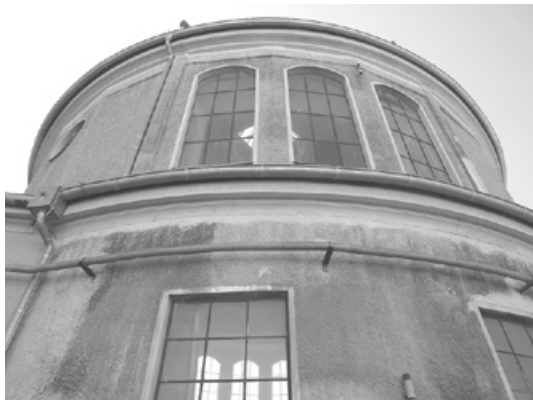
Abb. 714: Detail der Ausführung. Im oberen Teil wurden die Bereiche zwischen den Skelettstützen flach ausgebildet, sodass sich ein polygonaler Grundriss ergibt (Foto: JR).
