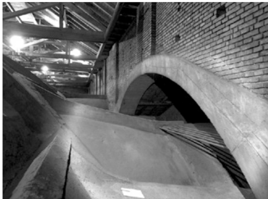
Abb. 541: Stichkappe im Bereich der Vierung (Foto: JR).
