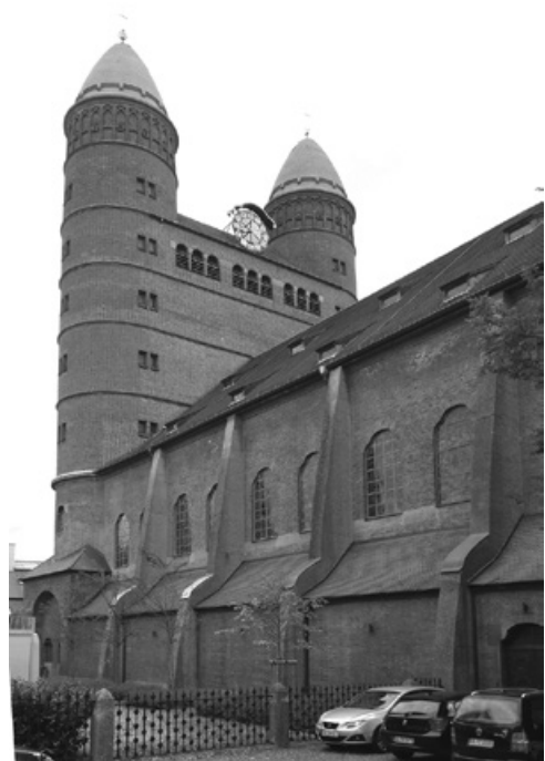
Abb. 253: Die ev. Pauluskirche in Ulm (ehem. Garnisonskirche; Foto: JR).
