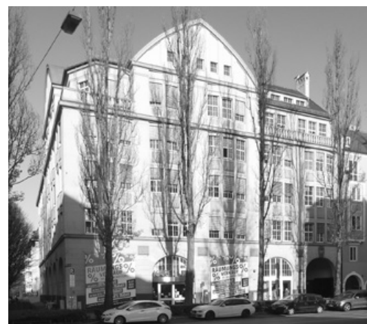
Abb. 738: Ansicht von der Lindwurmstraße (Foto: JR).
