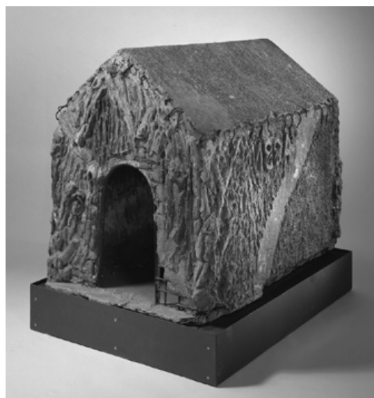
Abb. 138: Hundehütte von Conrad Freytag 1884, der „erste Hochbau aus Eisenbeton“ in Deutschland (Archiv Deutsches Museum, Nr. BN 58267).
