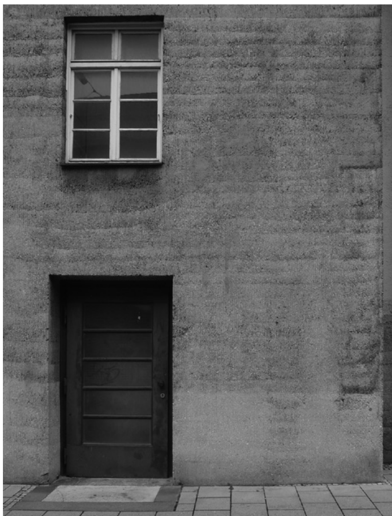
Abb. 734: Ausschnitt der Sichtbetonfassade (Foto: JR).
