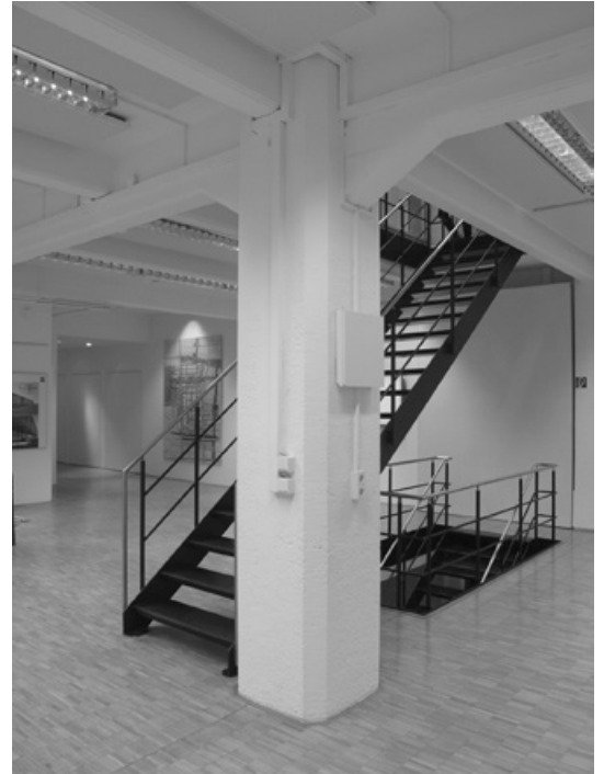
Abb. 301: Skelettkonstruktion im Haus Pronath (Foto: JR).
