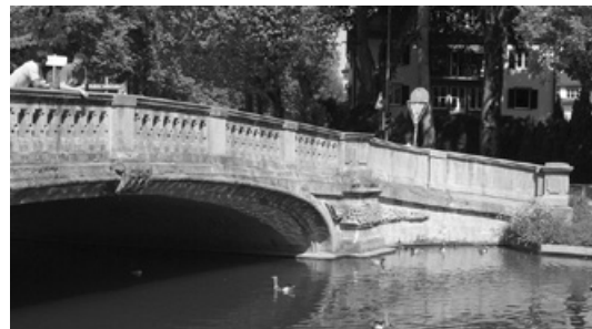
Abb. 767: Detailansicht Anläufer (Foto: JR).
