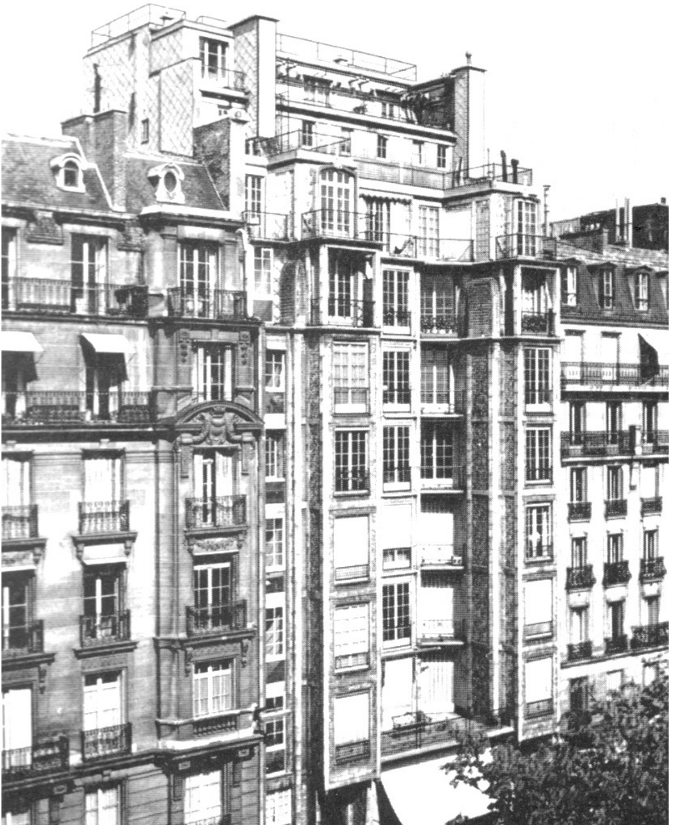
Abb. 204: Das Wohnhaus in der Rue Franklin in Paris, nach Plänen der Gebrüder Peret 1903 als Eisenbetonskelettbau mit keramischer Verkleidung errichtet (Collins 1959, Abb. 50).
