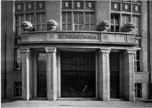
Abb. 728: Eingang, historische Ansicht (Der Baumeister 1914, S. 121).
