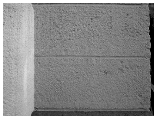
Abb. 740: Detail der Sichtbetonfassade mit Oberflächenbearbeitung (Foto: JR).
