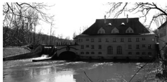
Abb. 500: Turbinengebäude 2018 (Foto: JR).
