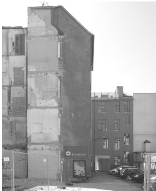
Abb. 505: Ansicht nach Abbruch der Gebäude an der Goethestraße (Foto: JR).
