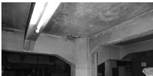
Abb. 311: Kellergeschoss des Lindwurmhofs mit achteckigen Stützen (Foto: JR).
