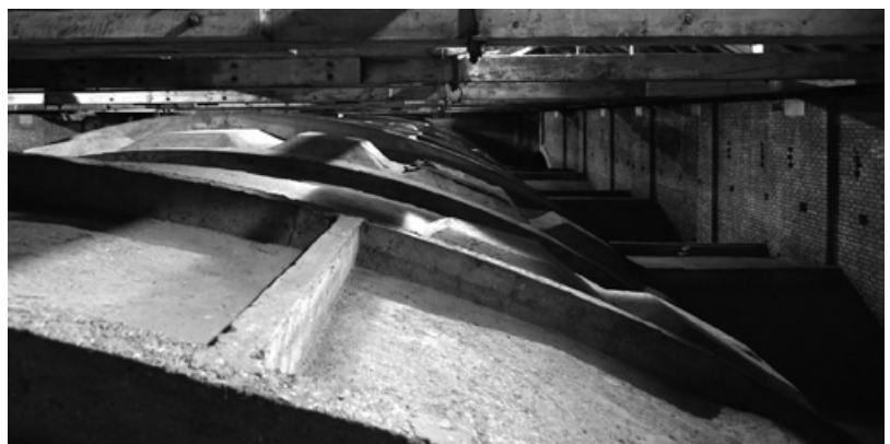
Abb. 86: Stichkappengewölbe über dem Langhaus der katholischen Margaretenkirche in Sendling (Foto: JR).
