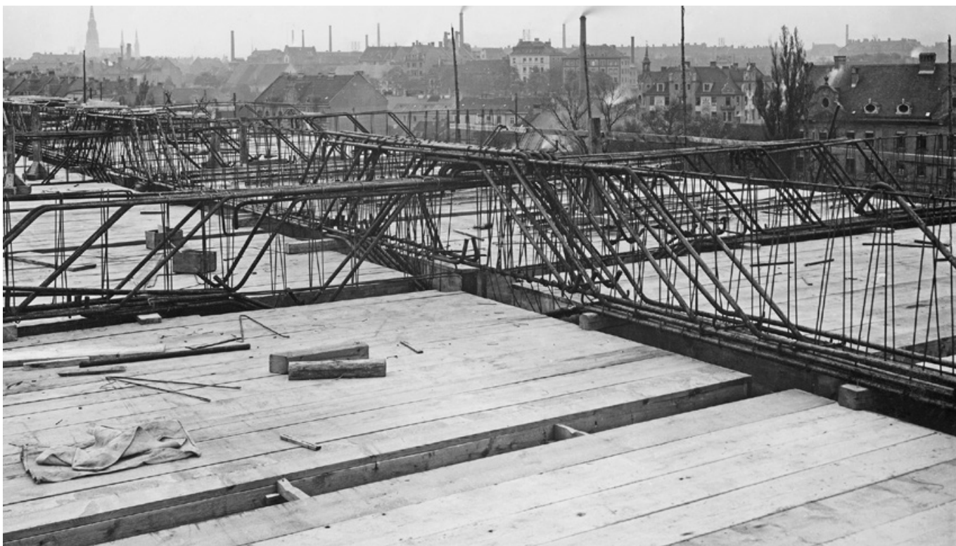
Abb. 589: Bewehrungsführung einer Unterzugdecke (Archiv Deutsches Museum, Reg-Nr. CD 57853).
