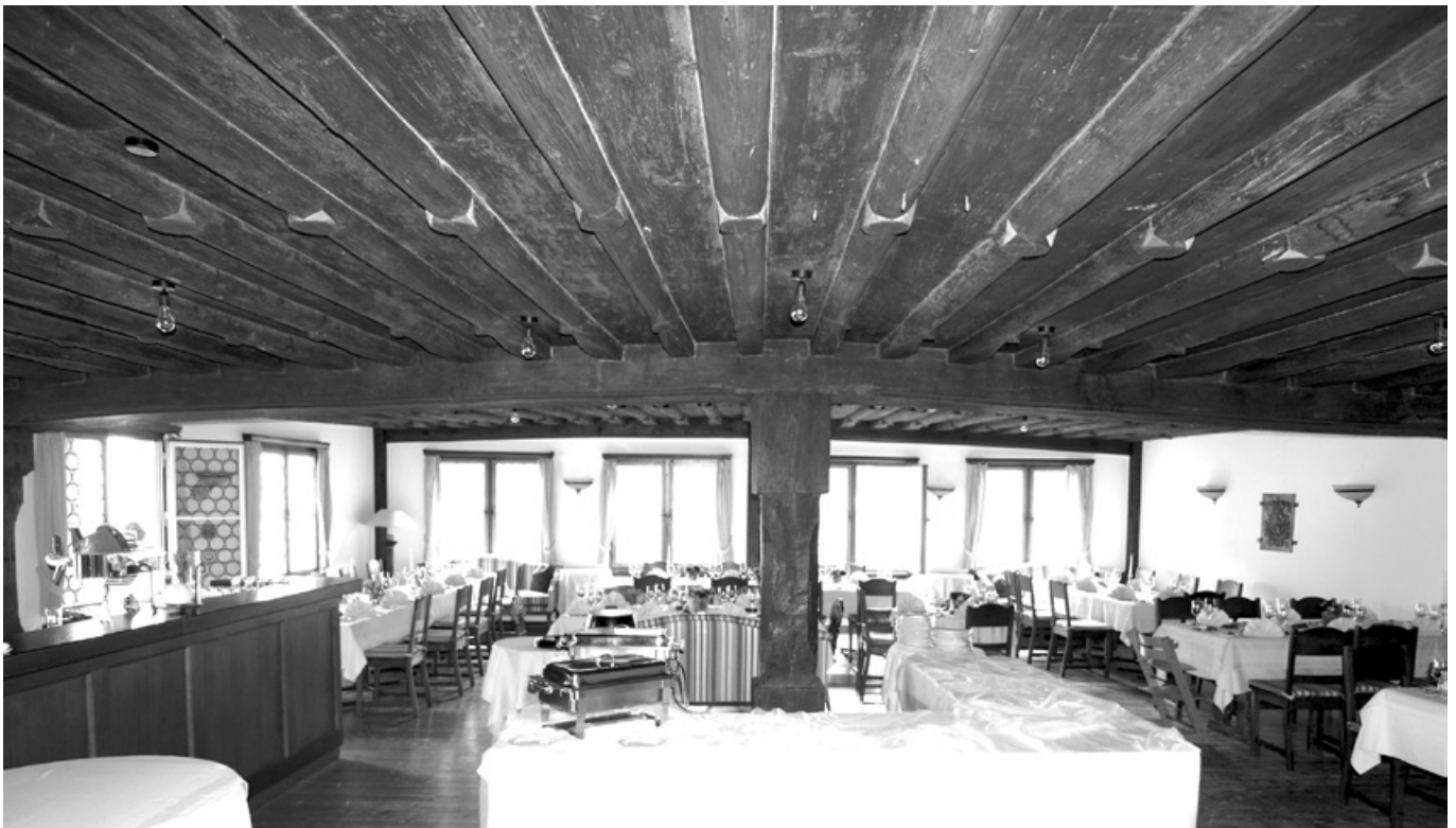
Abb. 54: Bohlen-Balken-Decke in einem mittelalterlichen Gebäude in Ravensburg (Foto: JR).
