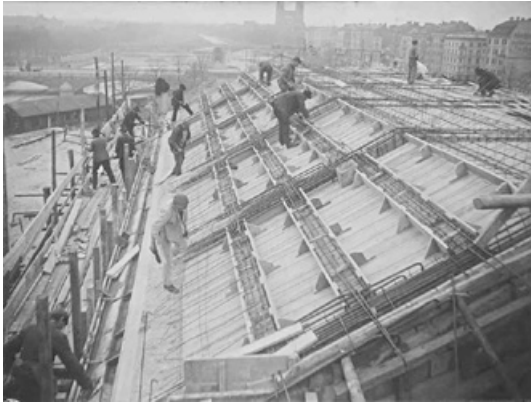
Abb. 580: Bewehrungsarbeiten an einem der Dächer (Archiv Deutsches Museum).
