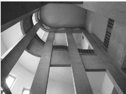
Abb. 587: Treppenraum im Nordwesten (Foto: JR).
