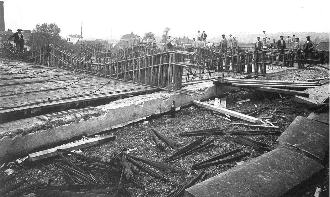
Abb. 133: Bewehrung im System Hennebique um 1907 auf einer Baustelle in Ivry-Port Frankreich (Delhumeau 1993, Abb. 110).
