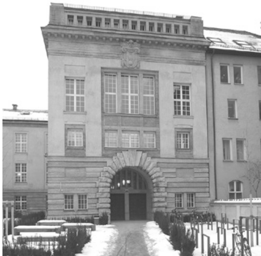
Abb. 464: Flügelbau zur Pettenkoflerstraße (Foto: JR).
