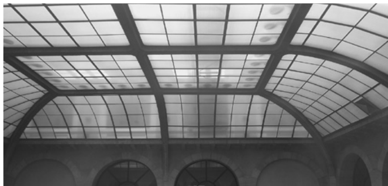
Abb. 451: Verglaste Rippenkuppel über der Schaltherhalle (Foto: JR).
