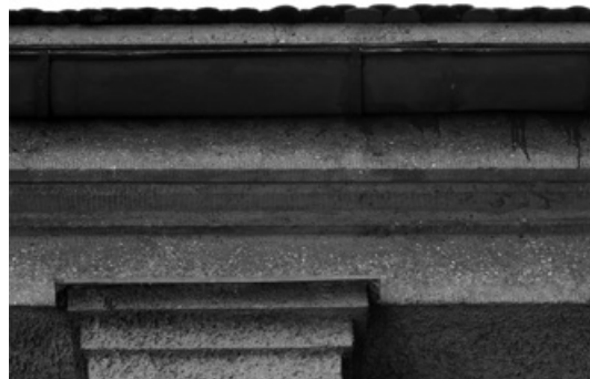
Abb. 709: Gesims mit steinmetzmäßiger Bearbeitung (Foto: JR).
