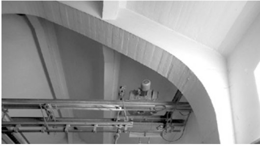
Abb. 614: Binderkonstruktion mit Schalungsabdrücken (Foto: Christian Kayser).
