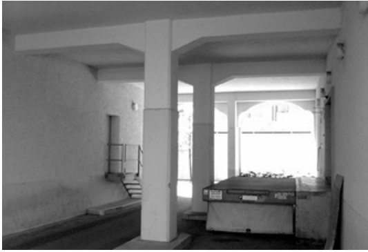
Abb. 662: Skelettstrukturen in den Durchfahrten (Foto: JR).
