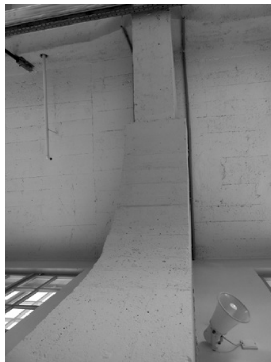
Abb. 746: Detail eines Bogenbinders mit Deckenuntersicht. Die Schalungsabdrücke sind gut erkennbar (Foto: JR).
