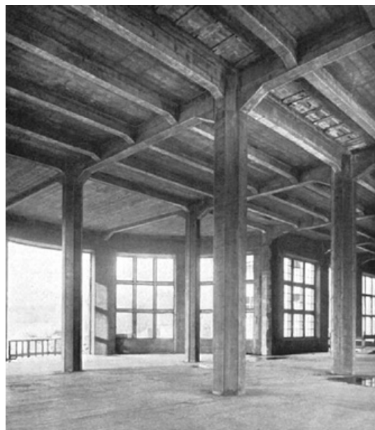
Abb. 586: Historische Aufnahme im Bereich des Südflügels (Matschoß 1933, S. 59).
