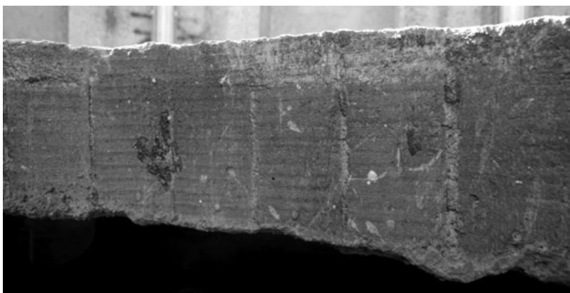
Abb. 425: Der innere Rand der Kuppelöffnung wurde mit Ziegelsteinen geschalt (Foto: JR).
