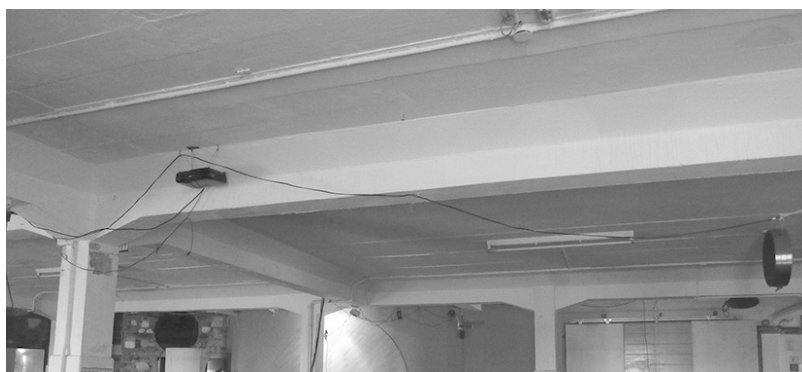
Abb. 460: Unterzugsdecke (Foto: JR).
