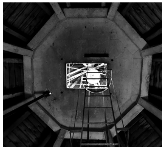
Abb. 481: Blick in die Dachkonstruktion unterhalb der Laterne (Foto: Sandra Glück).
