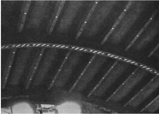
Abb. 281: Gewölbte Plattenbalkendecke in der ehemaligen Garnisonskirche in Ulm (Mecenseffy 1911, S. 190).
