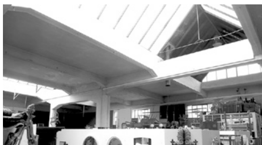
Abb. 689: Blick in den Innenraum einer der Werkhallen mit Oberlichtern (Foto: JR).
