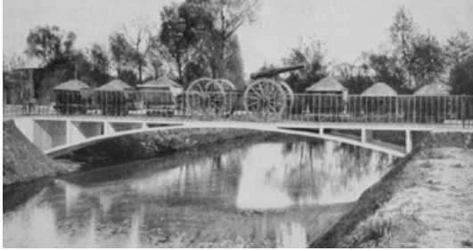
Abb. 165: Bogenbrücke in Ingolstadt um 1890 (Ramm 2012).
