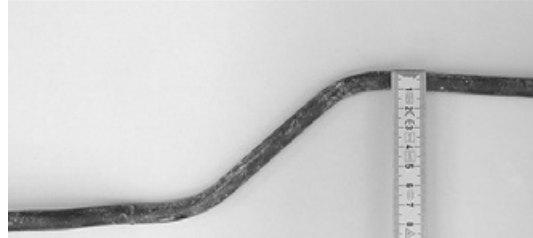
Abb. 306: Verkröpfte Deckenbewehrung an einem Durchbruch im Lindwurmhof unter dem Dachgeschoss (Foto: Christian Kaut, JR).
