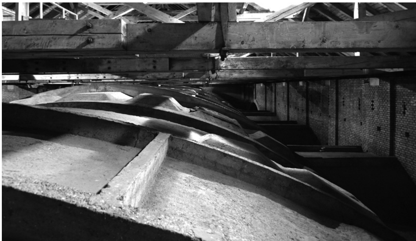
Abb. 542: Gewölbeoberseite (Foto: JR).
