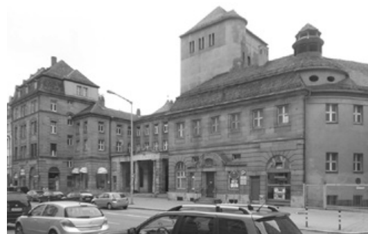
Abb. 653: Aktuelle Ansicht von der Straße mit dem reduziert wieder hergestellten Wasserturm (Foto: JR).
