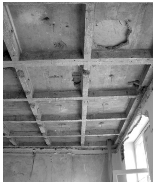
Abb. 398: Kassettendecke System Hennebique (Foto: JR, 2007).
