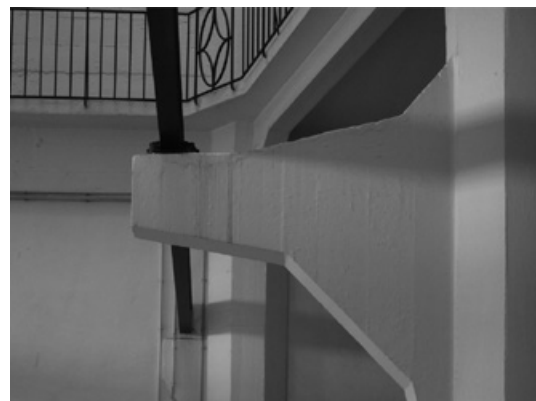
Abb. 633: Konsole für die Kranbahn im Erdgeschoss im Bereich des Luftschachts (Foto: JR).
