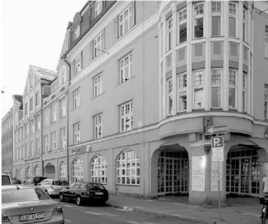
Abb. 508: Aktuelle Straßenansicht (Foto: JR).
