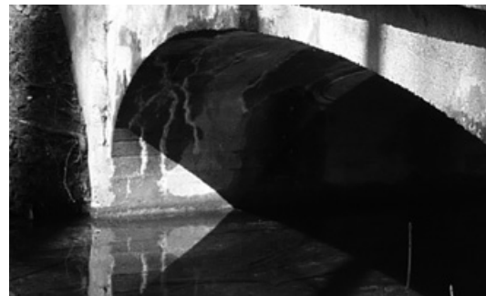
Abb. 774: Eine der Brücken mit sichtbaren Schalungsabdrücken (Foto: JR).
