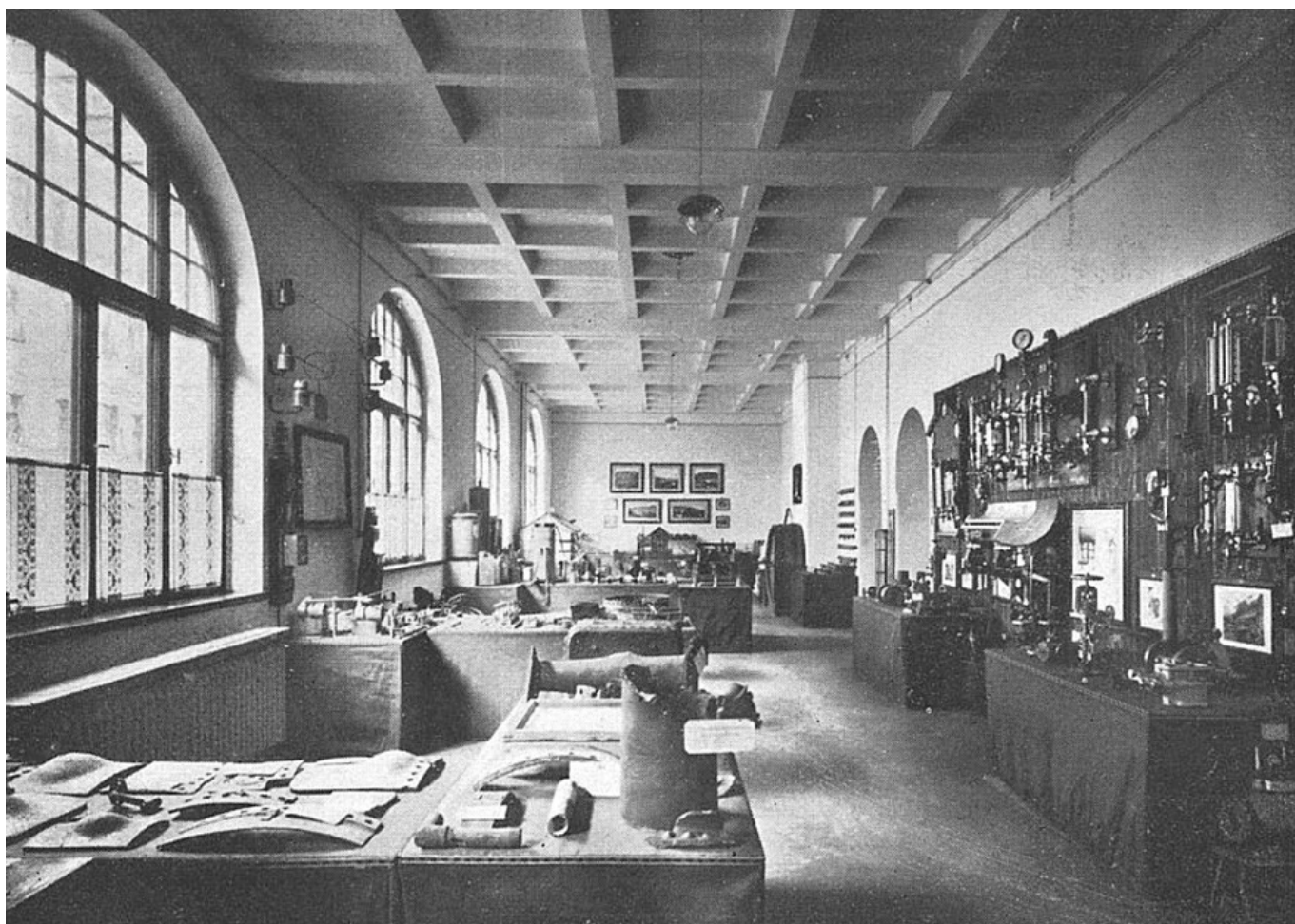
Abb. 443: Historisches Foto der Kassettendecken im Westflügel (BSA, Landbauamt München, Akt-Nr. 2881).
