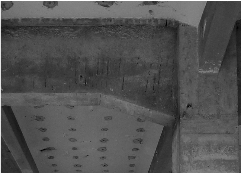
Abb. 302: Deutsches Museum: Ablesbare Bügelbewehrung in einem Biegebalken (Foto: JR).
