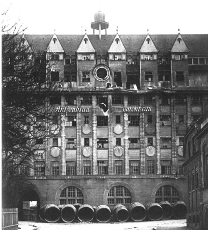
Abb. 610: Beschädigungen im Mai 1919 (Heckhorn 1989, S. 226).
