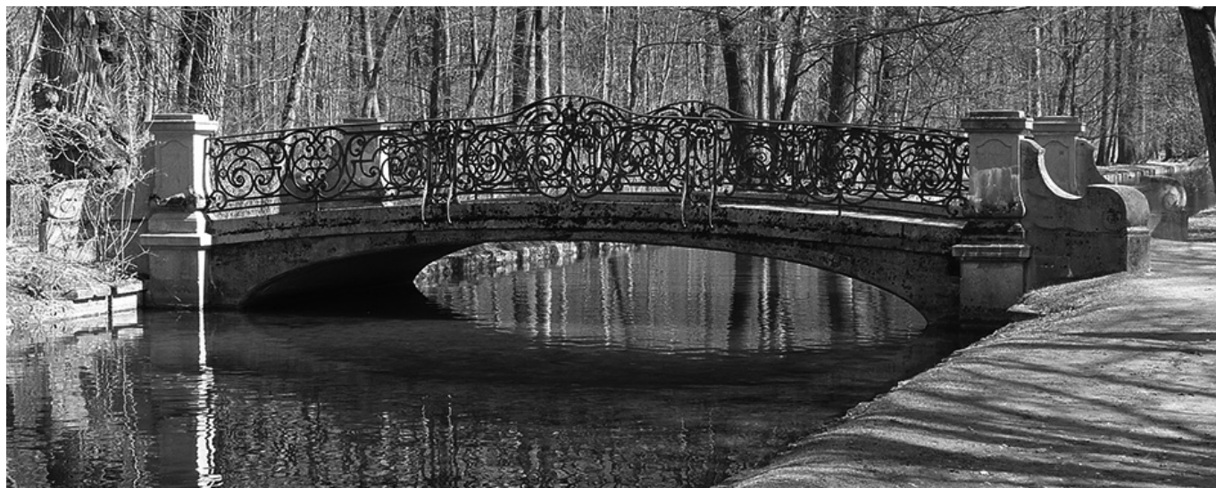
Abb. 776: Eine der Brücken mit sehr flachem Bogen und schmiedeeisernen Geländern (Foto: JR).
