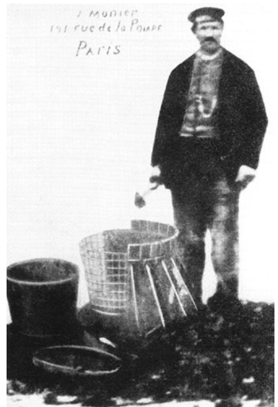
Abb. 56: Monier bei der Herstellung eines Pflanzkübels um 1863 (Stark et.al 1998, S. 85).
