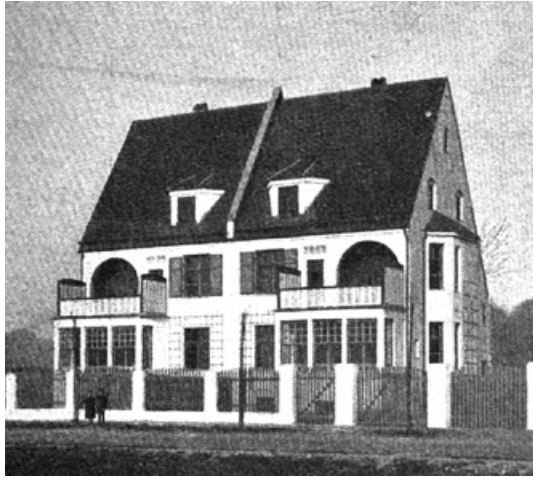
Abb. 383: Ansicht des Doppelhauses (SBZ 1903, S. 75).
