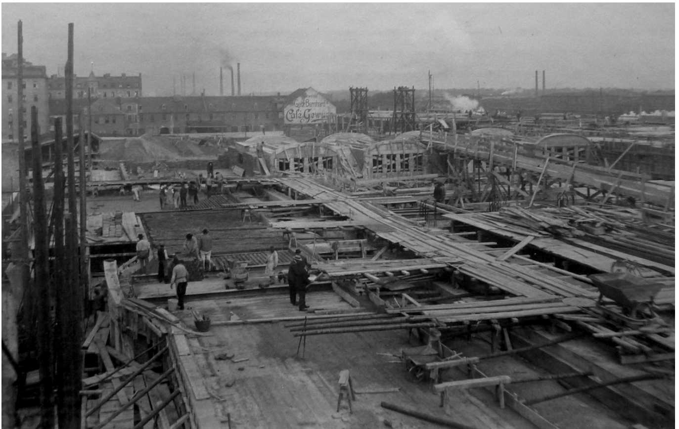
Abb. 781: Baustellenfoto von 1911 des Hauptzollamtes (Archiv Hauptzollamt).
