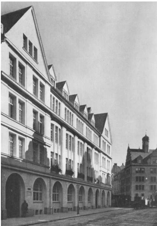
Abb. 592: Bebauung Liebherrstraße (DBZ 1910, S. 440).
