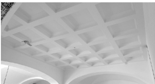
Abb. 681: Kassettendecken Treppenraum (Foto: JR).
