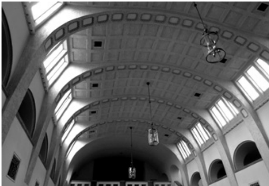
Abb. 282: Die Schalterhalle des Hauptzollamts mit kassetierter Decke zwischen Binderkonstruktionen (Foto: JR).
