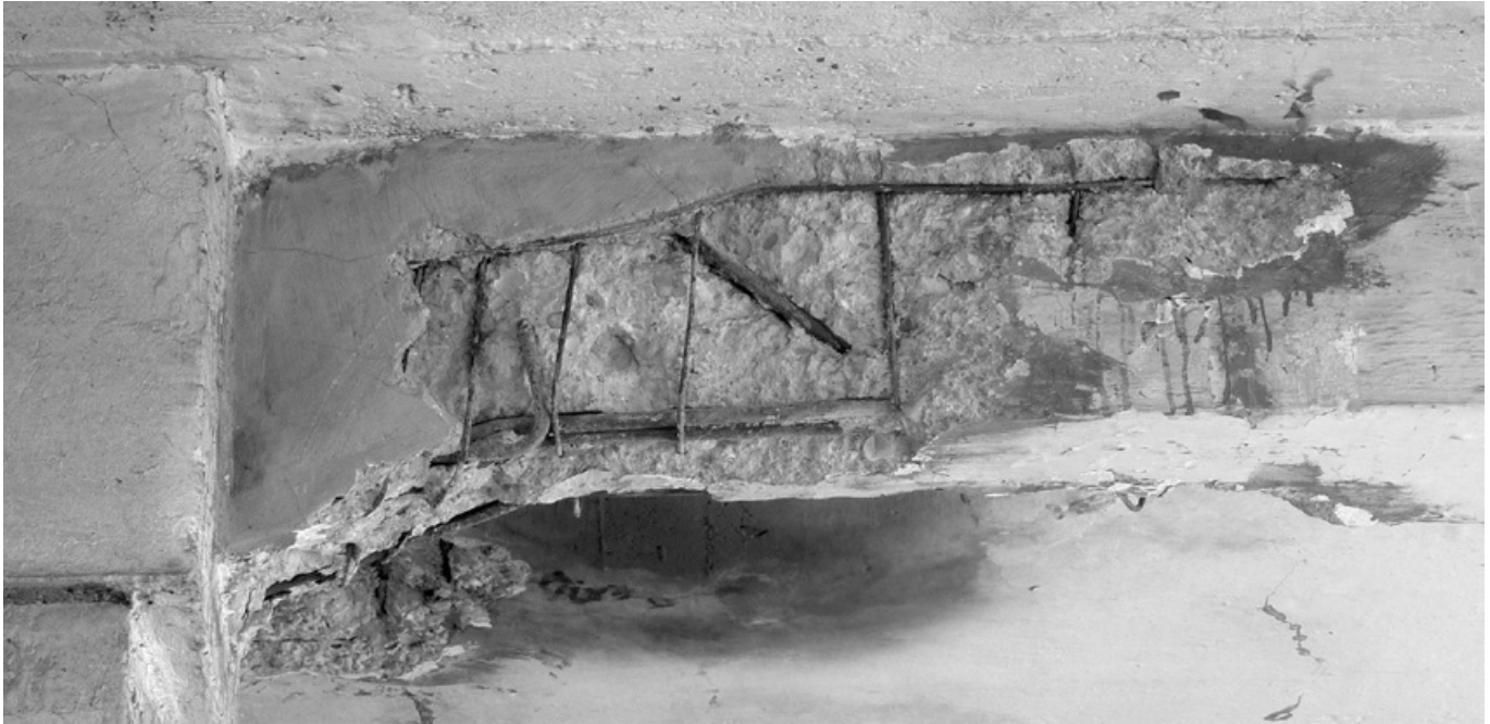
Abb. 115: Bewehrung eines Unterzugs im Anschluss an eine Stütze mit Voutenausbildung. Der Befund (Schadstelle im Reinigergebäude des ehemaligen Gaswerks in Augsburg, Baujahr 1914) belegt die Ausführung in Anlehnung an Mörschs Vorschläge (Vgl. Abb. 114) (Foto: JR).
