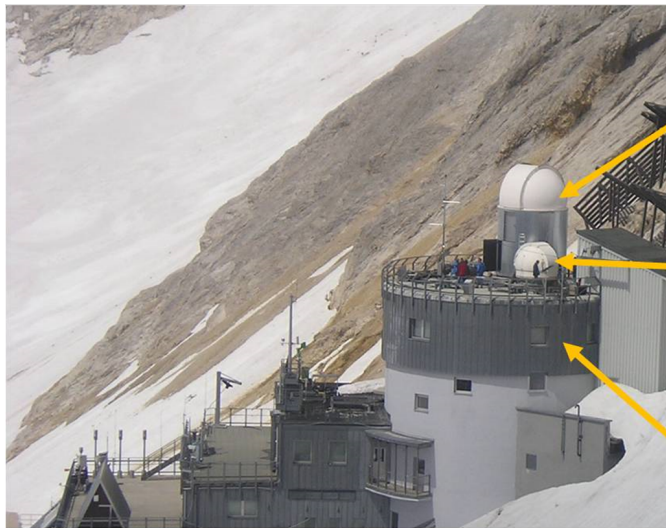
Abb. 17: Das Schneefernerhaus mit den Aufbauten für das Raman-Lidar und das DIAL auf der obersten Dachterrasse: Ansicht von Osten. Bei dem DIAL handelt es sich um das bereits bestehende System.
