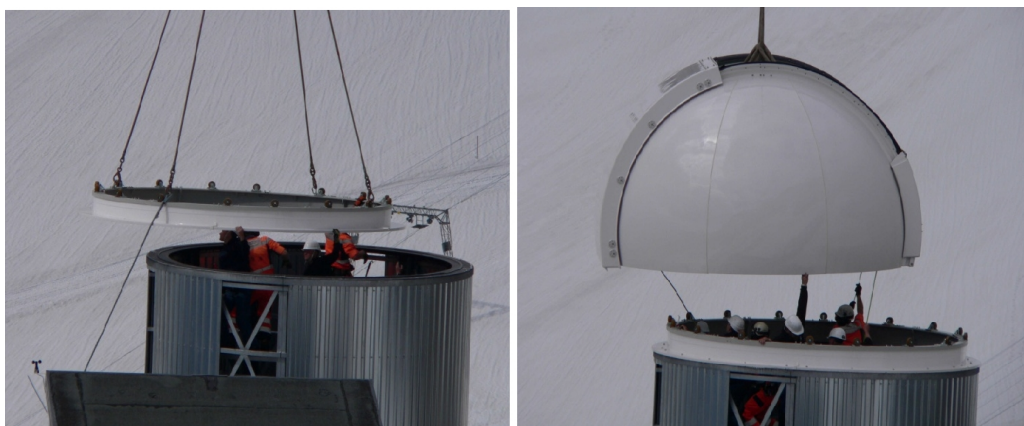
Abb. 34: Links: Aufsetzen des Adapterring auf den Turm. Anschließend wird die Kuppel aufgesetzt.
