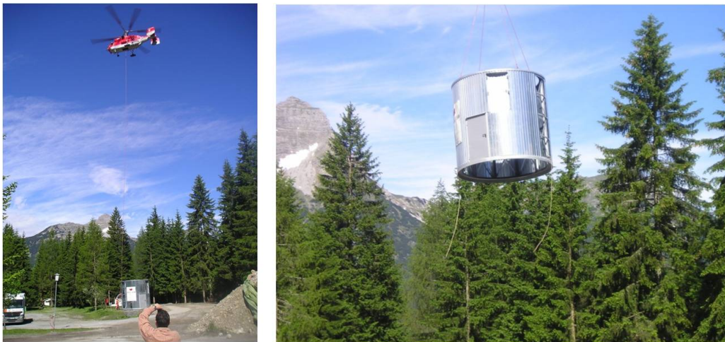
Abb. 32: Der Turm wird am Hubschrauber angehängt.
