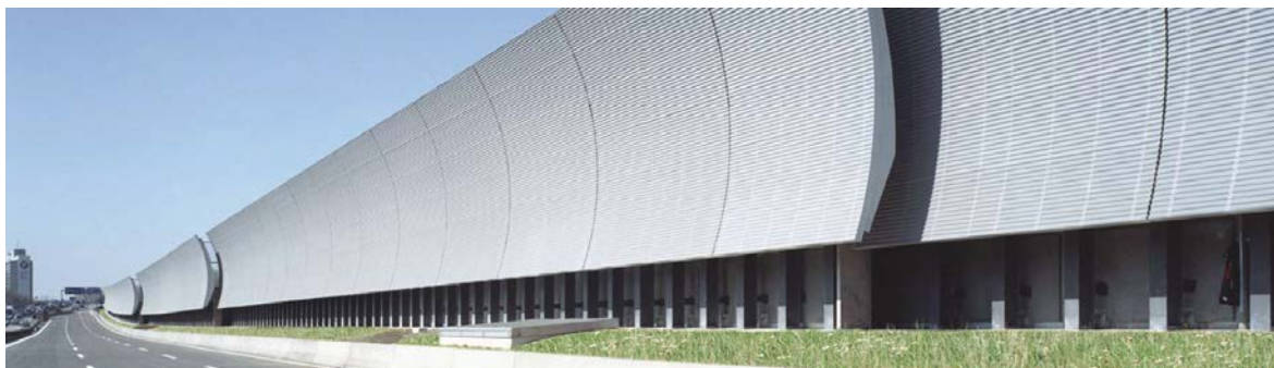
Abbildung 1.1: Lärmschutzwand München-Freimann (Ingenieurbüro Grassl, 2018)
