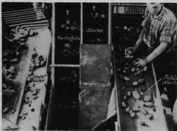
Bild 15: Trennergebnis der Ziegler-Maschine. Die Fehler werden durch Nachlesen ausgemerzt
