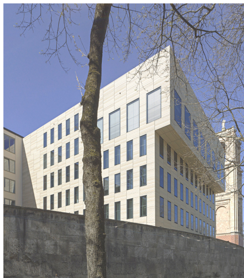
Abbildung 06-03: Neubau „Erweiterung Maximilianeum“ als Verwaltungsbau im Passivhaus-Standard; Architekten: Léon Wohlhage Wernik, Berlin [StBAM2 2018]
