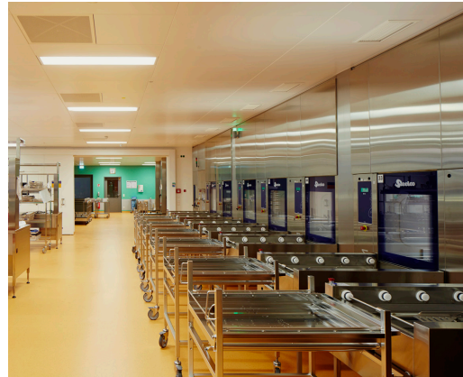
Abbildung 01-07: Packzone mit Reinigungs- und Desinfektionsgeräten der zentralen Sterilgutversorgung am Klinikum rechts der Isar [Arlt 2014]
