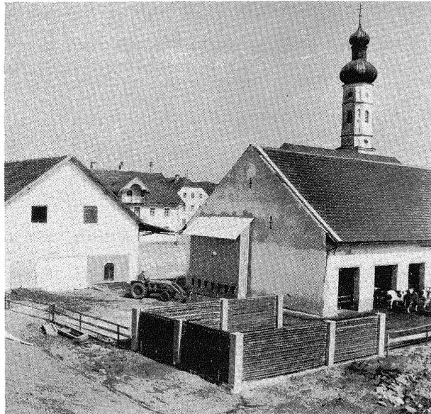
Abb. 1: Hofansicht nach dem Umbau: links im Bild der Liegeboxenstall mit großen Toren für Frontladerentmistung, rechts Scheune mit Fahrsilos und Heuvorratsraufe (an der Giebelwand), im Vordergrund Filterstangenmiststätte mit darunterliegender Jauchegrube.
