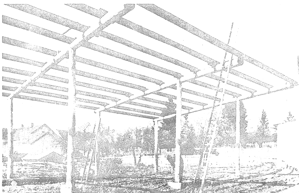
Tragkonstruktion einer Pultdachhalle aus 25 – 28 cm starken Stämmen, die auf Punktfundamenten befestigt sind. Es fehlen noch die Windverbände. So eine Halle kann als Maschinenschuppen, Jungviehlaufstall oder Strohbergeraum verwendet werden.
