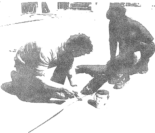
Abb. 4: Quellverschweißen von PVC-Planen
