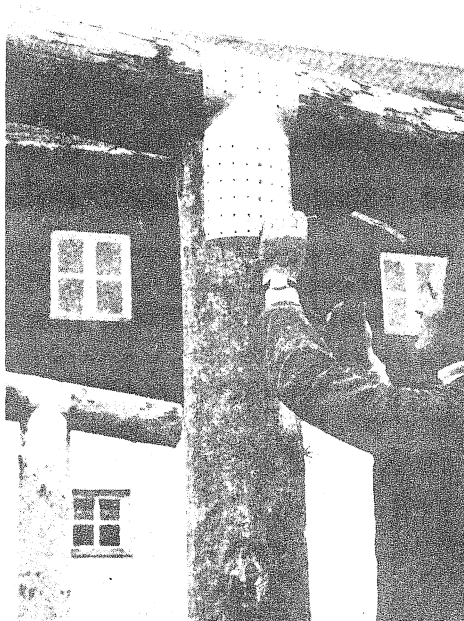
Hölzer stumpf stoßen (bei stärkerem Stirnholz etwas einsatteln), Verbinder beidseitig aufnageln (von innen nach außen): So einfach ist das!
