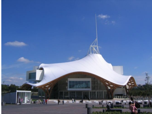
Abb. 72: Freiformfläche, Centre Pompidou in Metz
