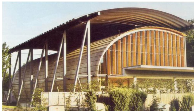
Abb. 113: Gekrümmte Brettsper Holzplatte der Aussegnungshalle Gräfelfing [Winter, et al., 2008]
