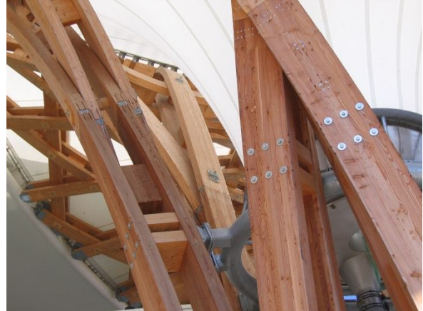
Abb. 73: Gekrümmte Brettschichtholzträger des Centre Pompidou in Metz
