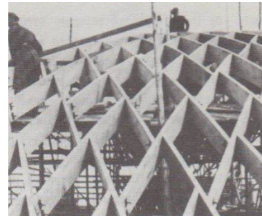
Abb. 48: Foto Zollinger-Lamellen-Bauweise [Ewald, 1985]
