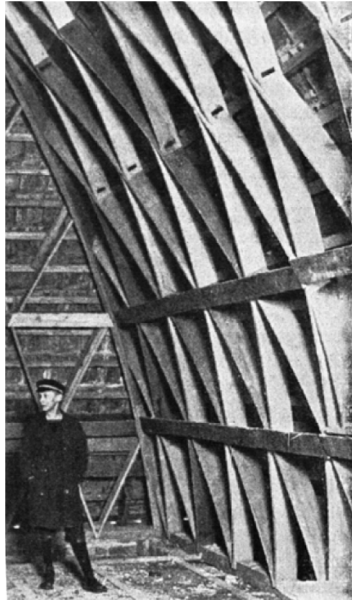
Abb. 43: Spitzbogendach in Zollbauweise [Kersten, 1926]
