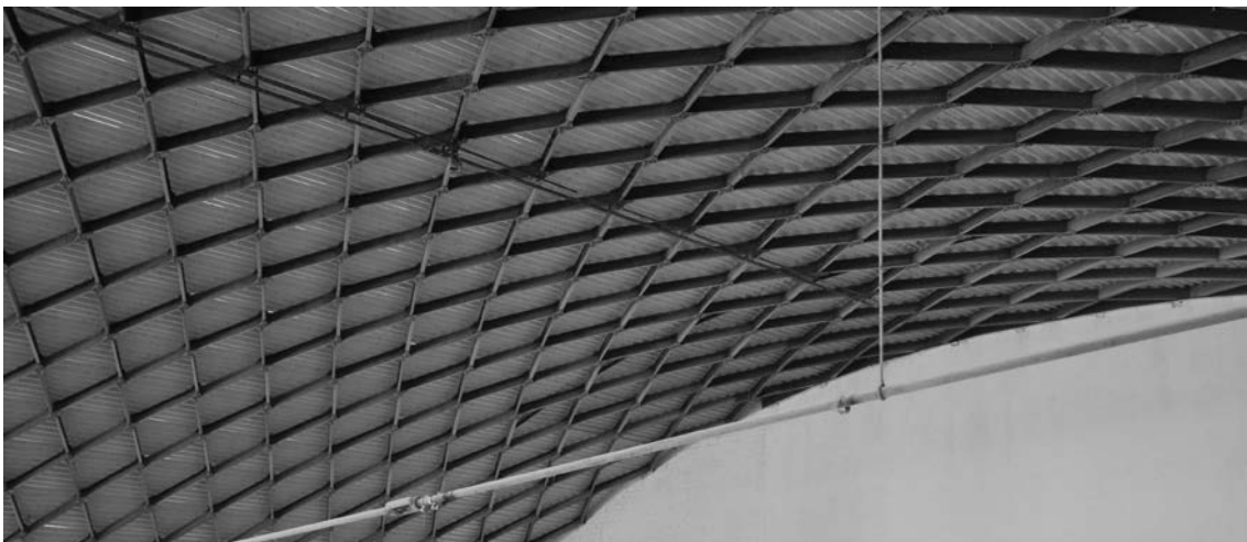
Abbildung 1.3: Bauweise Hünnebeck – Lagerhalle Neu-Offstein (Foto: JT, 2018).
