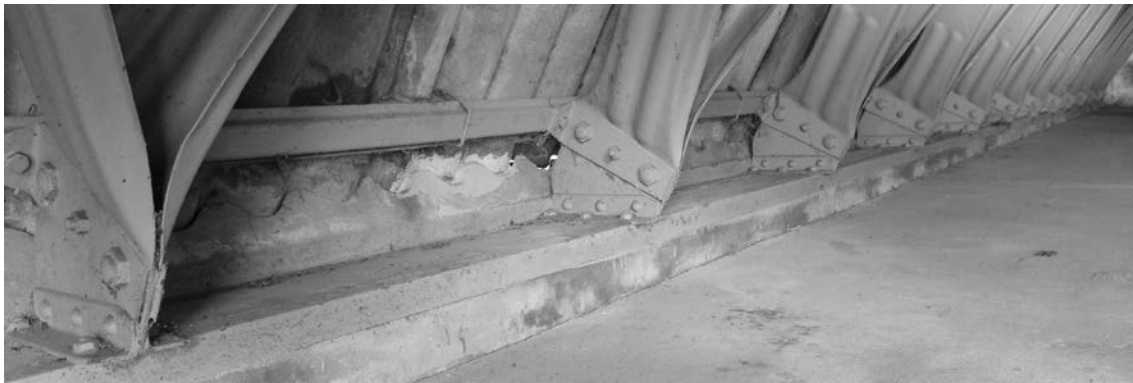
Abbildung 6.6: Standardausbildung eines bodengleichen Fußpunktes nach Junkers: Fliegerclub Hugo Junkers Dessau e.V. (Foto: JT, 2017); deutliches Beispiel für eine Einspannung.
