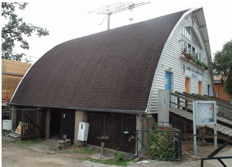
Außenansicht Halle (JT, 2018)
