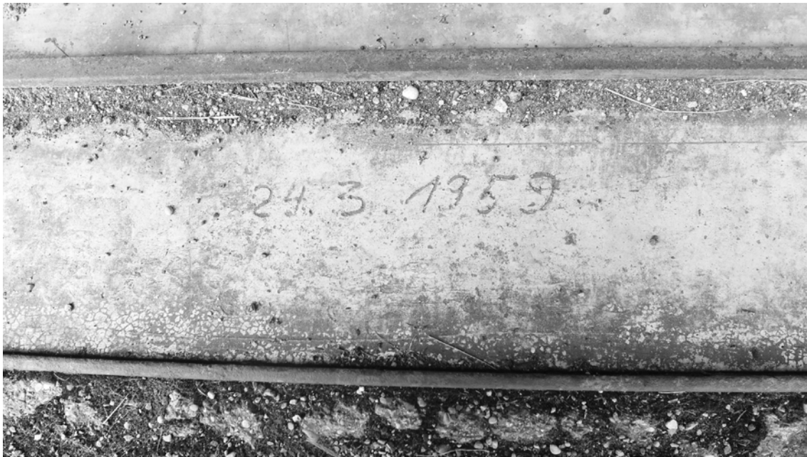
Abbildung 8.2: Halle Oberschleißheim: Die Toranlage wurde laut der Inschrift des Betonsockels im März 1959 erneuert (Foto: JT, 2015).
