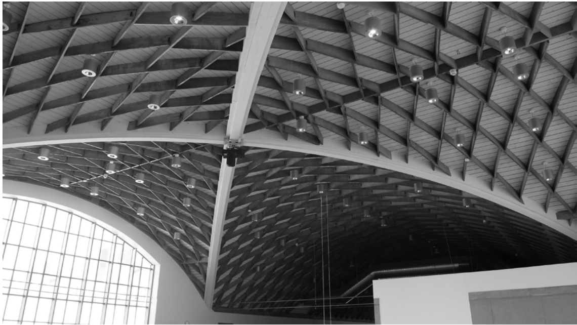
Abbildung 7.2: Marinaforum Regensburg: Revitalisierung und Umnutzung zu einem Tagungs- und Veranstaltungsbau. Einzig bekanntes Kreuzgewölbe der Bauweise (Foto: JT, 2018).
