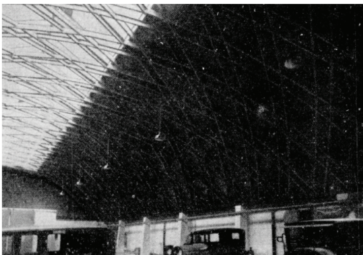
Innenansicht Untersicht Dach (Weiss 1930, S. 96)
