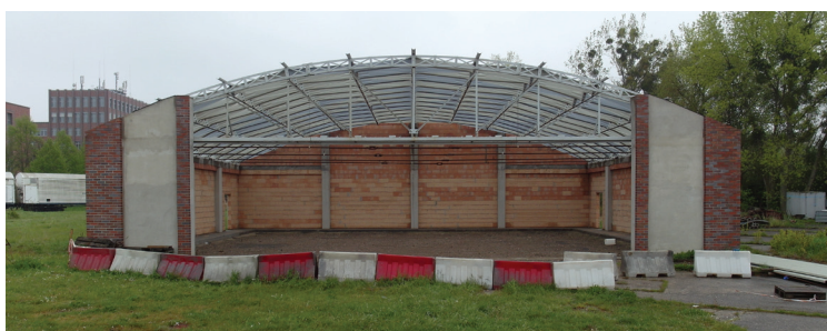
Außenansicht Halle (JT, 2017)
