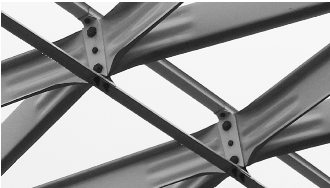
Abbildung 6.68: Standardausbildung eines Knotenpunktes nach Junkers: Wiederaufbau vor dem Technikmuseum Hugo Junkers Dessau e. V. (Foto: JT, 2017). Die vier Lamellen überlappen sich im Knotenpunkt und sind mit zwei seitlichen Backenblechen verschraubt. Auch die Pfetten (Ober- und Unterpfette) überlappen und sind jeweils doppelt verschraubt.
