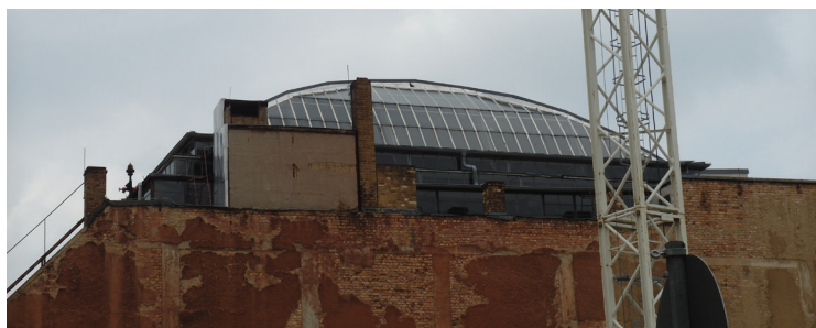
Außenansicht Halle (JT, 2017)
