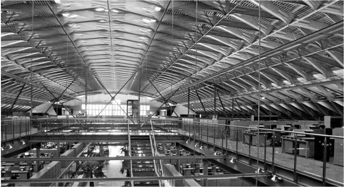
Abbildung 7.6: Skyways-House Liverpool: Innenraum nach der Umnutzung und Instandsetzung (Foto: Anthony Clarke, 2006).
