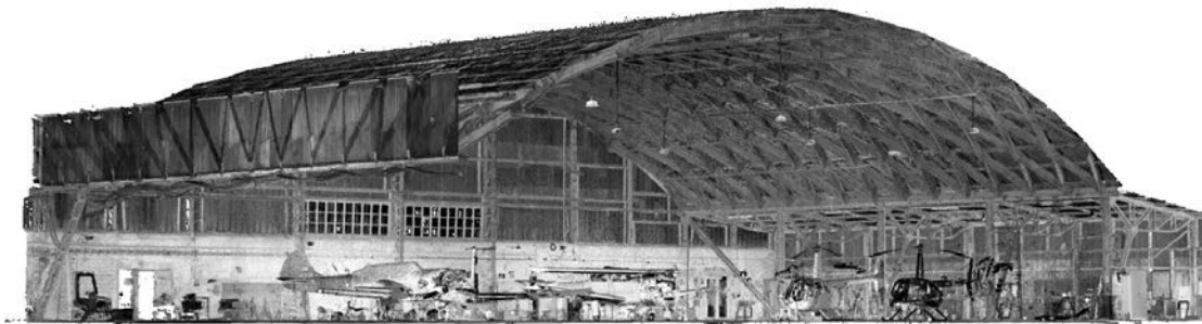
Abbildung 8.7: Hallen Oberschleißheim: Ausschnitt aus der 3D-Punktwolke. Gut zu sehen ist in dieser Einstellung der Fachwerkriegel des Zwischenbauwerks in der linken Bildhälfte.
