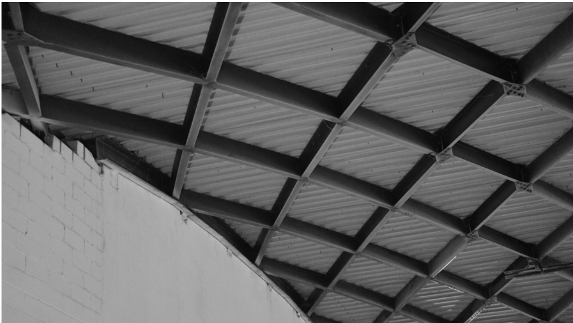
Abbildung 3.11: Halle 1, Neu-Offstein: Nachträglich eingestellte Brandwand. Knoten wurden gelöst und teilweise mit neuen Lamellenprofilen verschweißt (Foto: Kilian Wolf, 2018).
