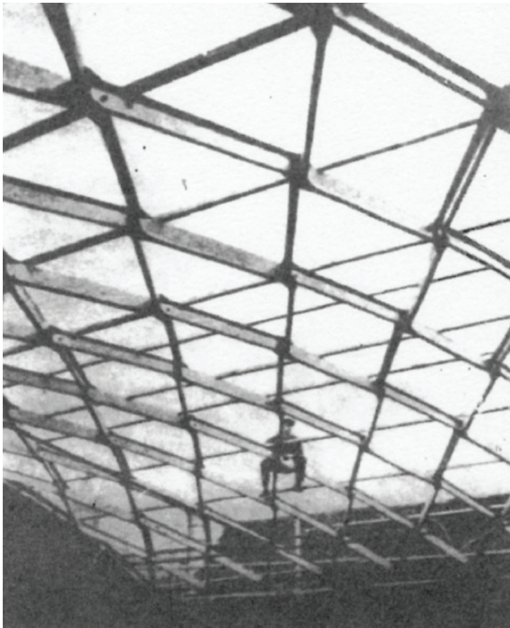
Ausführung Lagerhalle (Deutsche Stahl-Lamellengesellschaft mbH 1932, H.8 S.4)
