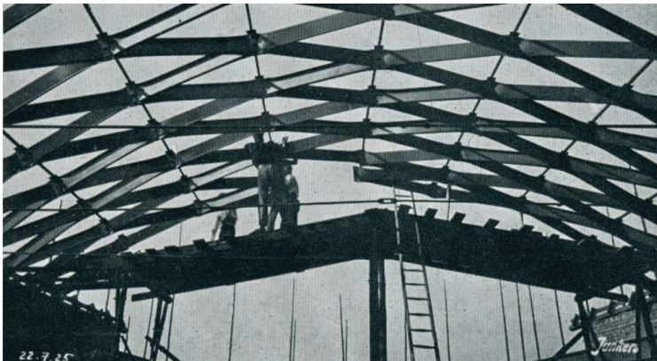
Innenansicht während des Baus (DM, Juna 1926118)
