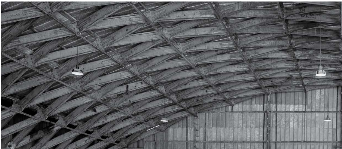
Abbildung 1.2: Bauweise Junkers – Hangar Oberschleißheim (Foto: JT, 2018).
