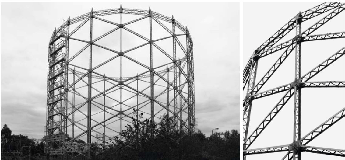
Abbildung 2.6: Trianguliertes Verbandsgerüst am Gasbehälter in Hornsey von 1892
