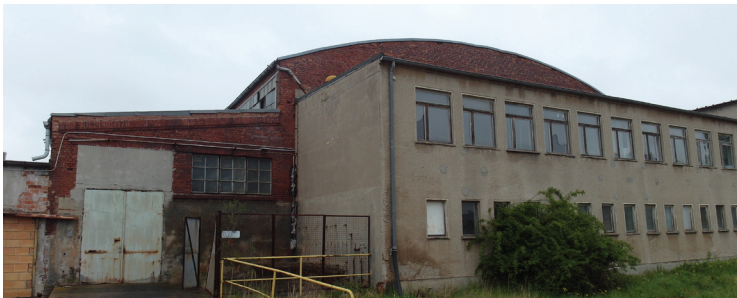
Außenansicht Halle (JT, 2017)
