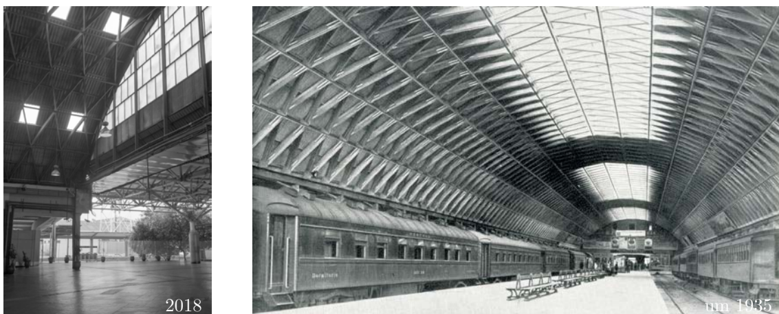
Abbildung 3.7: Rückbau des Daches am Bahnhof Brás, Sao Paulo. Links: Durchgangshalle und Übergang zur neuen Bahnsteighalle (Foto: Mirko Schütz, 2018). Rechts: Ehemalige Bahnsteighalle (Archiv Bernd Junkers, um 1935).
