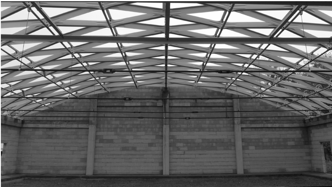
Abbildung 3.5: Modifizierter Wiederaufbau vor dem Hugo Junkers Museum in Dessau aus den intakten Resten des Hangars in Köthen (Foto: JT, 2018).
