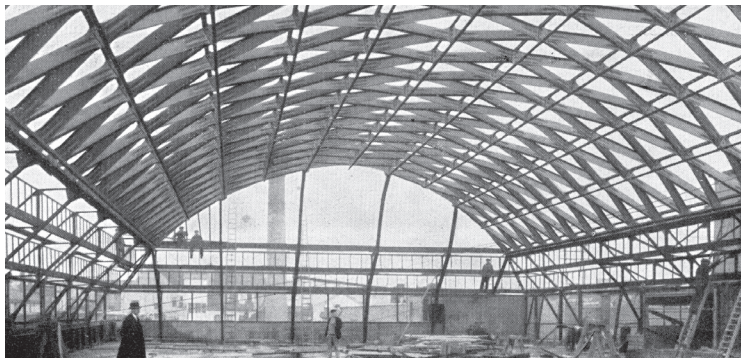
Innenansicht während des Baus (ABJ, 0450614a)
