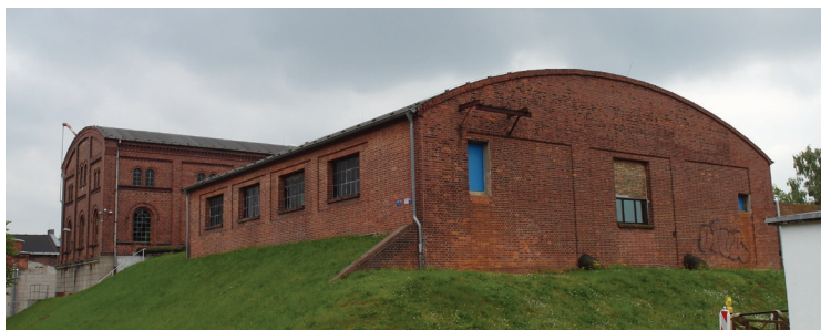
Außenansicht Halle (JT, 2017)
