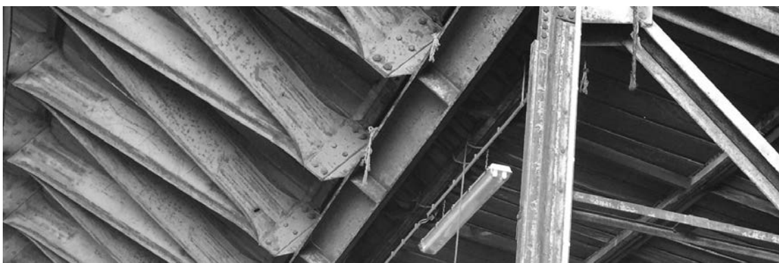
Abbildung 6.7: Exemplarisches Anschlussdetail eines aufgeständerten Lamellendaches nach Junkers: Luftsportverein Lilienthal e.V., Oberschleißheim (Foto: JT, 2016); Beispiel für eine eher gelenkige Lagerung.
