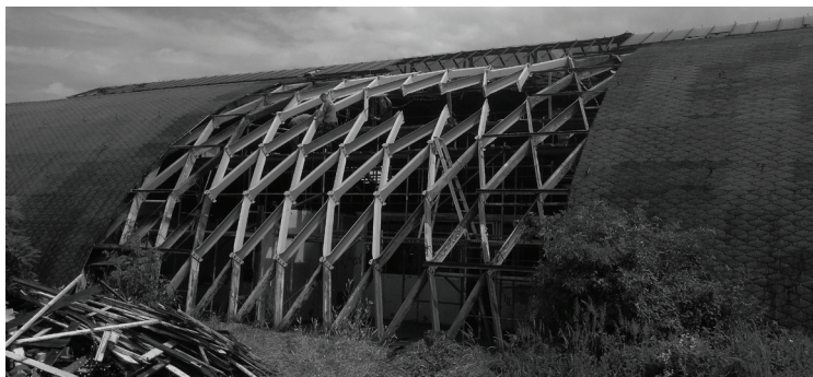
Offenes Dach während der Sanierung (Schulze 2012)
