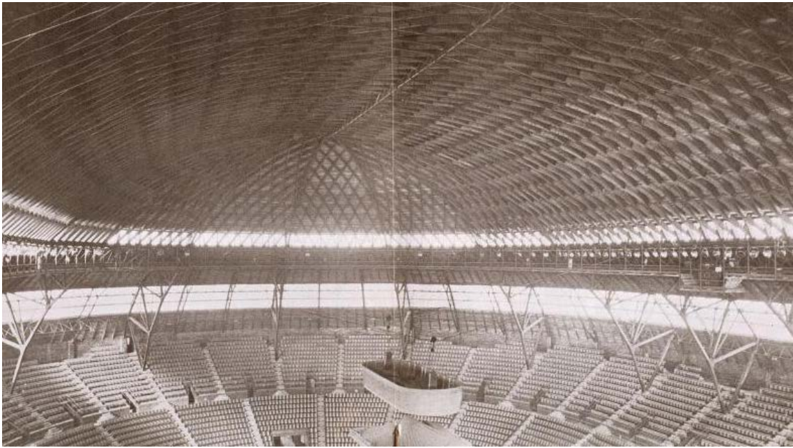
Abbildung 2.11: Innenraum St. Louis Arena (1930–1999). Die Konstruktion ist mit 50 m wohl das weitgespannteste Zöllingerdach. Jahr der Aufnahme unbekannt. Aus: (Duffy 2014).
