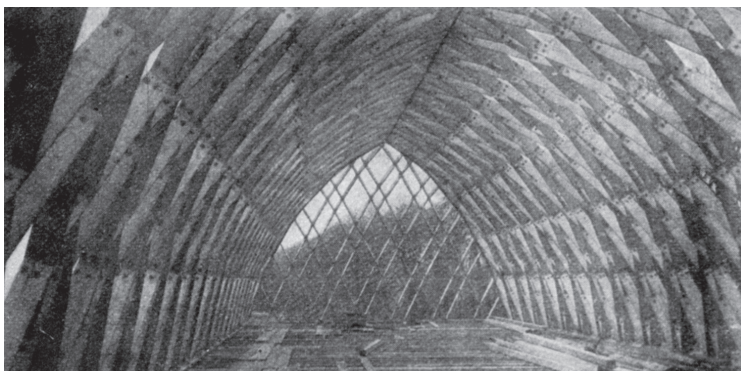
Innenansicht während der Ausführung (Gesteschi 1928, S. 342)
