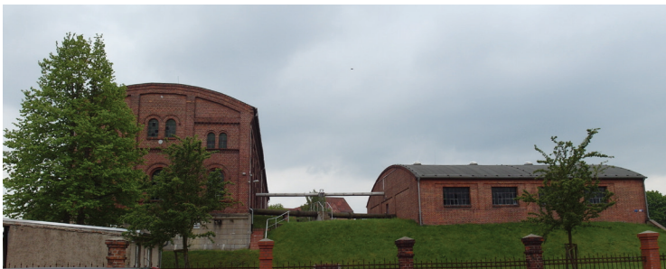
Außenansicht Halle (JT, 2017)
