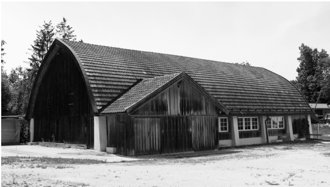
Abbildung 7.1: Orgelmuseum Valley: Das translozierte, neu eingedeckte Dach lagert auf neuen Stahlbetonpfeilern (Foto: JT, 2018).
