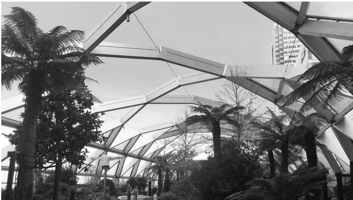
Abbildung 2.30: London/UK. Verkleidete Brettschichtholzkonstruktion über dem Canary Wharf Crossrail Place , mit einer Spannweite von ca. 33 m und bereichsweise ausgesparten Lamellen.
