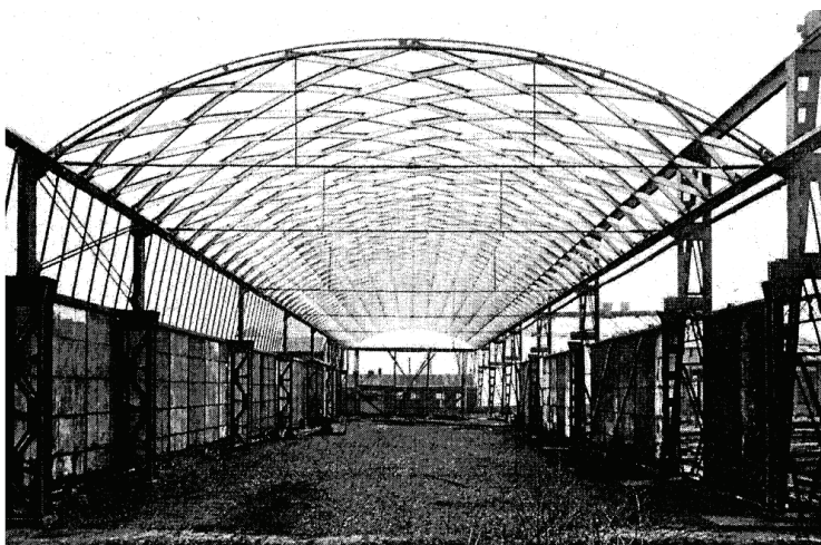
Rohbau (Hünnebeck 1930b, S.22)
