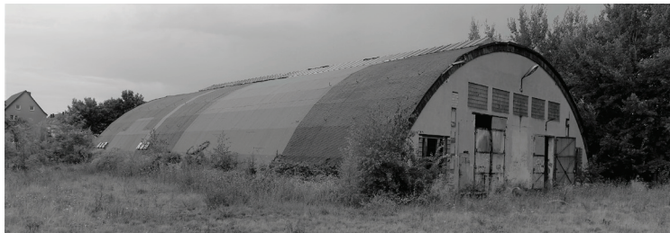
Ansicht der Halle von Südwesten, (JT, 2018)
