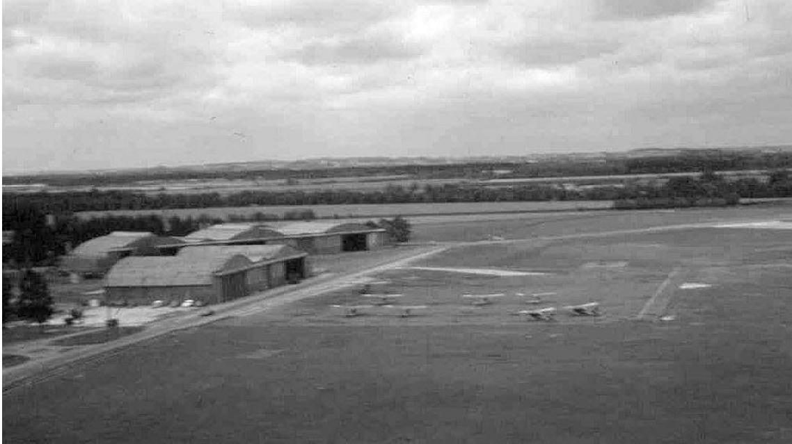
Abbildung 8.1: Hallen Oberschleißheim: Im linken Bereich ist das fehlende dritte Hallenschiff der vorderen Halle gut zu erkennen. (Foto: Unbekannt, 1964).
