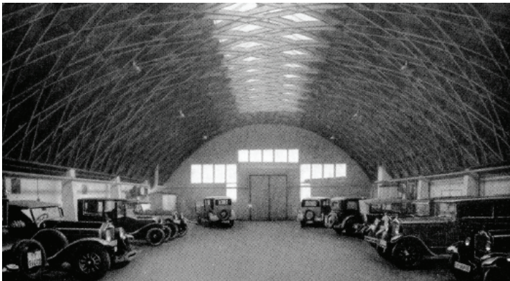
Innenansicht (Stahl Überall 1930, S. 20).
