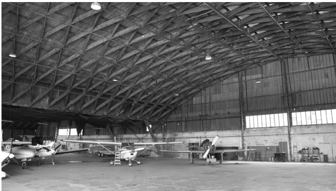
Abbildung 8.5: Halle Oberschleißheim: Innenraum Nordwest (Foto: Benedikt Philipp, 2015).
