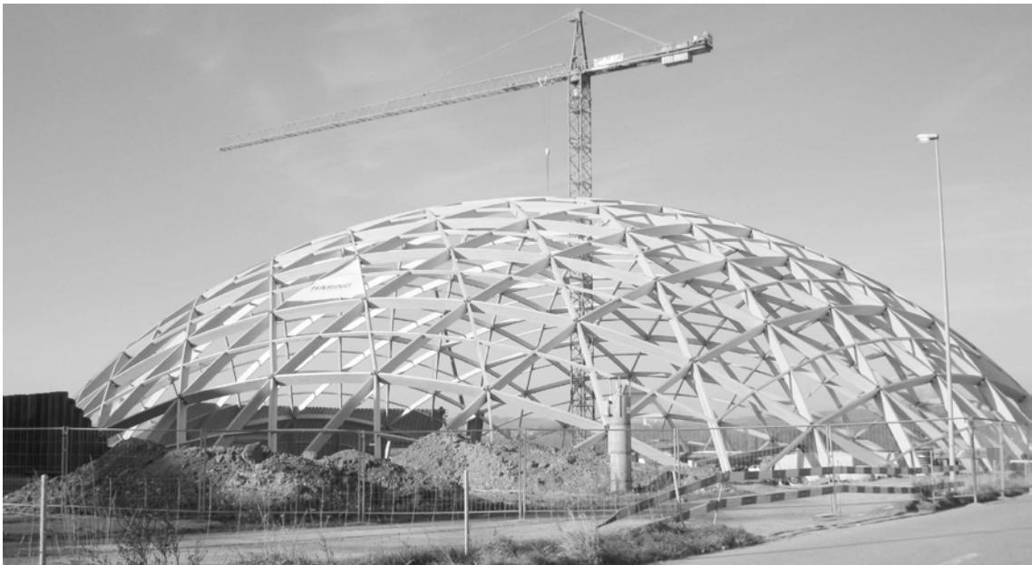
Abbildung 2.31: Rheinfelden/Schweiz. Triangulierte Lamellenkuppel Saldome 2 mit einer Spannweite von 120 m während der Errichtung. Aus: (Hamm 2013).
