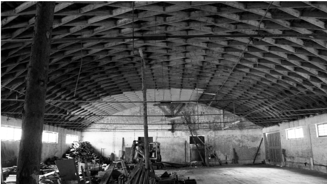
Abbildung 7.8: Sägewerk Fritzer, Bad Reichenhall: Punktuelle Stützen etwa im Scheitel der Tonne sowie großflächige Reparatur im hinteren Dachbereich (Foto: Björn Swedjemark, 2018).
