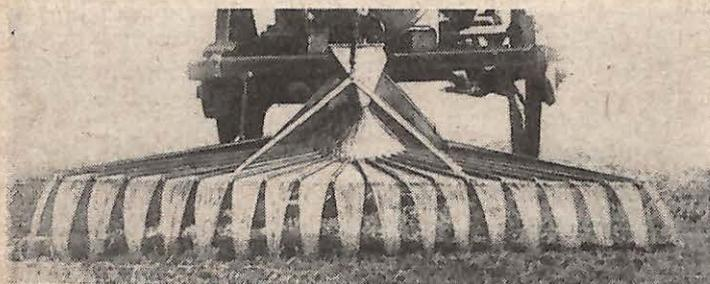
Abb. 2: Vorrichtung zur breiten Verteilung von Jauche.
