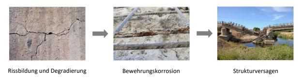
Abbildung 1-1: Degradationsprozess von Betontragwerken.
