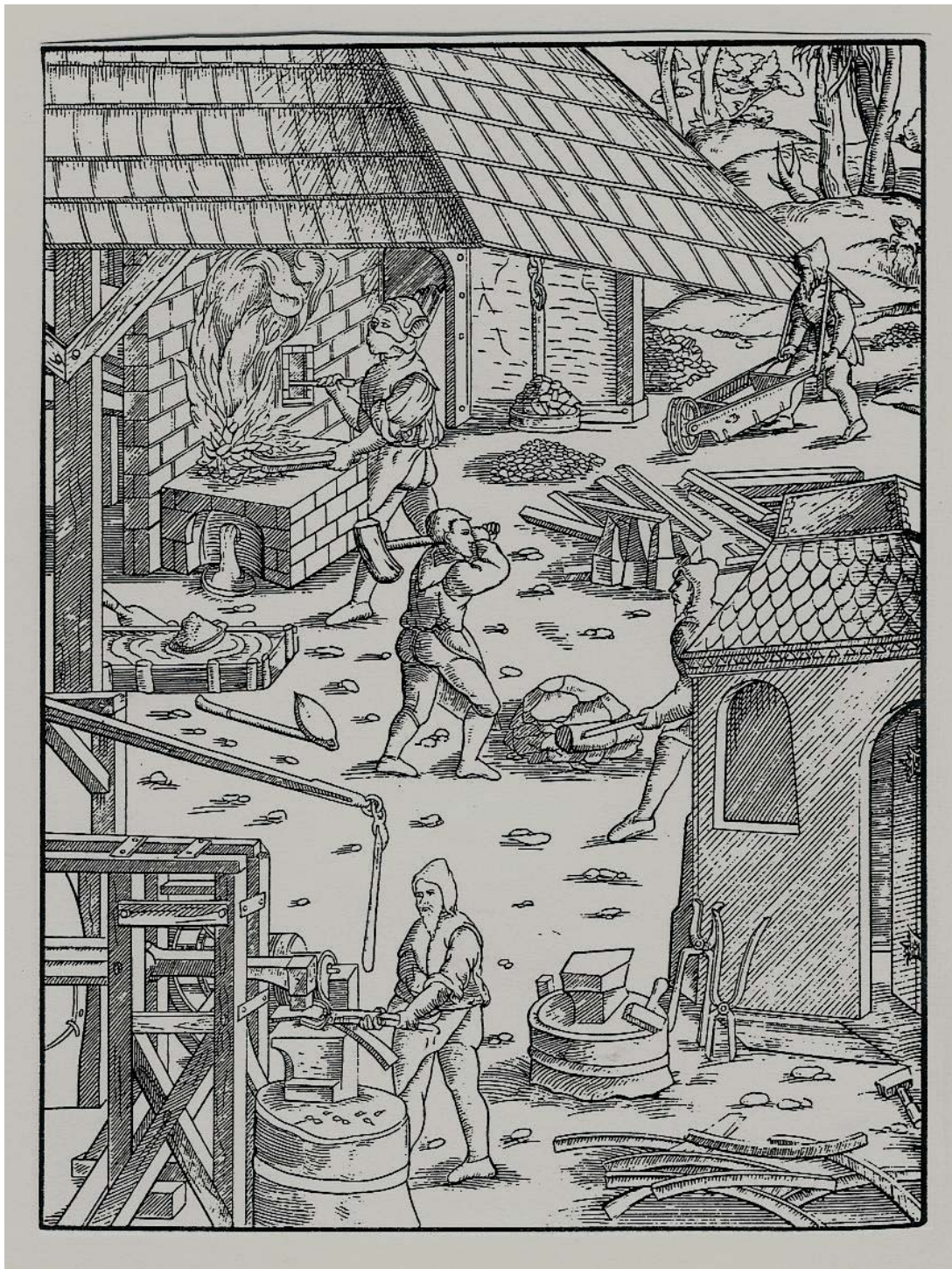
Abb. 13 GEORG AGRICOLA: Vom Bergwerk , Basel 1557 mit Holzschnitten von RUDOLF MANUEL DEUTSCH. Dargestellt sind u. a. Schmelzofen, Arbeiter mit Mundschutz.
