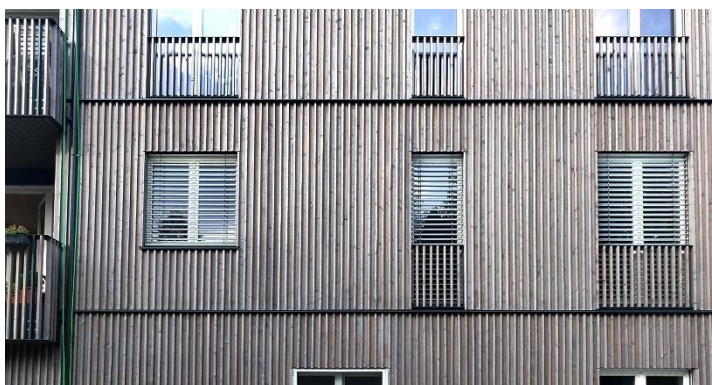
Abb. 2: Fassade als vertikale Deckleistenschalung
