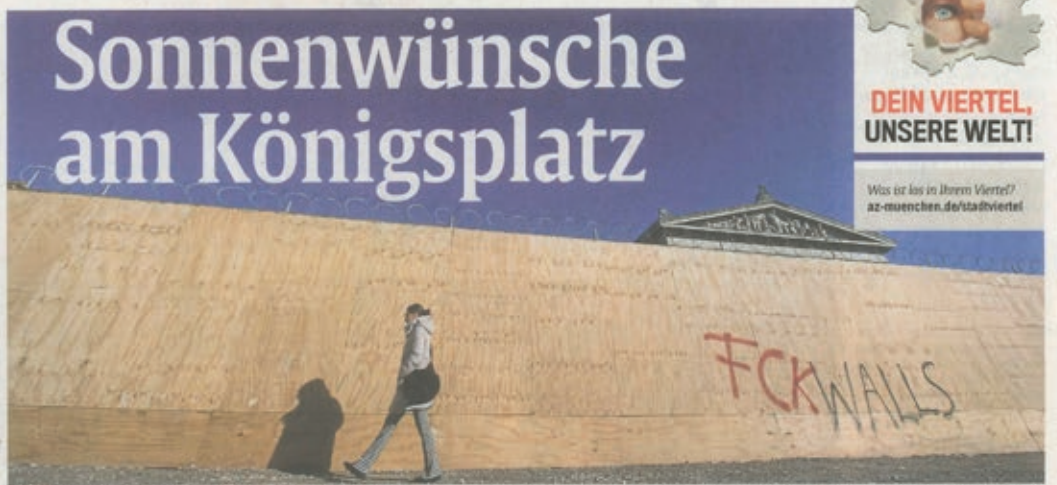
Und weg sind die Stufen vor der Glyptothek, auf denen man sich so schön sonnen kann. Davor steht eine Holzwand, die die Baustelle bis 2020 abschirmt. Foto: dpa/Zeichnungen: M. Schlüter, N. Förster
