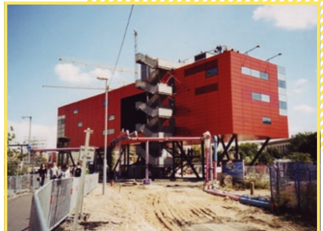
Info-Box an der Großbaustelle Potsdamer Platz
