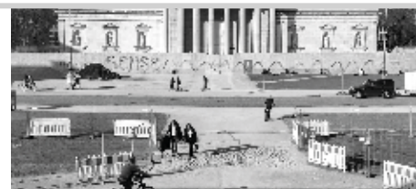
Baustelle mit Zaun
