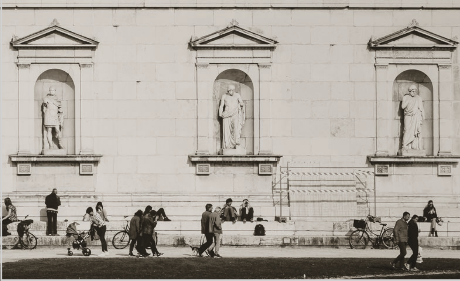
[Sitzstufensockel der Glyptothek vor der Baustellensituation.]
