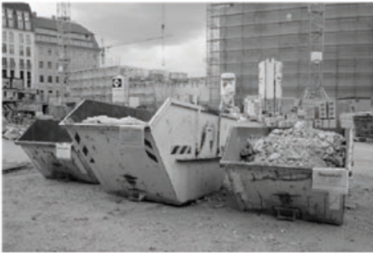
Bild 2.116: Beispiel für eine getrennte Abfallsammlung auf einer Baustelle mit Beschriftung der Container 199
