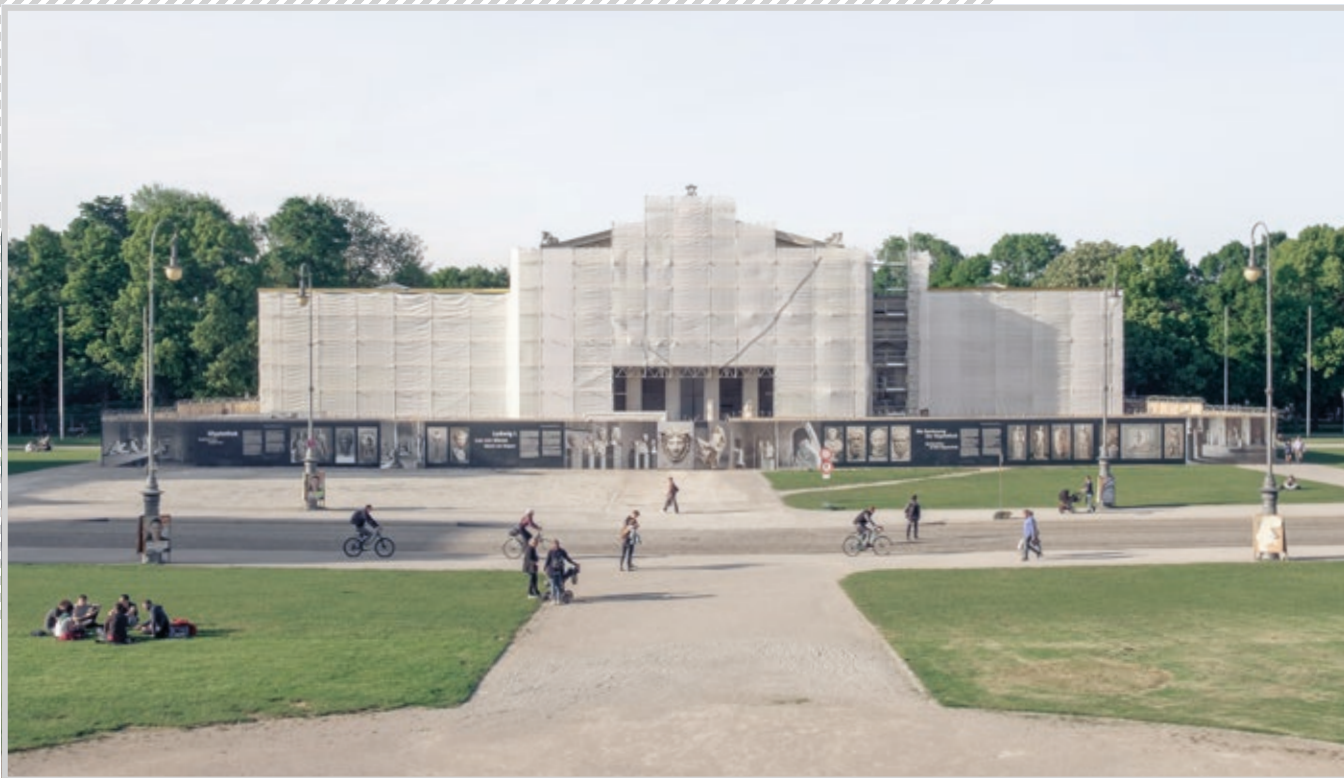
[Allmählich stabilisiert sich die Baustelle am Königsplatz mit Bauzaun-Plakaten und Gerüstschutz.]
