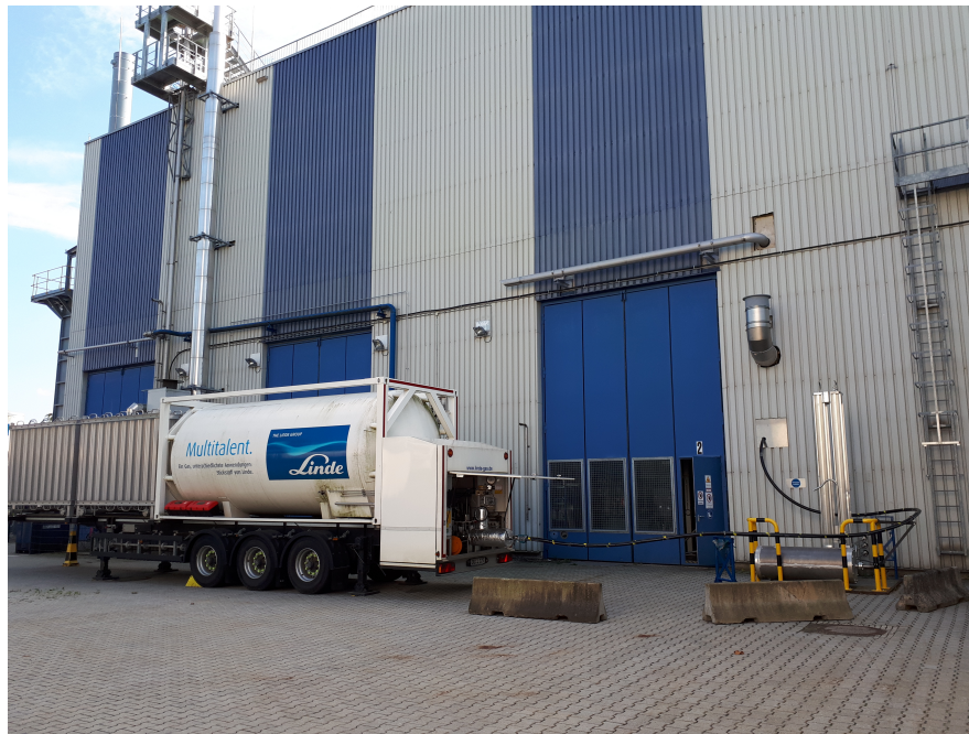
Abbildung 4.5: Anschluss des mobilen LIN-Tanks
