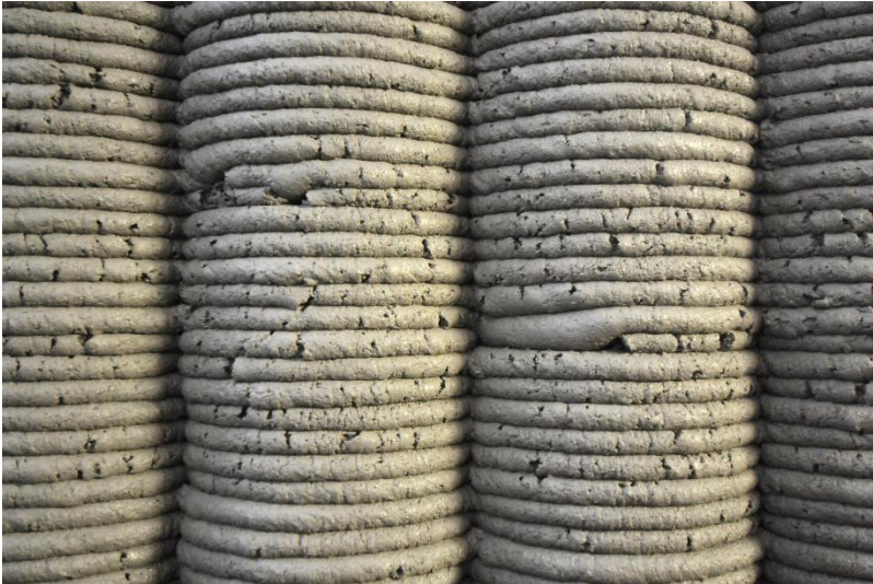
Abbildung 32: Ausgleich von Fehlstellen in Raupen durch nachfolgende Schichten (Foto K. Henke)
