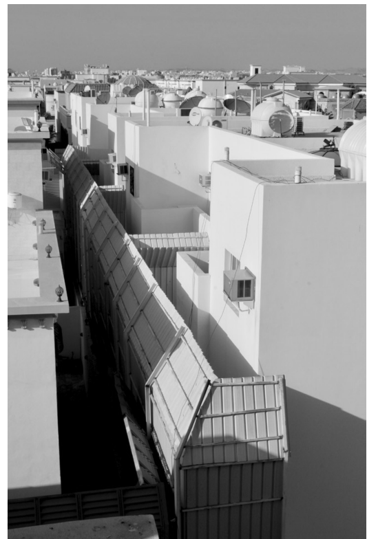
Abbildung 2 Wohngebäude mit einem Sichtschutz aus Eisenblechen in Dschidda, nach (Maneval, 2019)
