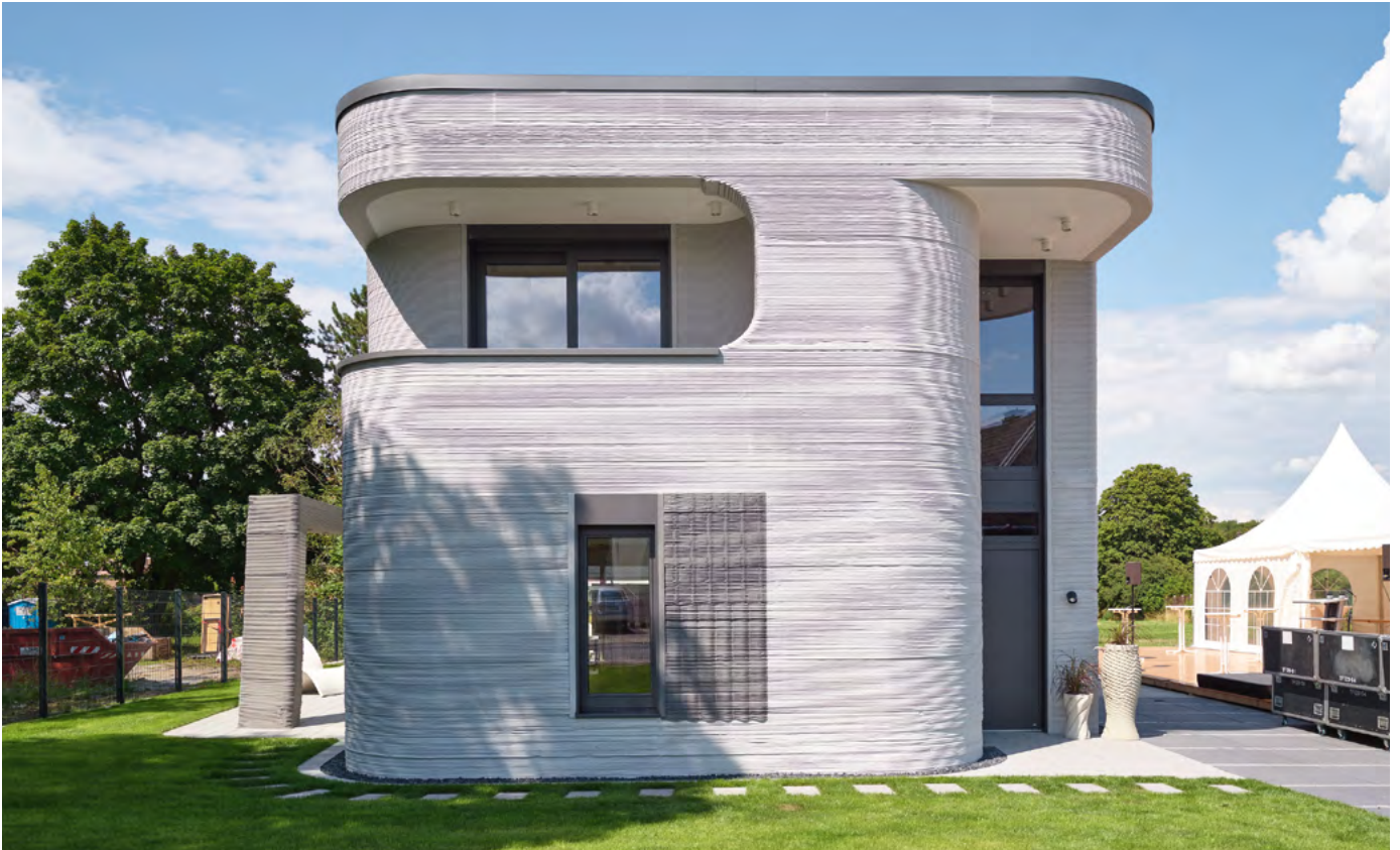
Deutschlands erstes 3D-gedrucktes Wohnhaus (Design: Mense-Korte ingenieure+architekten)
