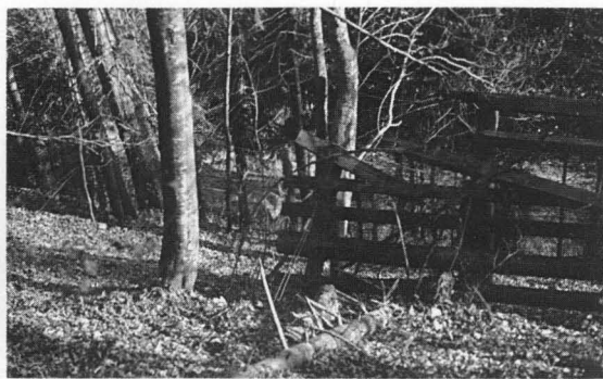
Bild 10 Lawinenbrücke durch Steinschlag zerstört. Die Schäden nach einer Lawinenkatastrophe auf den Fremdenverkehr können größer sein als Kosten für Verbauungen. Eigene Aufnahme
