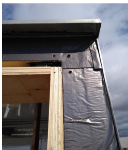
Abbildung 124 Bitumenabdichtung der Kubusflanken
