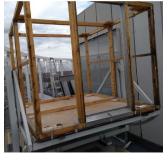
Abbildung 113 Zustand der alten Konstruktion - Rahmen
