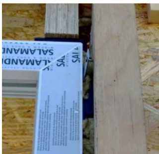
Abbildung 120 Verklotzen des neuen Fensters in der Konstruktion
