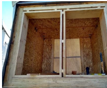
Abbildung 117 Testweises Verklotzen zweier Rahmen
