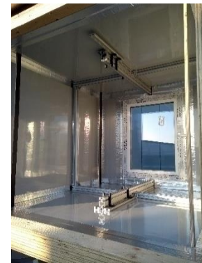
Abbildung 102 Einbau der Innendämmung und der Aluminiumprofile
