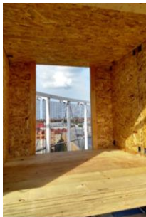
Abbildung 116 fertig beplankter Innenraum
