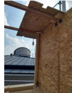
Abbildung 115 Montage neuer OSB-Beplankung
