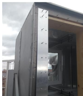
Abbildung 125 Verblechung zum Witterungsschutz
