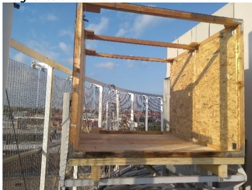
Abbildung 100 Baukonstruktive Ertüchtigung des ursprünglichen Kubus durch einen kompletten Ab- und Wiederaufbau der Tragkonstruktion
