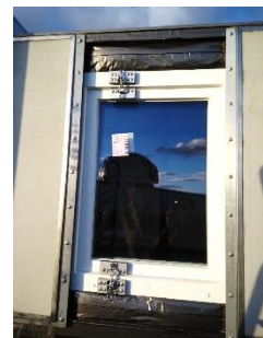
Abbildung 123 Fenster fertig abgedichtet
