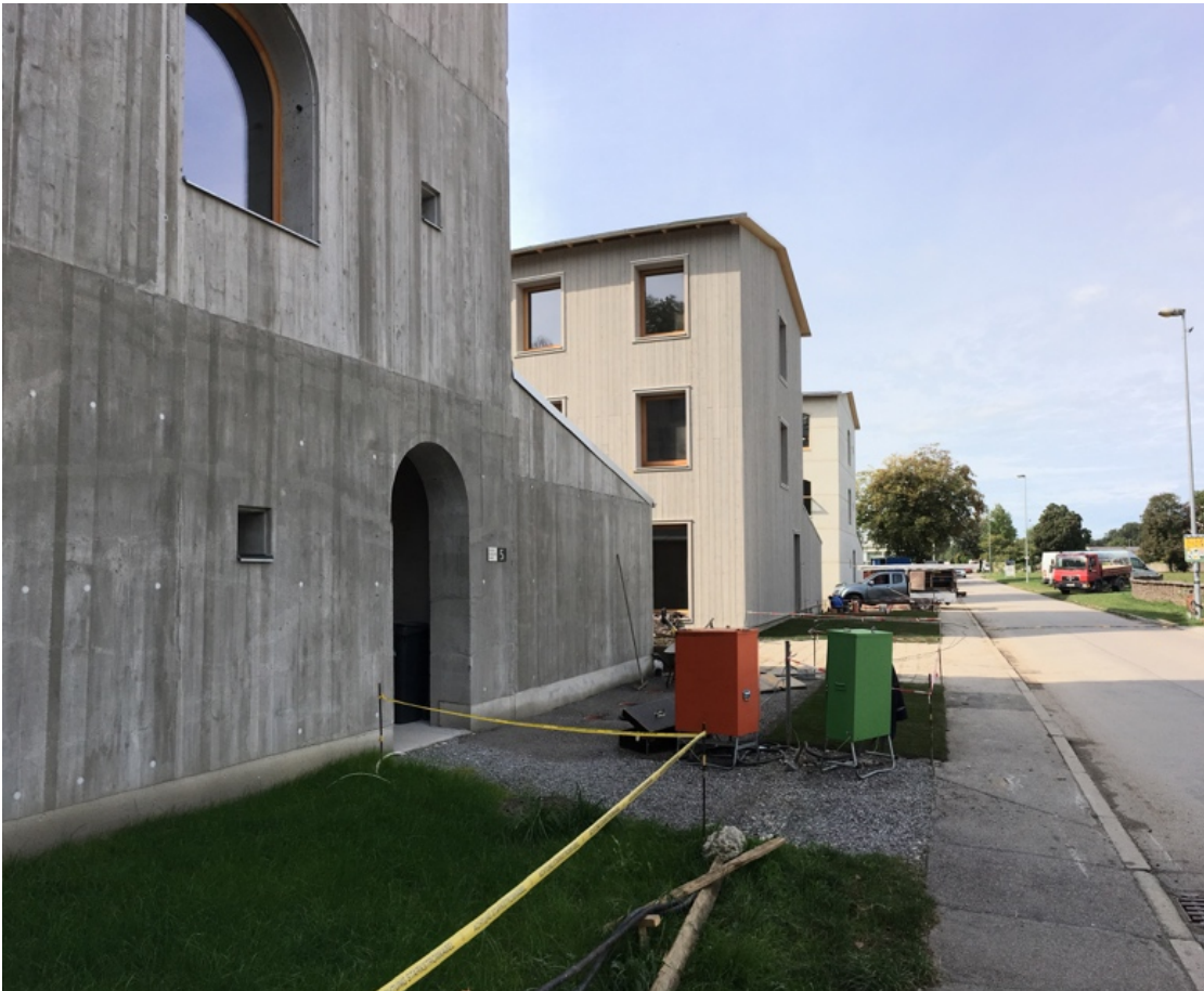
Bild 4, Straßenansicht der drei Forschungshäuser kurz vor Fertigstellung, Quelle: Tilmann Jarmer
