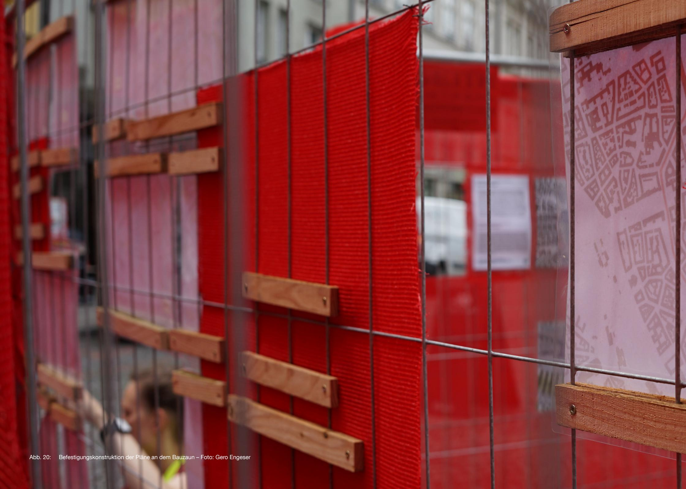
Abb. 20: Befestigungskonstruktion der Pläne an dem Bauzaun – Foto: Gero Engeser
