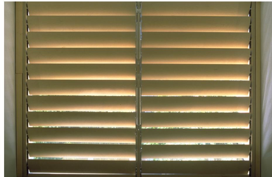
Fig. 33: Holz-Lamelle geneigt, Innenansicht
