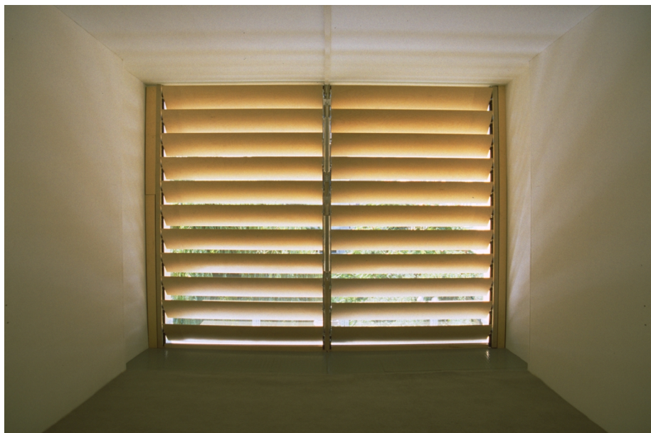
Fig. 36: Holz-Lamellen stark geneigt, Innenansicht
