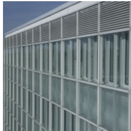
Fig. 12: Schachtfassade Telekom Verwaltungsgebäude, Köln, 1993 Arch.: Planungsgruppe der De Te Immobilien
