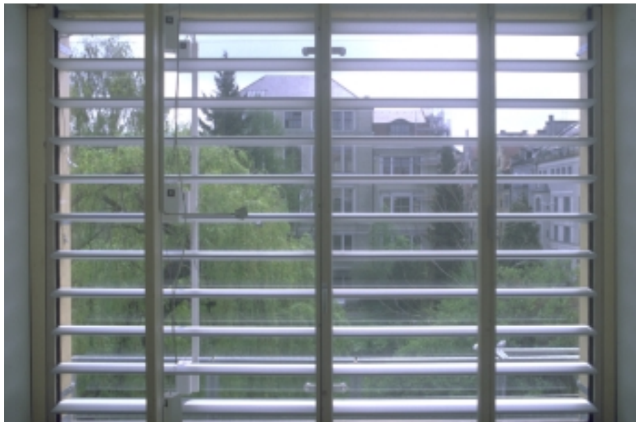
Fig. 20: Alu-Lamelle horizontal, Innenansicht
