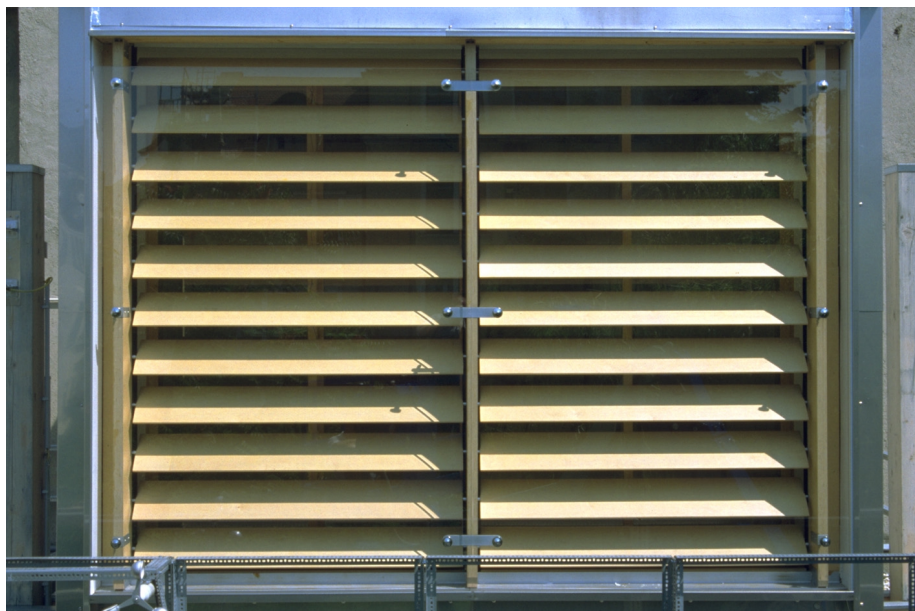
Fig. 40: Holz-Lamellen: beide Segmente geneigt, Außenansicht
