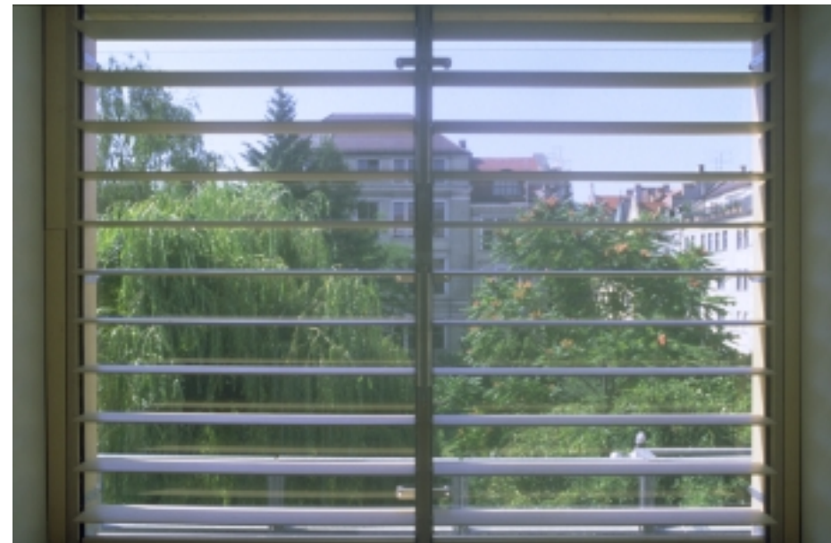
Fig. 21: Holz-Lamelle horizontal, Innenansicht
