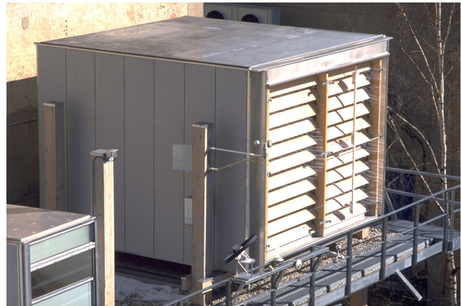
Fig. 3: Testfassade von außen, Holz-Lamellen mit Deckschicht aus Birkensperrrholz
