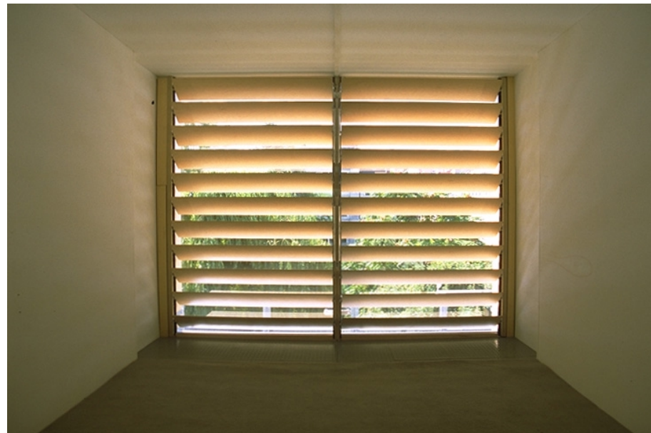
Fig. 35: Holz-Lamellen leicht geneigt, Innenansicht
