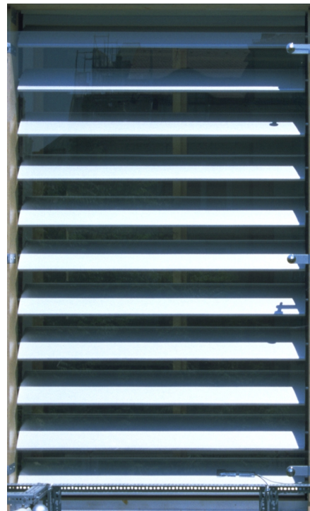
Fig. 29: Alu-Lamellen geneigt, Außenansicht
