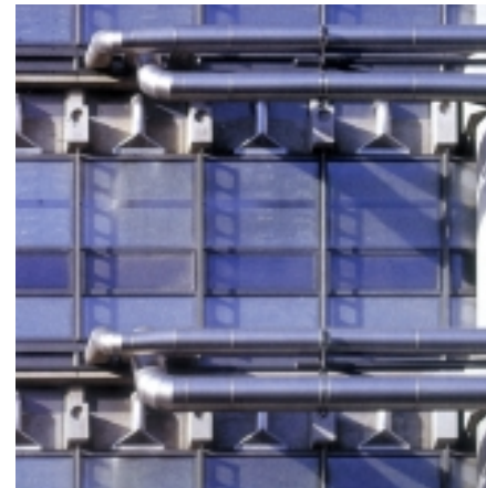
Fig. 7: Abluftfassade Lloyds Versicherung, London 1986 [3] Arch.: Lord Richard Rogers + Partner
