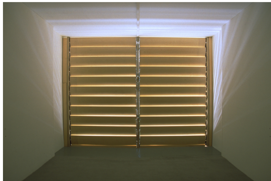
Fig. 37: Holz-Lamellen geschlossen, Innenansicht
