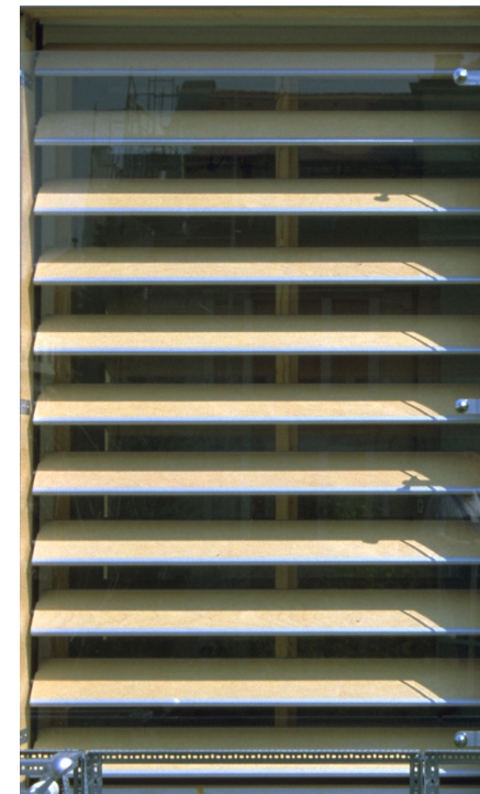
Fig. 30: Holz-Alu-Lamelle geneigt, Außenansicht
