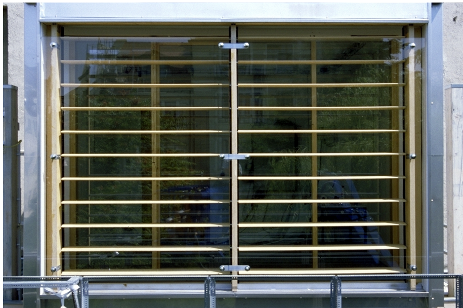
Fig. 38: Holz-Lamellen horizontal, Außenansicht
