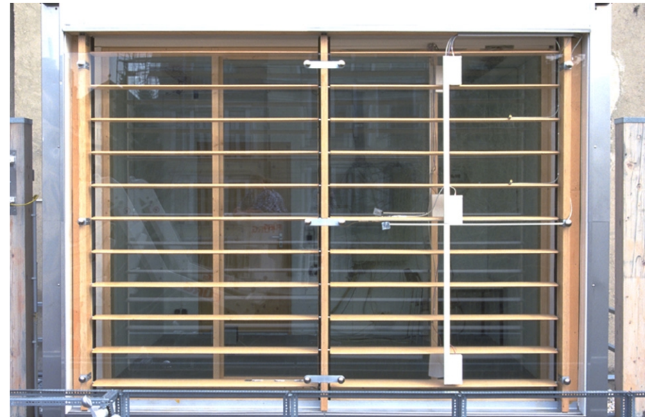
Fig. 11: Frontansicht der Testfassade mit hinterlüfteten Temperaturfühlern
