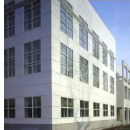
Fig. 3: Abluftfenster Museum für Kunsthandwerk, Frankfurt, 1984 [1] Arch.: Richard Meier
