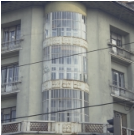
Fig. 5: Erker Wohnhaus in Budapest, H Arch.: unbekannt
