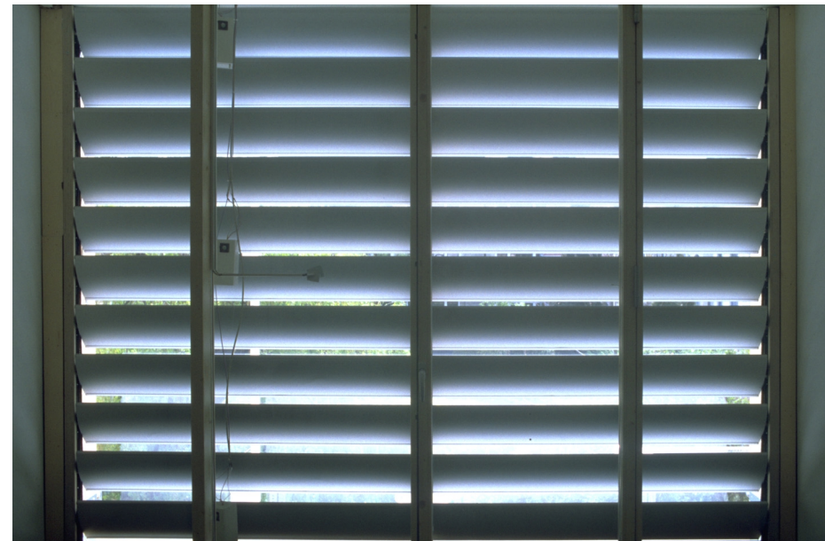
Fig. 32: Alu-Lamelle geneigt, Innenansicht
