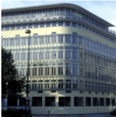
Fig. 9: Unsegmentierte Zweite-Haut-Fassade Verwaltungsgebäude, München, 1997 Arch.: Otto Steidle + Partner
