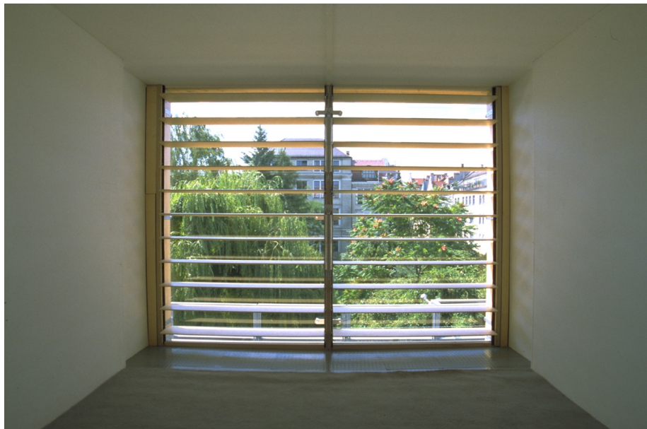
Fig. 34: Holz-Lamellen horizontal, Innenansicht
