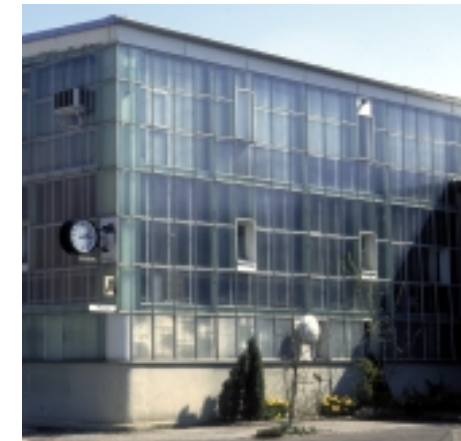
Fig. 8: Pufferfassade Steiff Fabrik, Giengen/Brenz, 1903 Planung: Friedrich und Richard Steiff (?)
